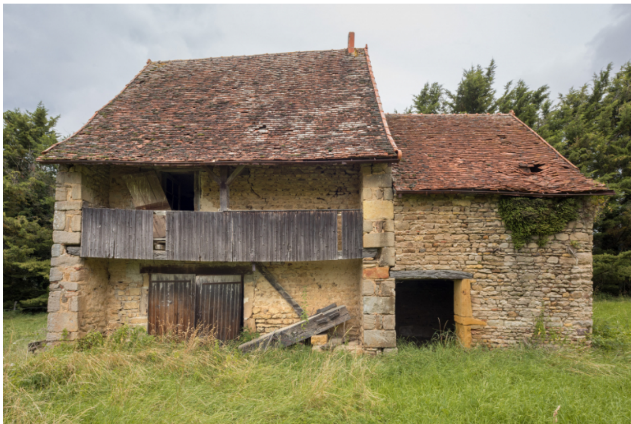
Vue frontale de la ferme. Rachetée par le baron du Marais au début du XXe siècle, cette ferme a connu des modifications, telle l'agrandissement de l'ouverture au rez-de-chaussée de l'habitation, suite à la transformation de l'ancienne cuisine en remise. 71, Oyé, lieudit : Chaumont
