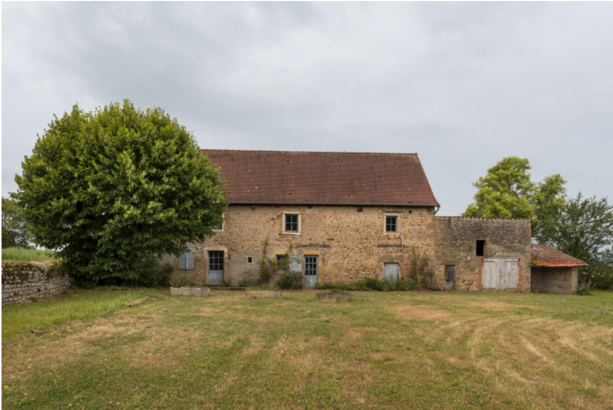
Vue de la façade antérieure de la maison
