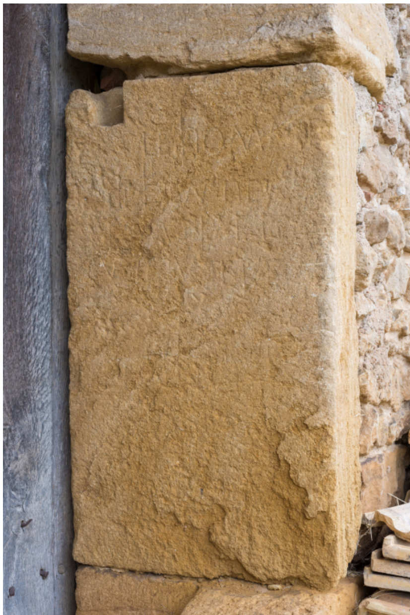
Pierre dans l'encadrement de la porte charretière de la remise portant des inscriptions gravées.
