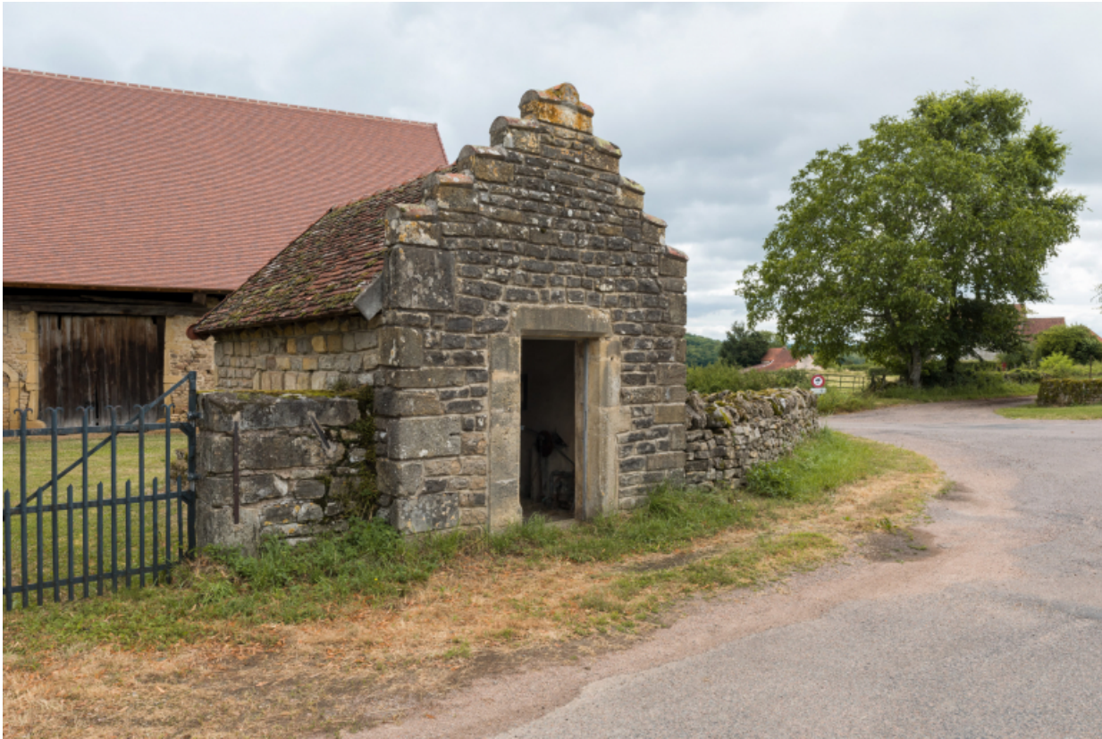
Vue de la façade du bâtiment de pompage avec son pignon à redents.
