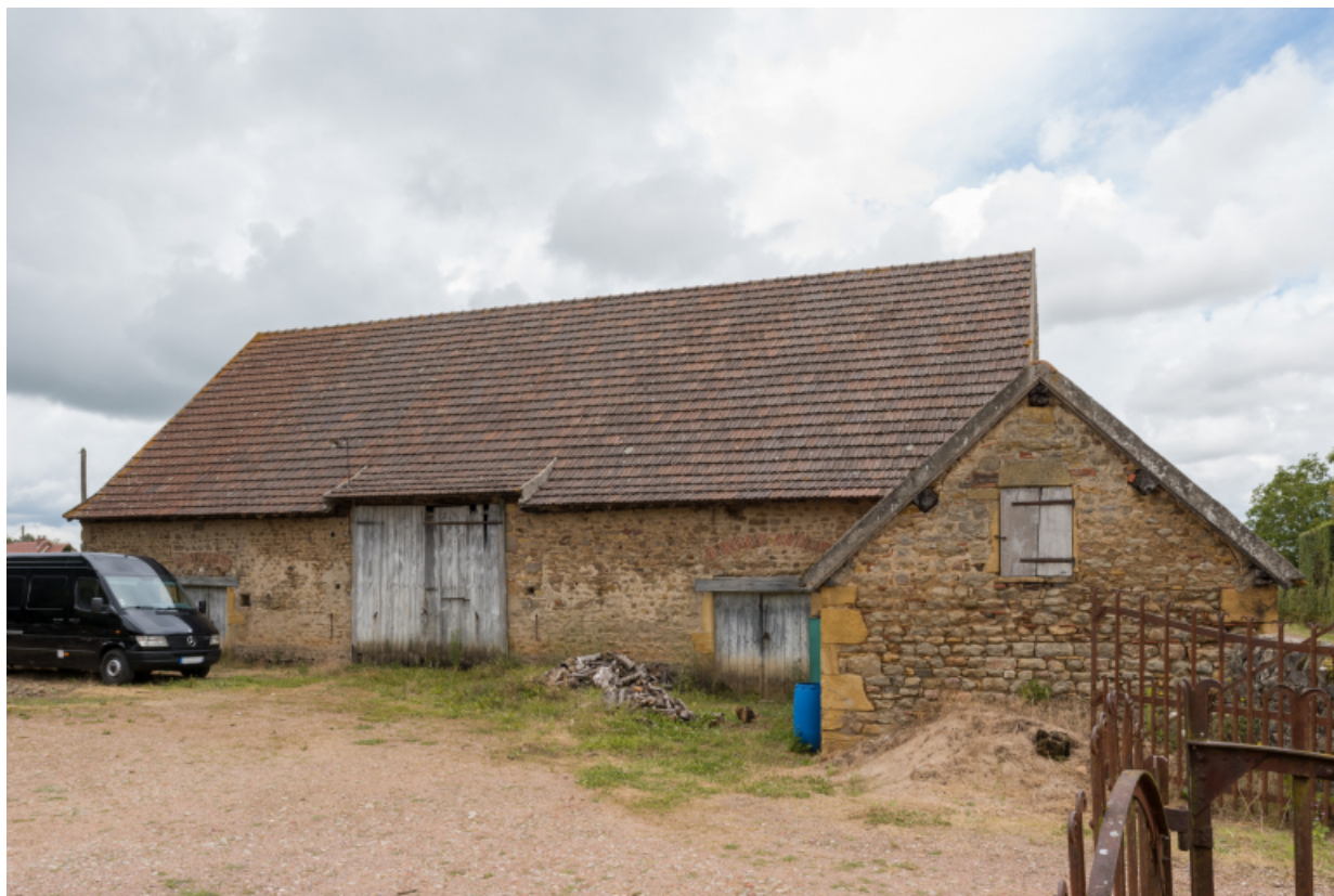
Dépendance d'une des fermes dépendantes du château, à l'ouest de celui-ci, ayant abrité un cuvage. 71, Oyé, lieudit : Chaumont
