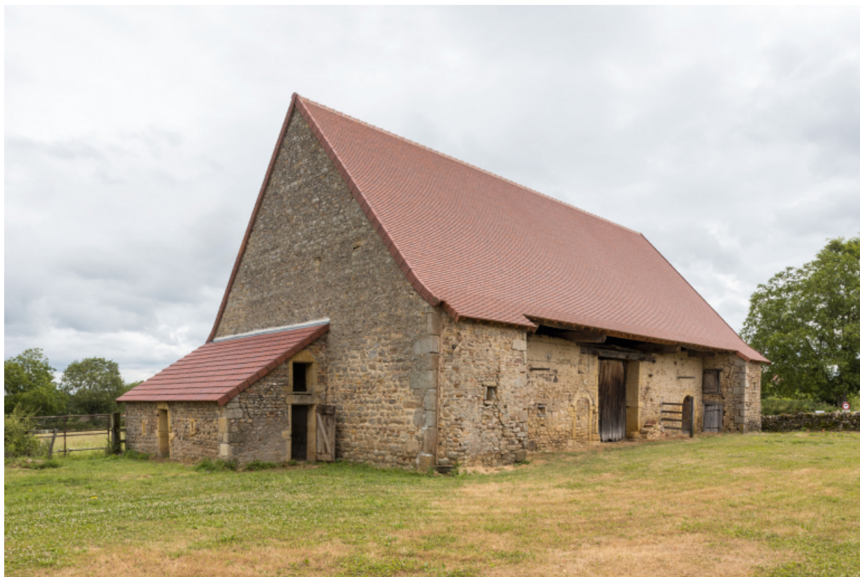
Vue de la grange, depuis l'ouest
