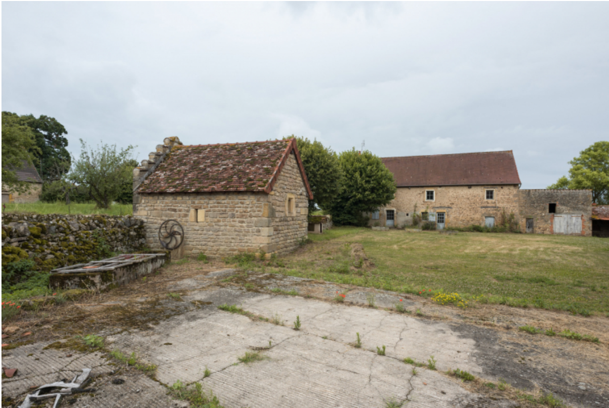
Vue de la maison et du bâtiment de pompage.
