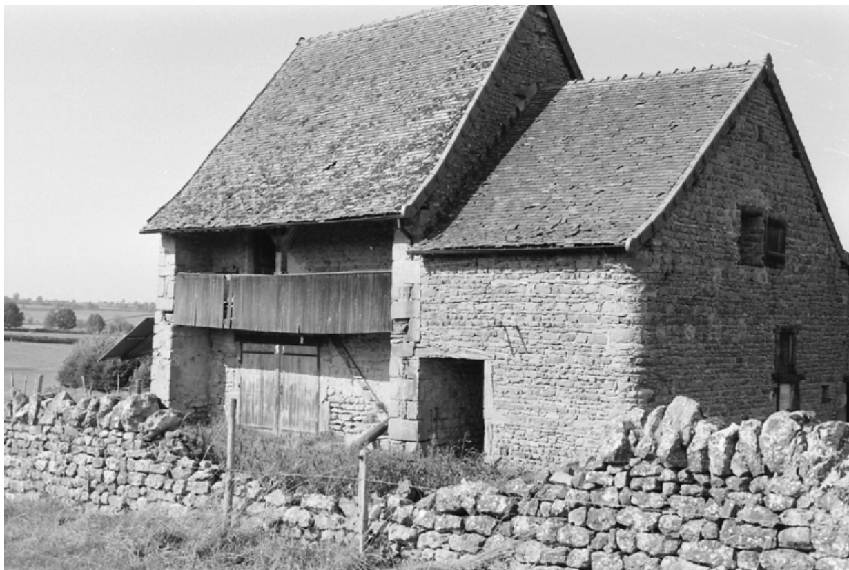
Maison à galerie, avec sa remise, à Chaumont, vers 1970.
