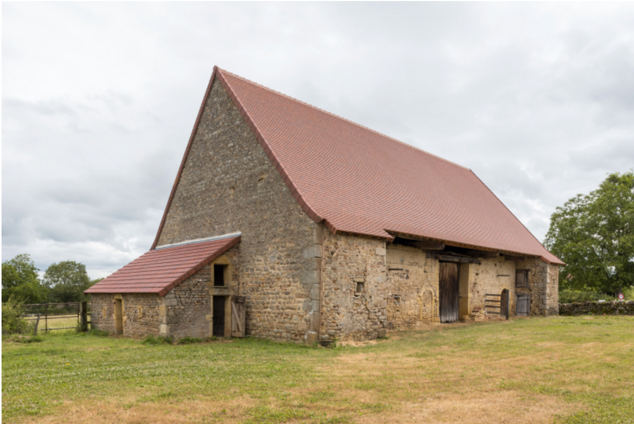
Vue de la grange, depuis l'ouest
