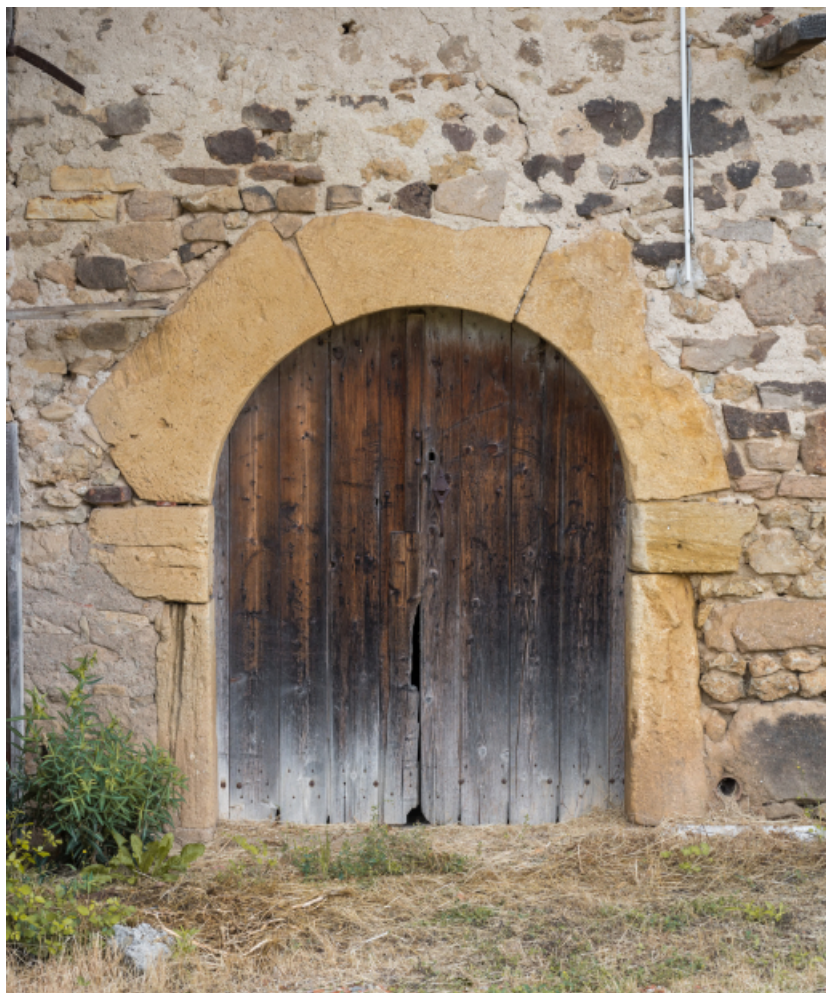
Détail de la façade antérieure de la grange : porte de l'étable double, à gauche de la remise. 71, Oyé, lieudit : Chaumont
