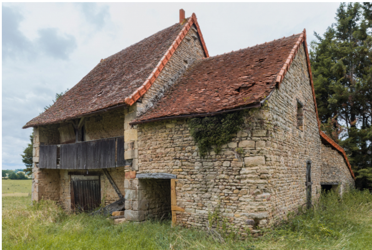
Vue de la ferme, depuis l'est.
