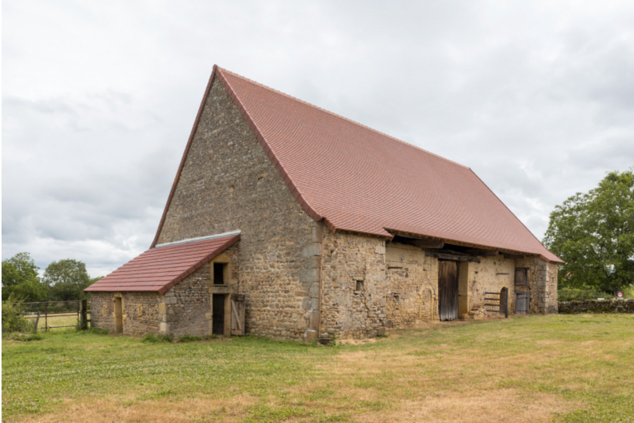
Vue de la grange, depuis l'ouest
