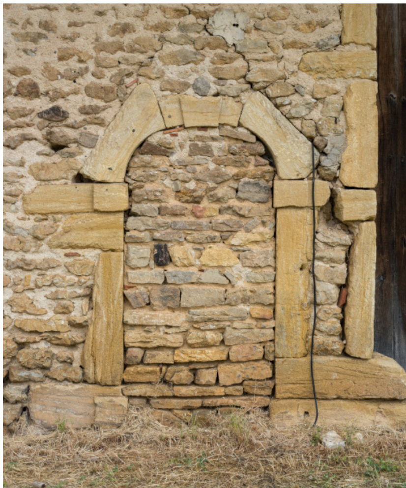
Détail de la façade antérieure de la grange : ancienne porte piétonnière bouchée à côté de la porte charretière de la remise. Les impostes, qui couronne les piedroits, et l'agrafe sur la clef de l'arc en plein cintre offrent un sobre décor.
