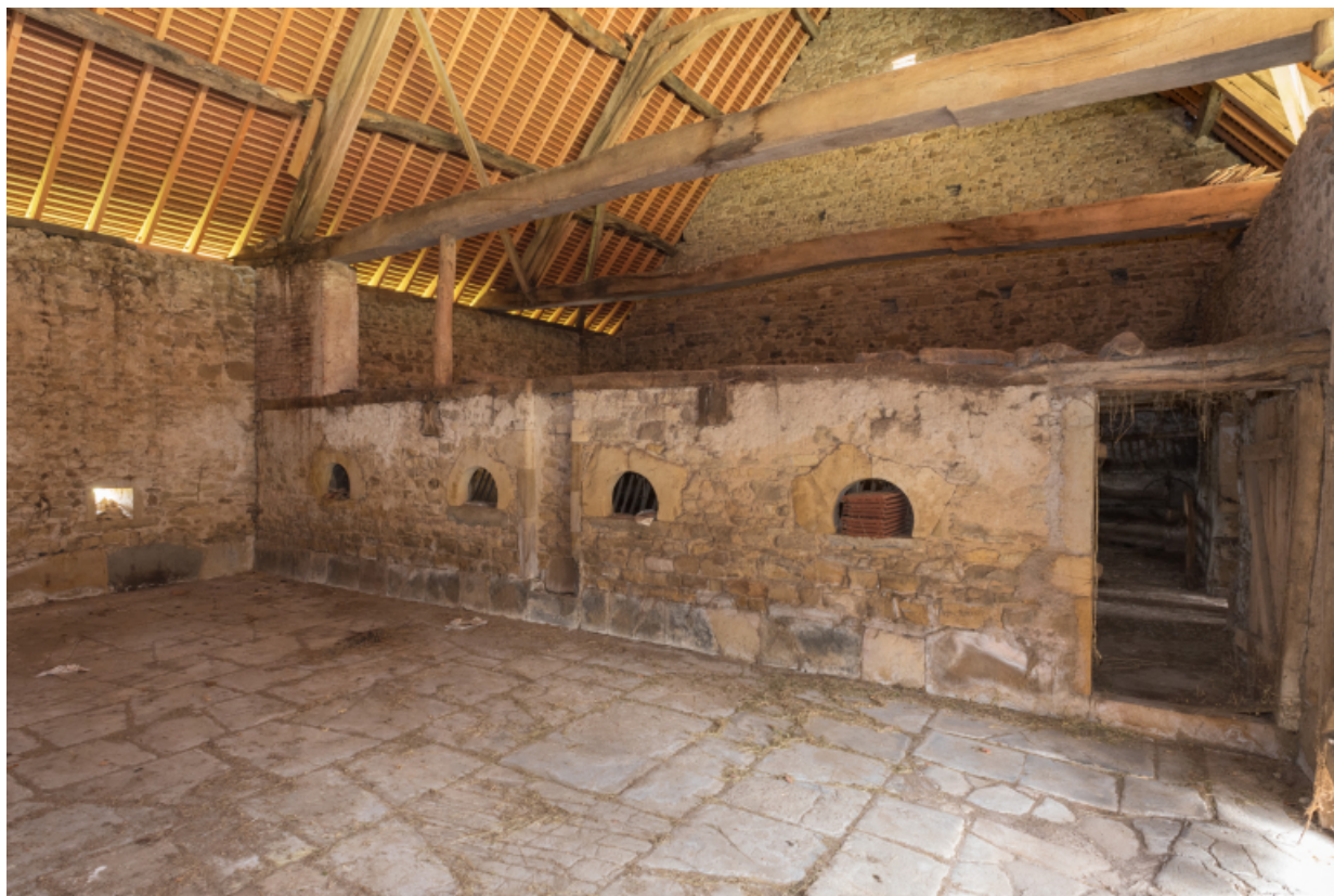
Vue intérieure de la remise du char à foin, avec ses murs percés de feurons.
