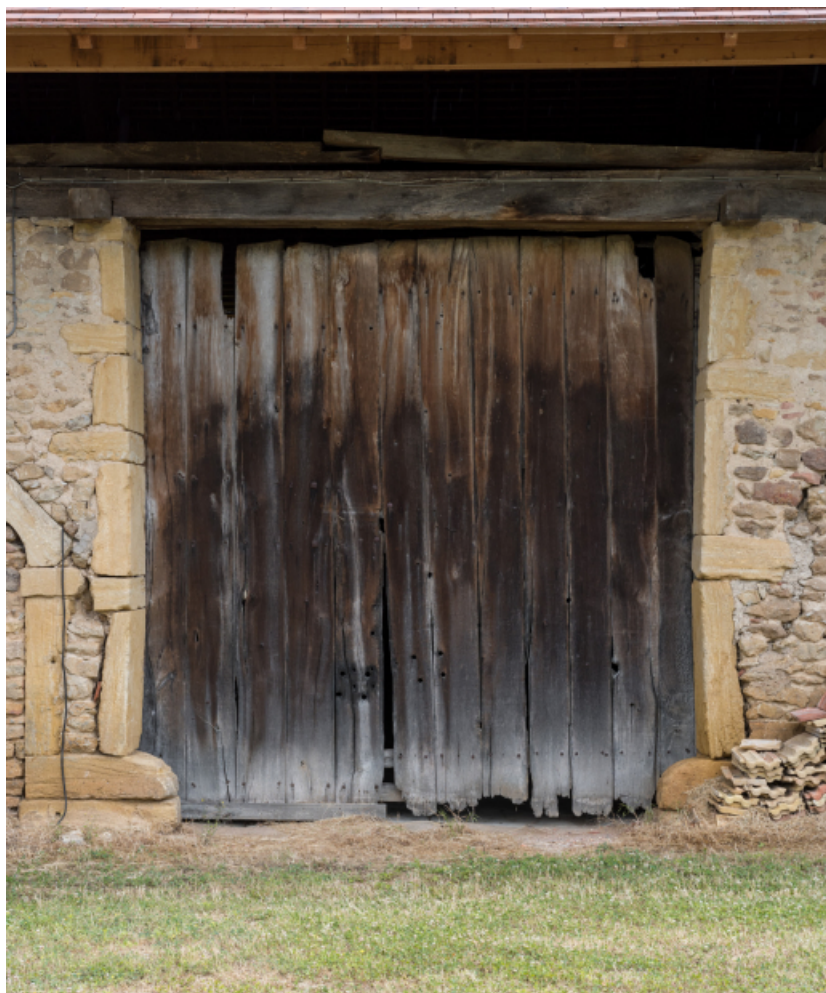
Détail de la façade antérieure de la grange : porte charretière de la remise 71, Oyé, lieudit : Chaumont
