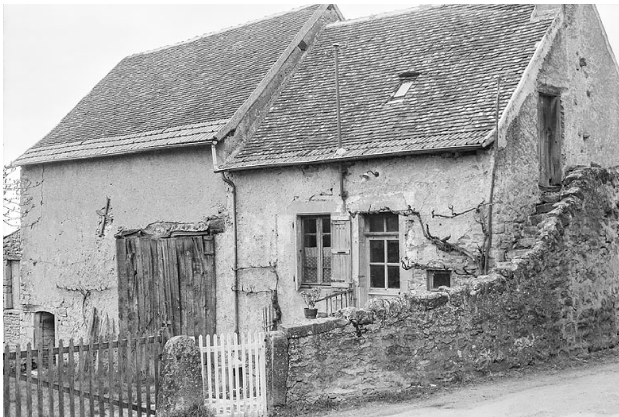
Ferme de polyculture, située dans la partie ouest du hameau.
