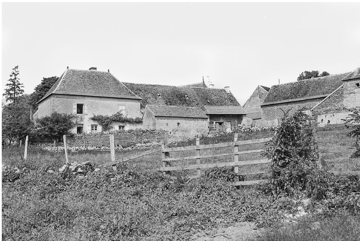
Ferme d'embouche, construite au XIXe siècle, située au coeur du hameau.
