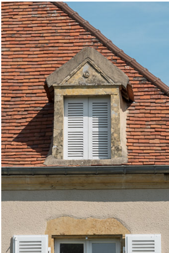
Une des lucarnes du toit de la maison d'emboucheur, dont le fronton est décoré d'une étoile dans un petit médaillon. 71, Changy, lieudit : Tourny
