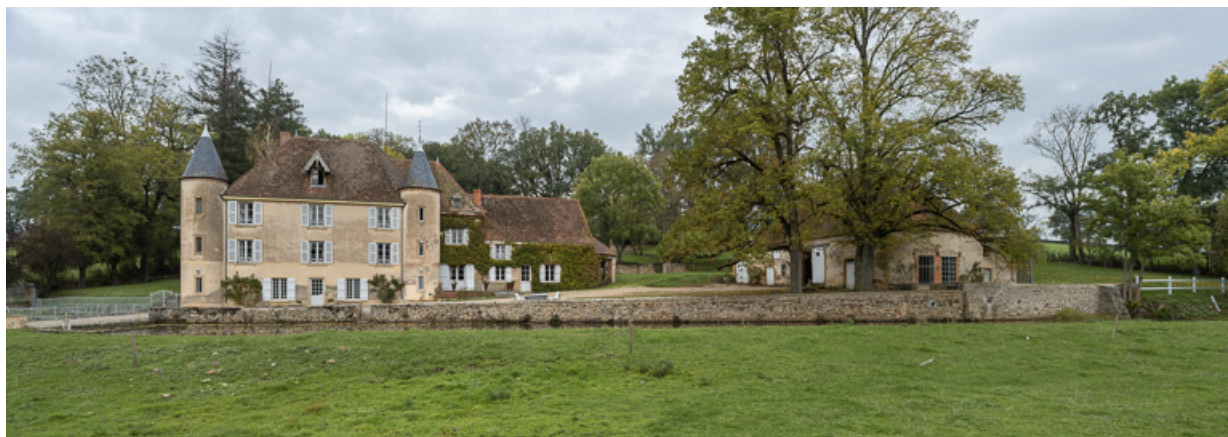
Vue de l'ensemble des bâtiments du domaine : le château, à gauche, et la grange, à droite, partiellement dissimulée par un arbre 71, Sarry, lieudit : Essiat
