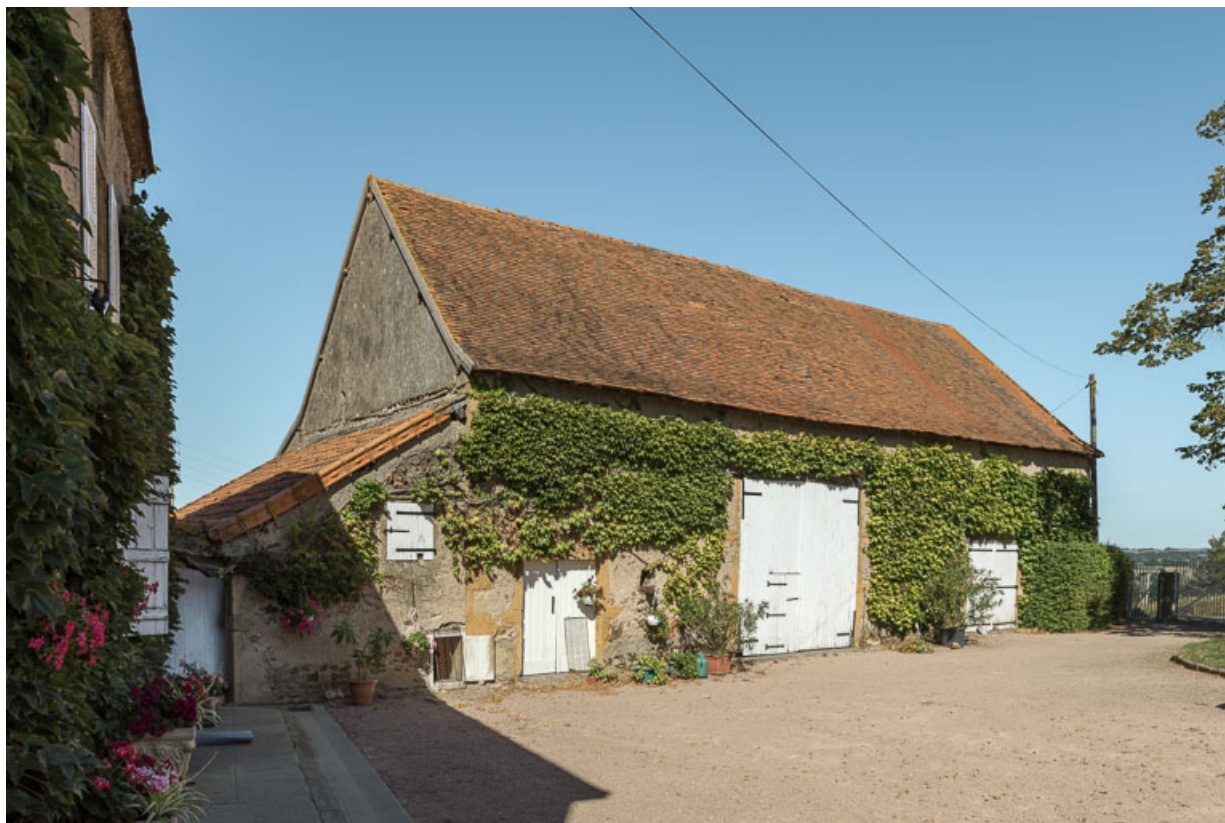
Façade antérieure de la grange
