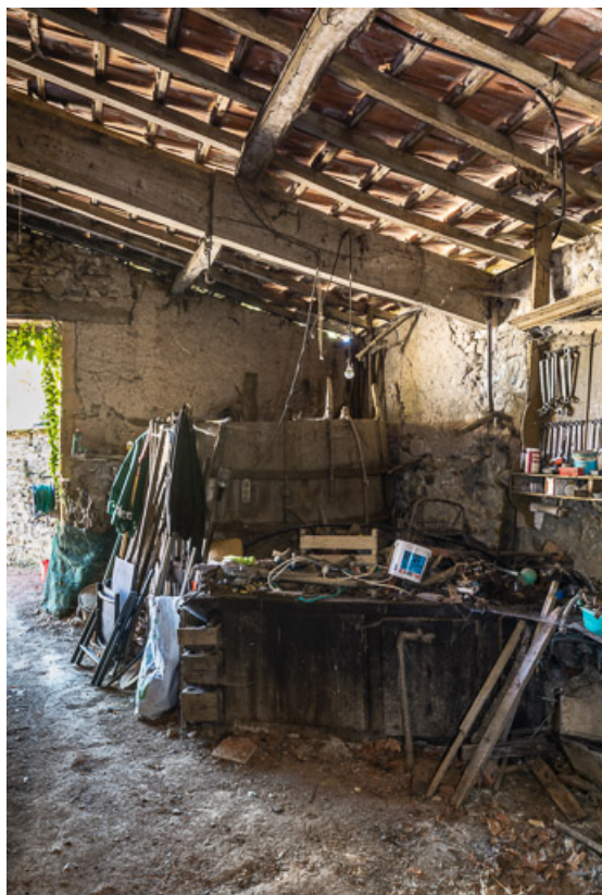
Ancienne cuve à vin, sous l'appentis, contre la façade sud de la maison 71, Sarry, lieudit : Fleury
