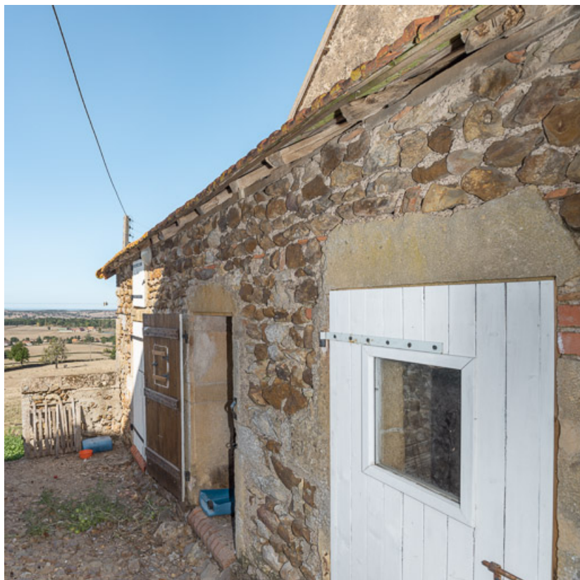
Appentis contre le mur-pignon ouest de la grange abritant des soues à cochons et un pigeonnier dans le comble 71, Sarry, lieudit : Fleury
