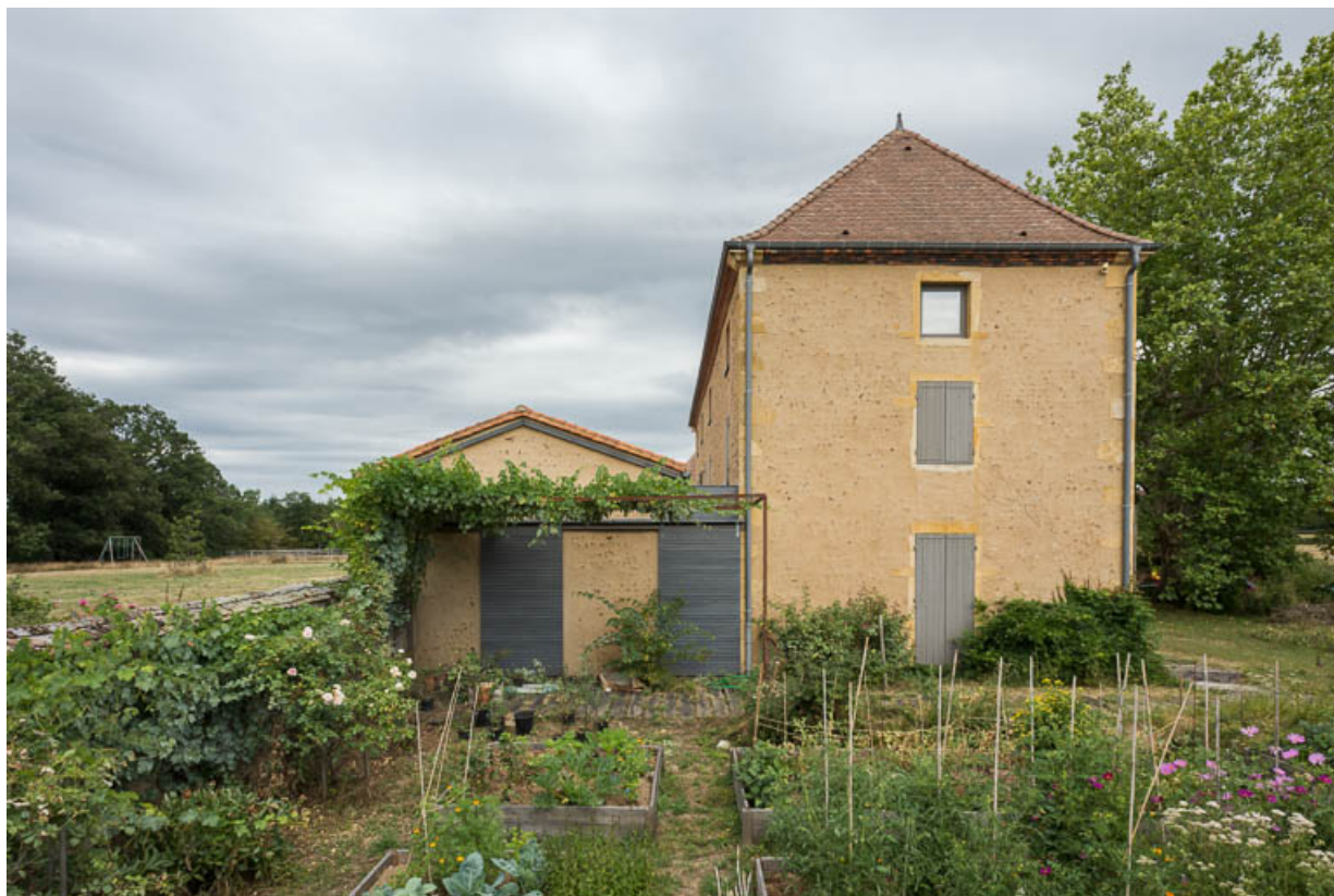
Vue de la façade latérale ouest de la maison, depuis le jardin potager. L'appentis, à l'arrière de la maison, a été rabaissé et couvert d'une petite toiture à deux pans.
