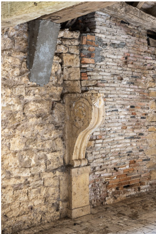
Vestige de la cheminée du second étage de la tour : console à décor de volute et coquille supportant à l'origine le manteau de la cheminée
