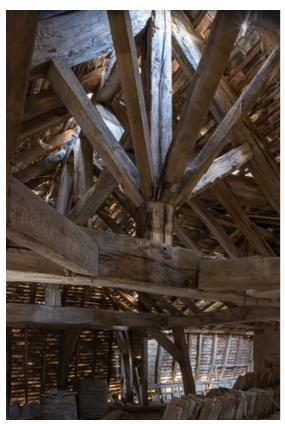
Détail de la charpente : poinçon et contrefiches
