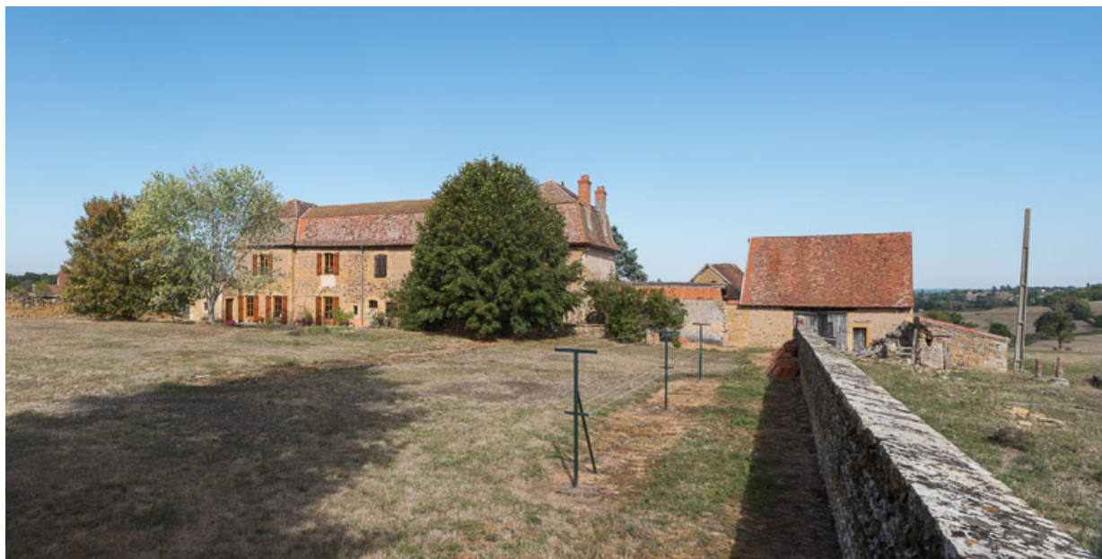
Vue de la demeure (façade postérieure) de la Mollière et de ses dépendances, depuis le jardin.
