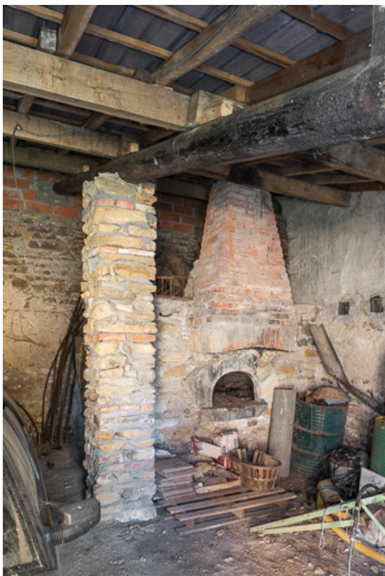
Four à pain du XIXe siècle, contre la façade nord-est de la demeure 71, Anzy-le-Duc, lieudit : La Mollière
