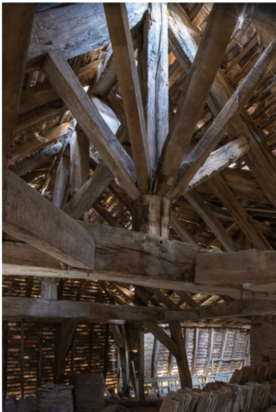
Détail de la charpente : pignon et contrefiches
