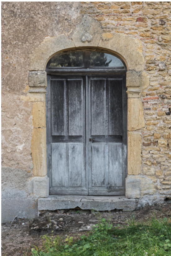
Porte principale de la demeure sur la façade antérieure du bâtiment 71, Anzy-le-Duc, lieudit : La Mollière
