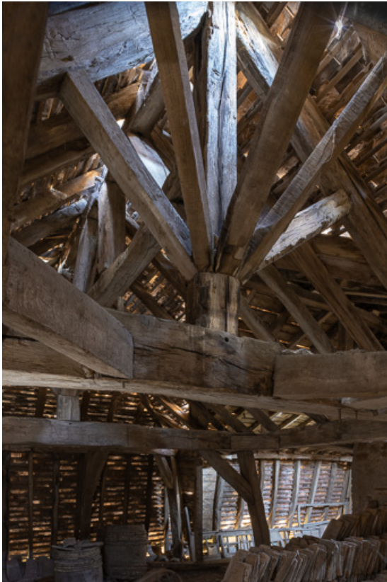
Détail de la charpente : poinçon et contrefiches
