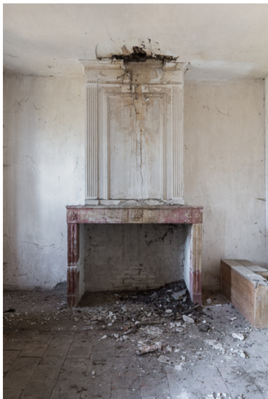
Vue de la cheminée de cette chambre
