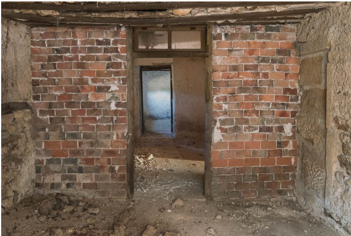
Vue intérieure de l'appentis abritant la bassie (ou arrière-cuisine). Une cloison en briques, ajoutée au XIXe siècle, a amené le bouchage d'une ancienne porte.
