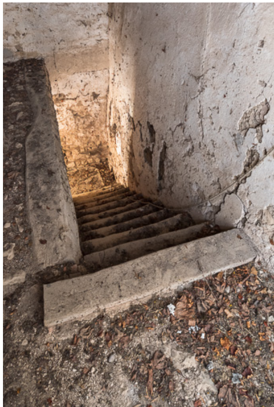
Escalier de l'ancienne maison, à deux volées droites
