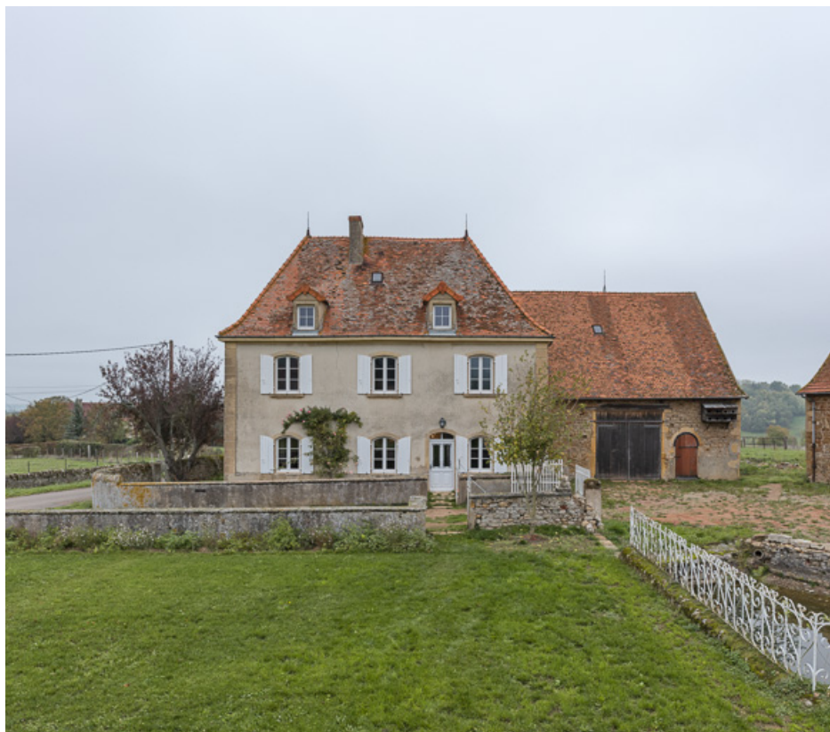
Façade antérieure de la maison et du cuvage (construit contre l'habitation dans le premier quart du XIXe siècle) 71, Briant, lieudit : Farges
