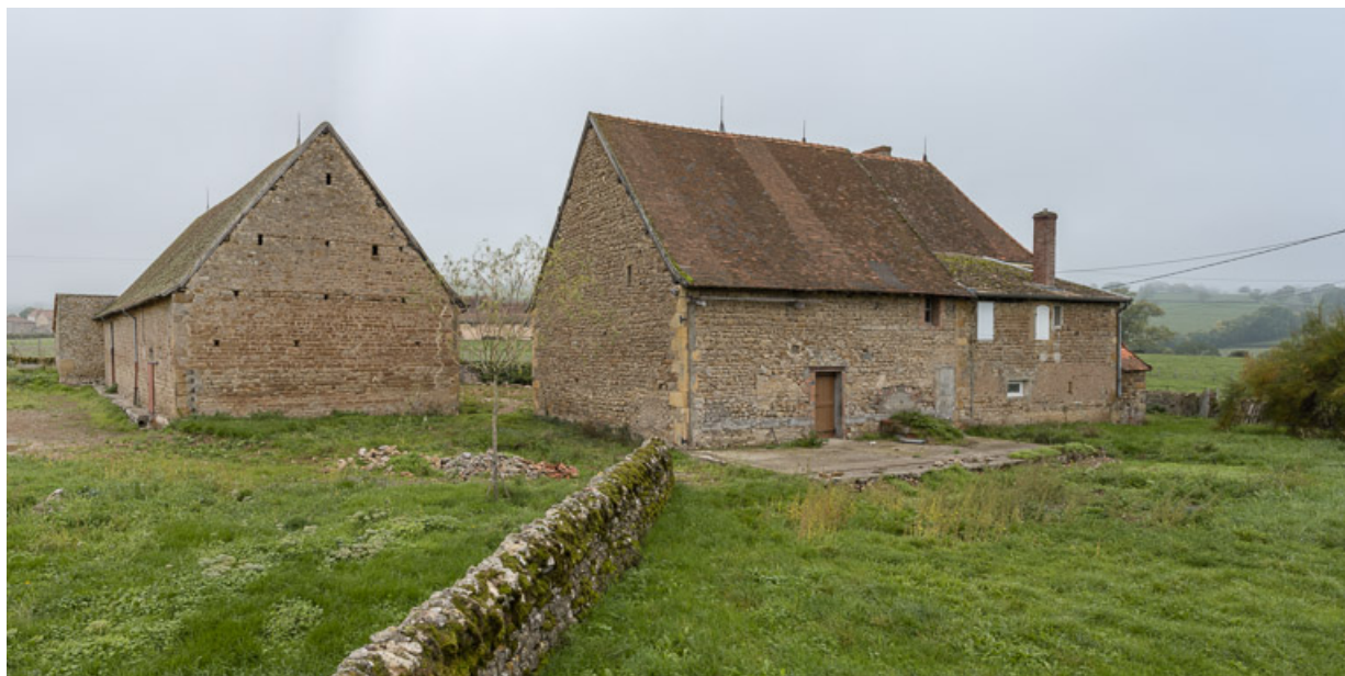
Vue de la façade postérieure de la maison et du cuvage, du mur-pignon nord et de la façade postérieure de la grange. 71, Briant, lieudit : Farges
