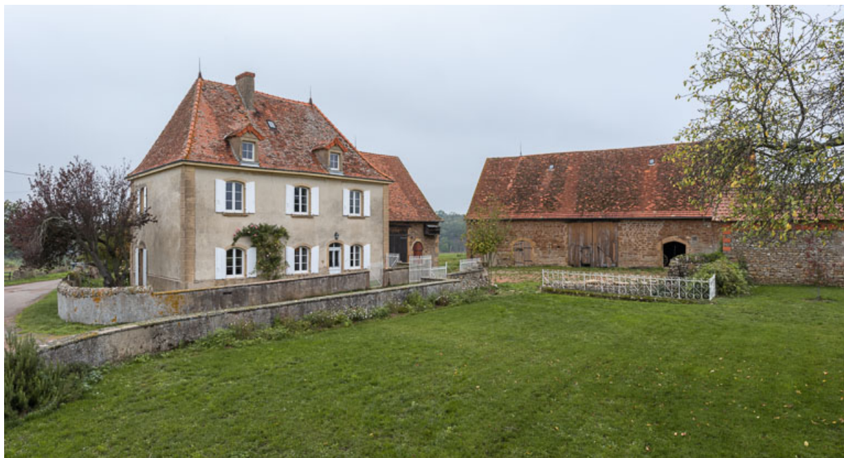
Vue d'ensemble de l'ancienne ferme Bordat à Farges
