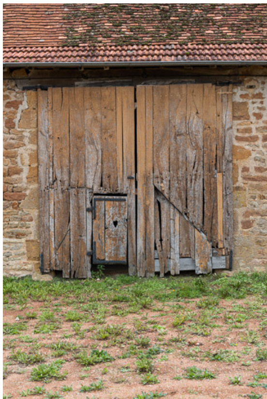
Ouverture principale de la grange : porte de la remise, où était placé le char à foin 71, Briant, lieudit : Farges
