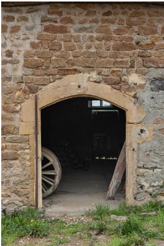
Porte de l'étable à droite de la remise
