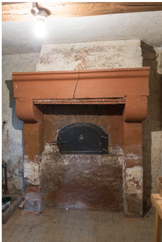
Vue de l'ancien four à pain
