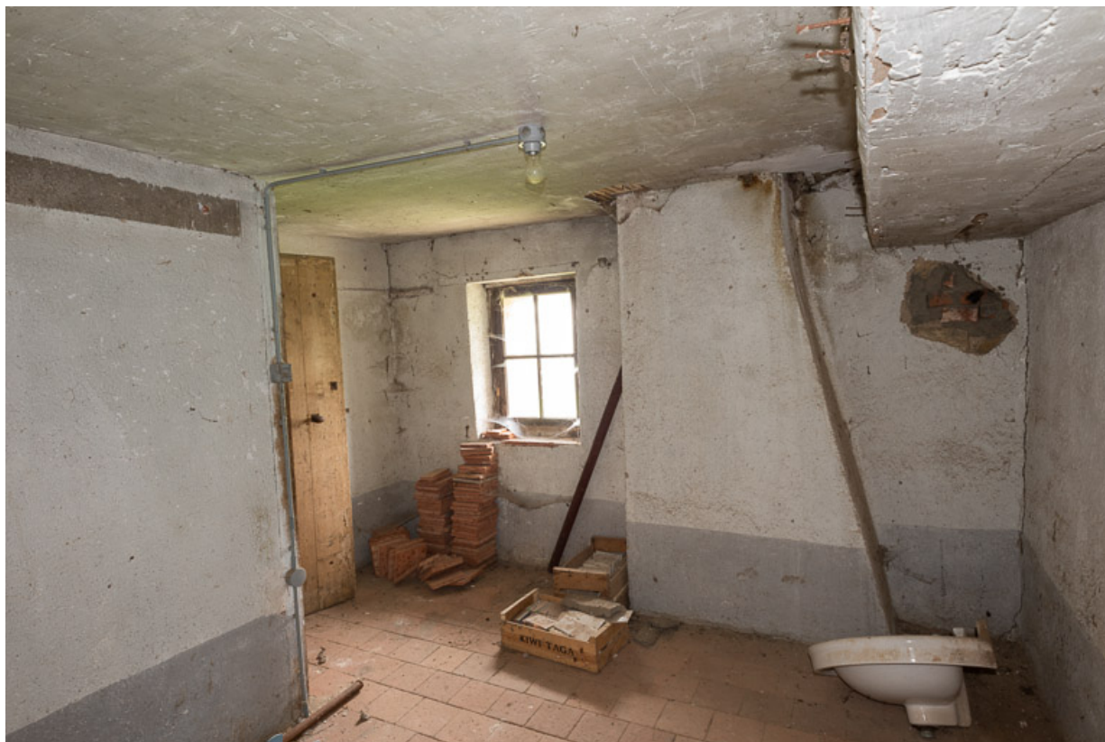
Chambre de domestique au-dessus de la chambre du four à pain (boulangerie) 71, Briant, lieudit : Farges
