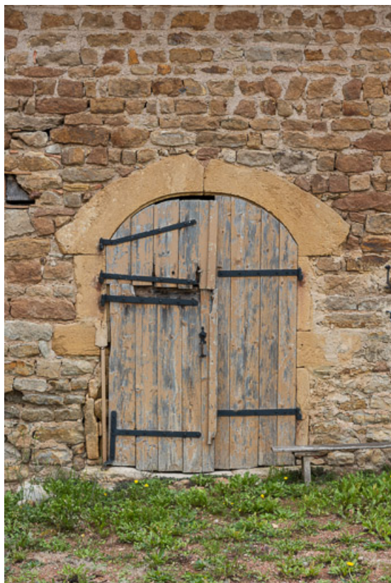
Porte de l'étable à gauche de la remise
