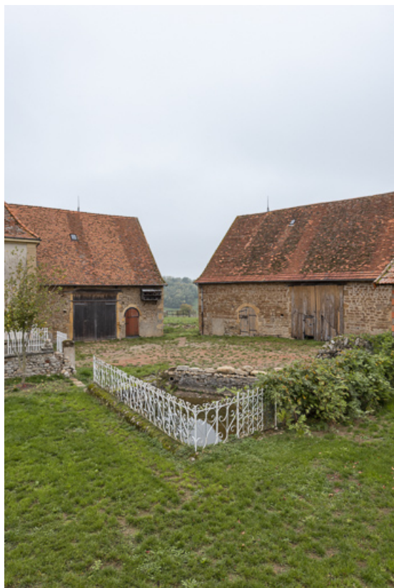
Vue depuis l'angle sud-est de la maison jusqu'à la grange, incluant le cuvage et la mare 71, Briant, lieudit : Farges
