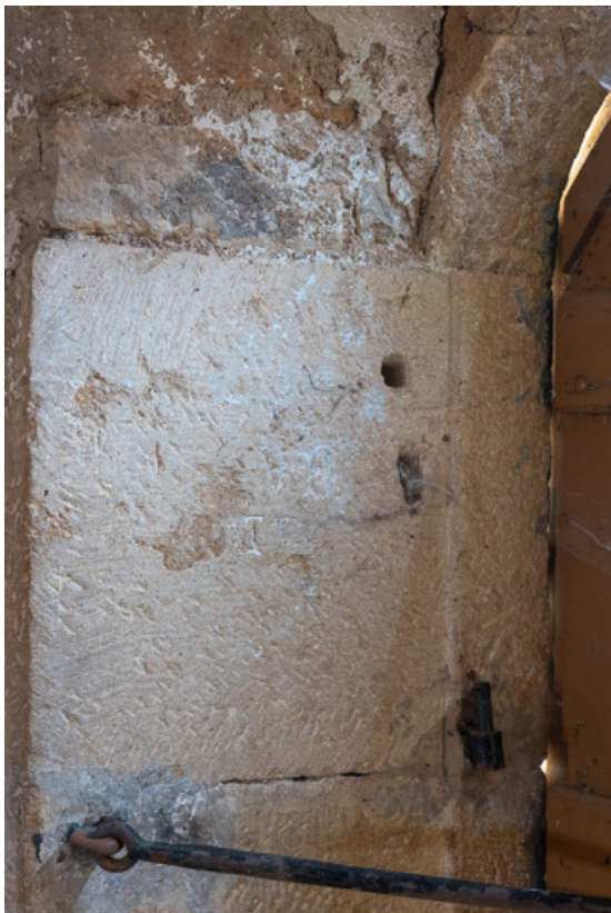
Embrasure de la porte de l'étable à gauche de la remise. L'emplacement des gonds de la porte d'origine est encore visible. 71, Briant, lieudit : Farges
