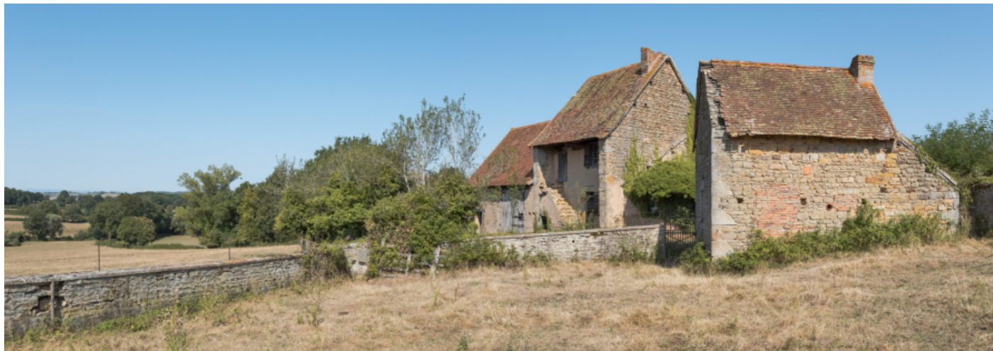
Vue d'ensemble depuis le sud-est des façades antérieures de la maison.
