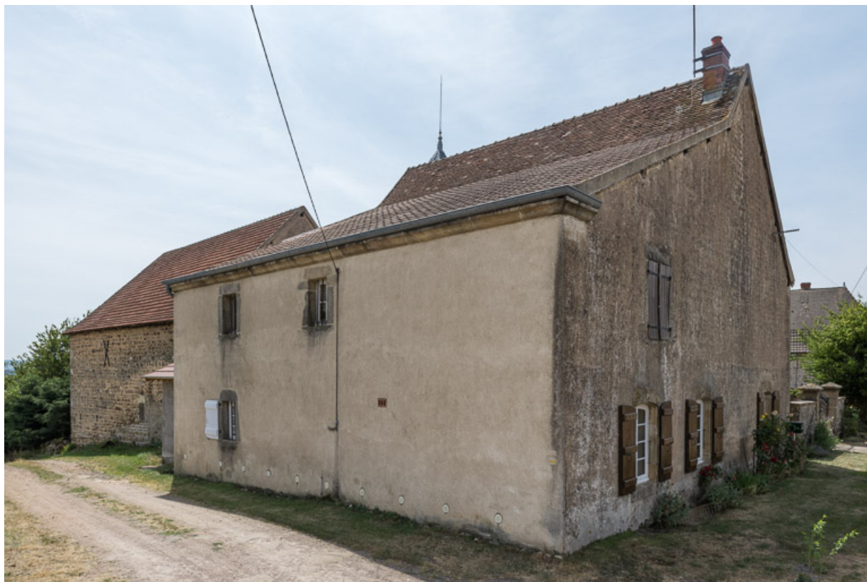
Vue de l'ensemble des façades postérieures des bâtiments et du mur-pignon de l'habitation
