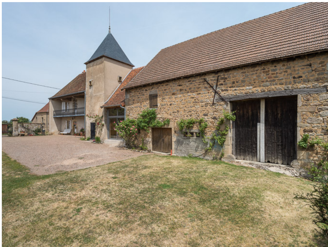
Vue de l'ensemble des façades antérieures des bâtiments de la ferme
