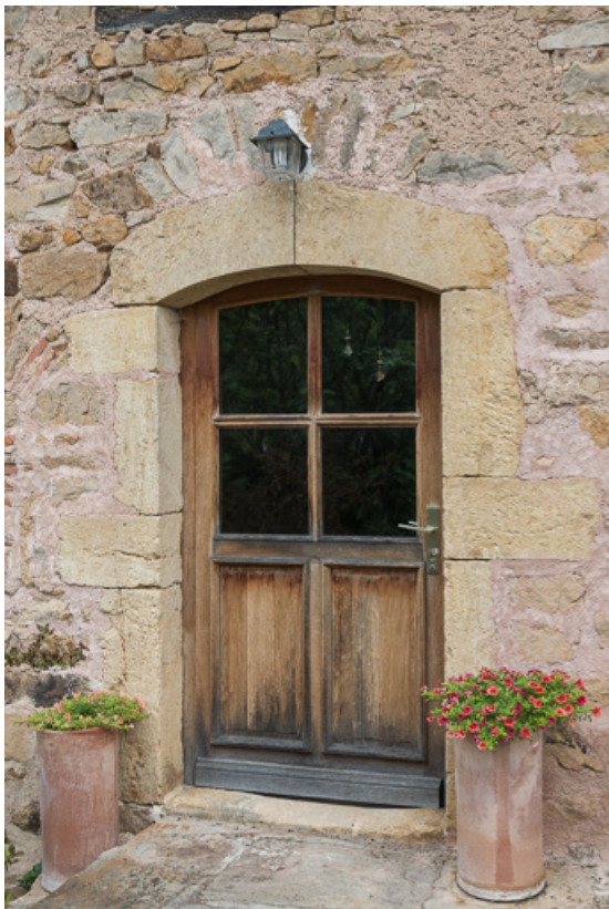
Porte d'entrée de la maison, couverte d'un arc segmentaire 71, Colombier-en-Brionnais, 55 route de Frâgne, lieudit : Frâgne
