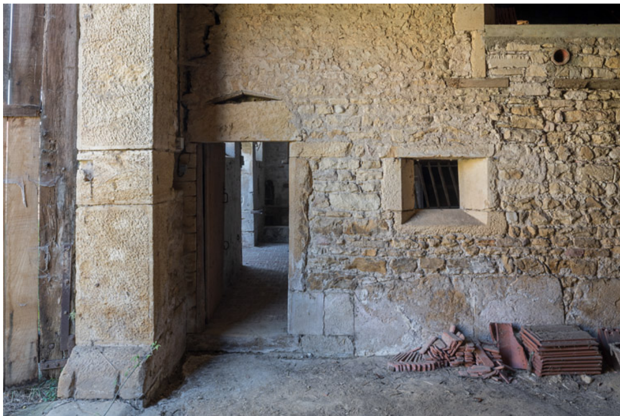
Intérieur de la remise, à côté de l'étable, présentant un des piédroits de l'ouverture de la porte (avec son chasse-roue) et une partie du mur mitoyen avec l'étable percé d'une porte et de feurons.
