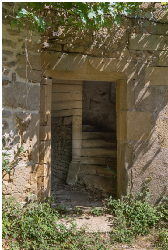
Vue de l'escalier à vis et de sa porte d'accès, avec son linteau orné d'une accolade 71, Saint-Julien-de-Civry, lieudit : Maringue
