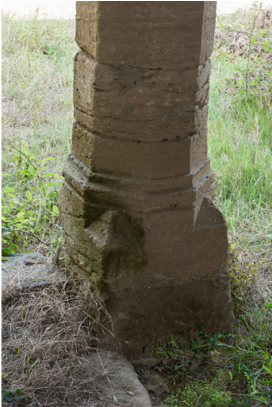
Une des poutres du plancher du fenil est soutenu par ce pilier hexagonal, avec une base moulurée, utilisé en emploi. 71, Saint-Julien-de-Civry, lieudit : Maringue
