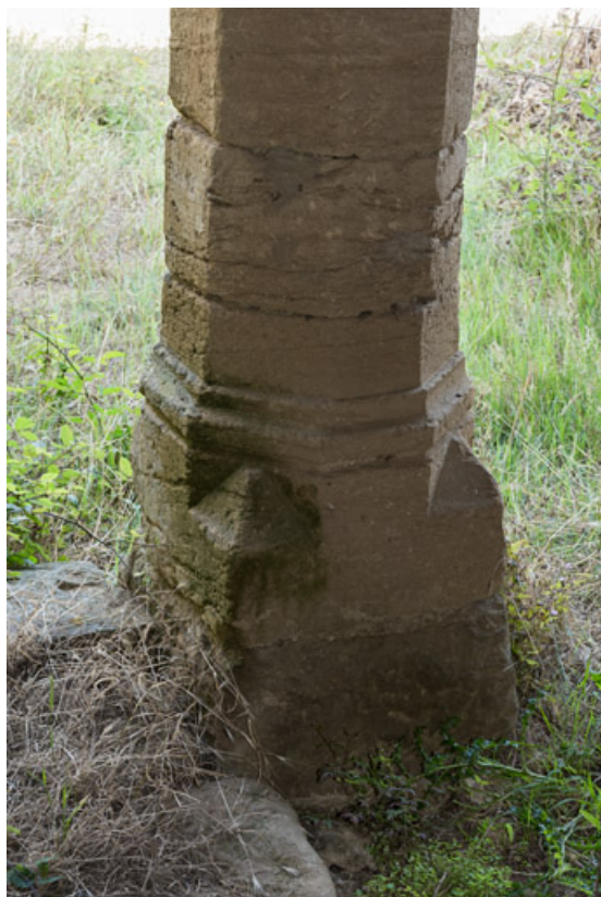
Une des poutres du plancher du fenil est soutenu par ce pilier hexagonal, avec une base moulurée, utilisé en remploi. 71, Saint-Julien-de-Civry, lieudit : Maringue
