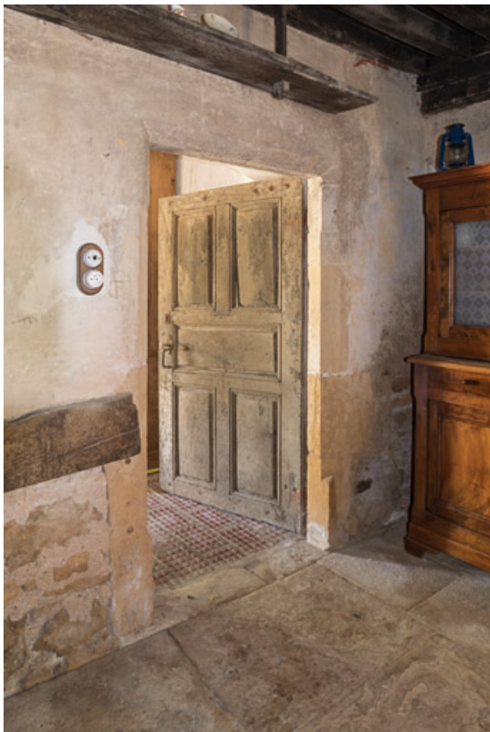
Porte au rez-de-chaussée de la demeure, entre la cuisine et une chambre. Son encadrement présente un chanfrein (angle abattu) qui se retrouve sur de nombreuses baies au rez-de-chaussée, comme à l'étage de l'habitation.
