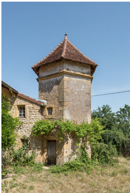
Vue de la tour hexagonale abritant un escalier à vis et, au sommet, un pigeonnier.
