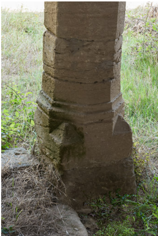
Une des poutres du plancher du fenil est soutenu par ce pilier hexagonal, avec une base moulurée, utilisé en remploi. 71, Saint-Julien-de-Civry, lieudit : Maringue
