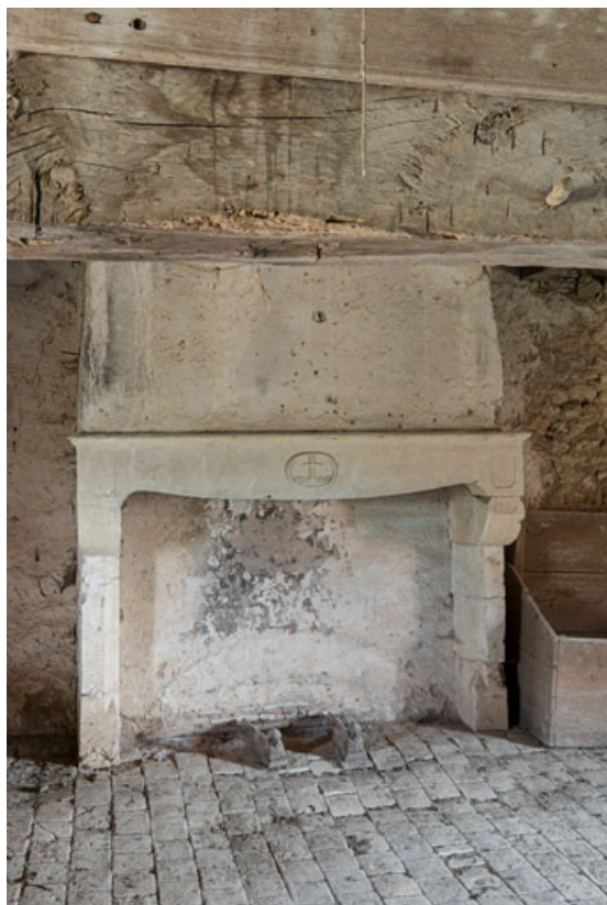
Cheminée dans une chambre, à l'étage de la demeure
