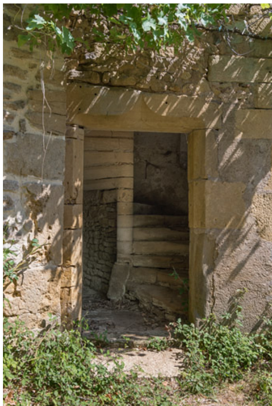
Vue de l'escalier à vis et de sa porte d'accès, avec son linteau orné d'une accolade 71, Saint-Julien-de-Civry, lieudit : Maringue
