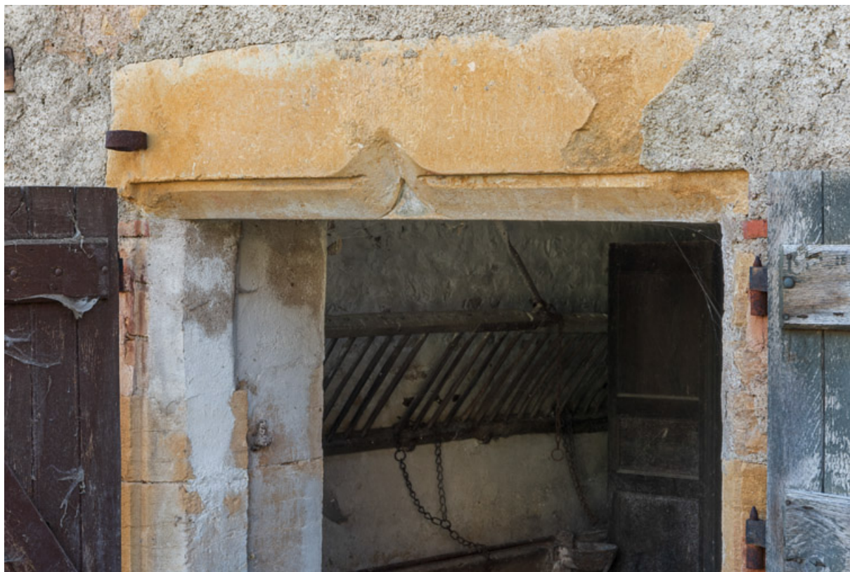
Porte de l'étable double. Le bâtiment étant vraisemblablement plus récent que l'habitation, le linteau avec son accolade est probablement ici un remploi.
