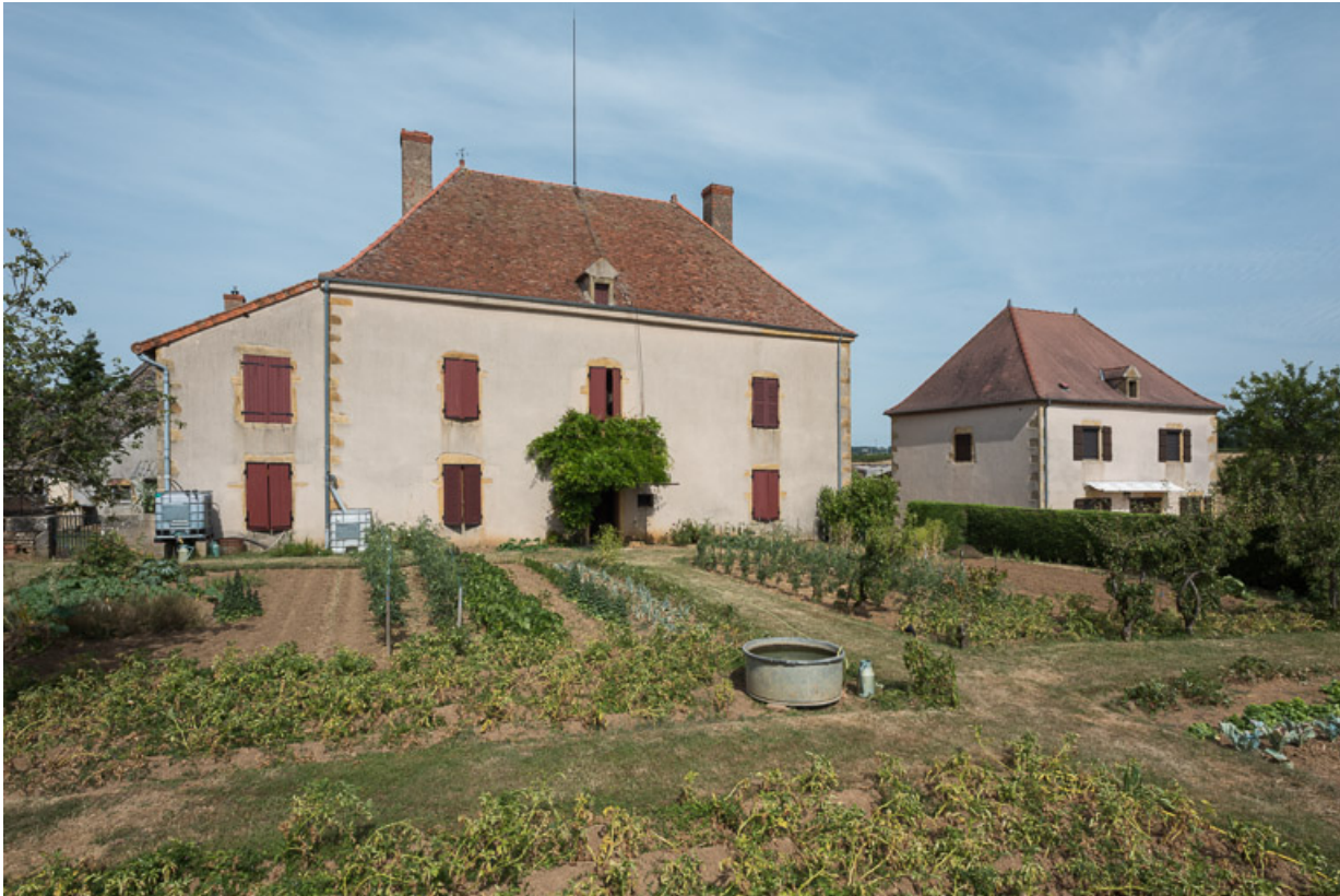
Façade postérieure de la demeure avec le jardin potager. A droite, une seconde maison a été construite dans la deuxième moitié du XIXe siècle, probablement pour abriter les fermiers en charge de l'exploitation du domaine.
