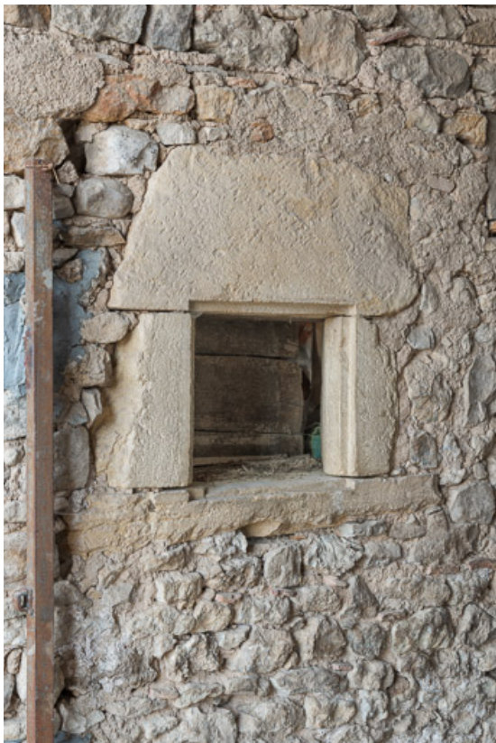
Feuron percé dans le mur entre la remise et l'étable 71, Briant, lieudit : Haut de Rouy
