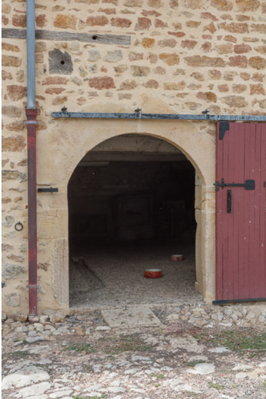
Ouverture d'une étable à bovins, couverte d'un arc en plein cintre 71, Briant, lieudit : Haut de Rouy
