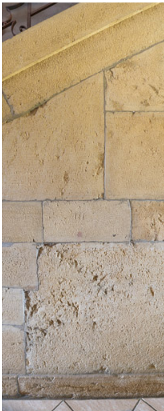
Mur d'échiffre de l'escalier, dont la maçonnerie est faite de pierre de remploi 71, Briant, lieudit : Haut de Rouy
