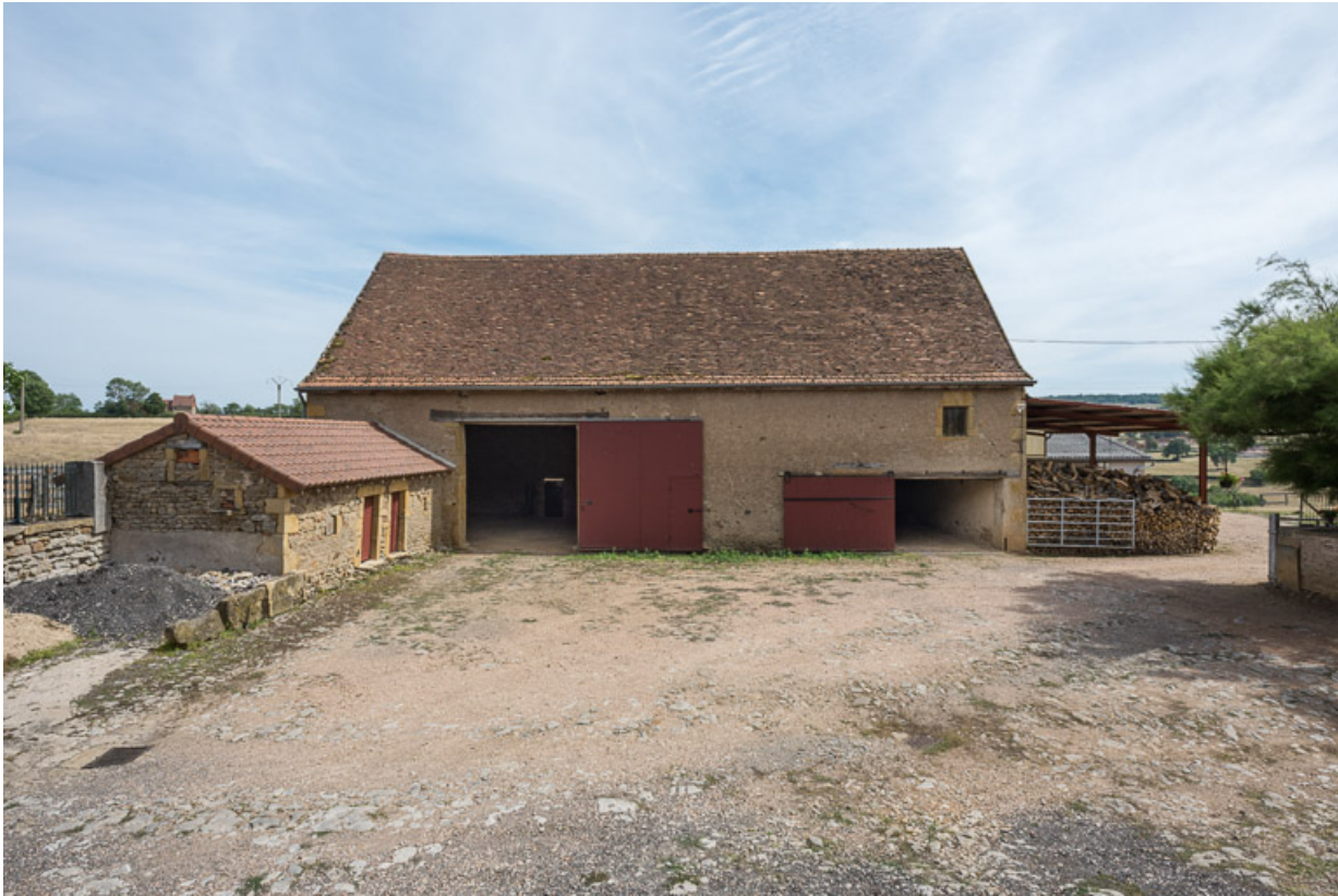
Vue du bâtiment du cuvage, au sud de la cour. A gauche, la petite aile en retour d'équerre, a été ajoutée au XIXe siècle et abritait les soues à cochons.
