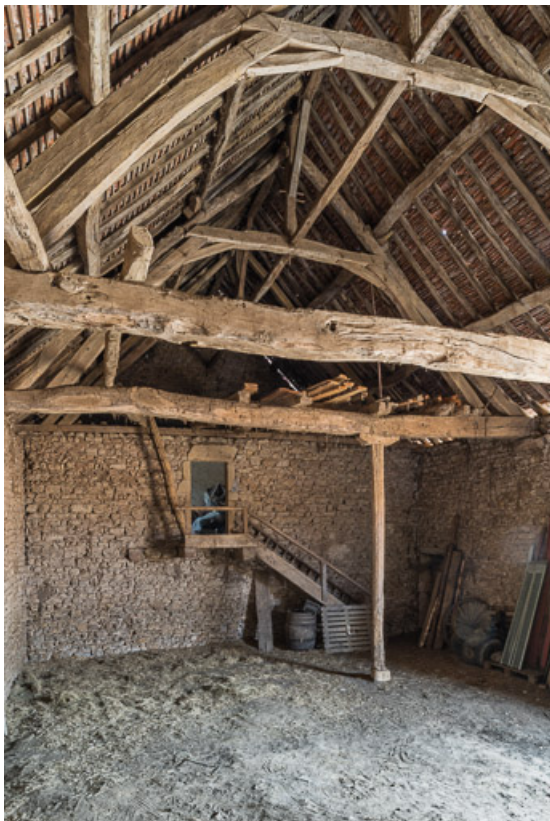
Vue intérieure du cuvage : escalier permettant l'accès à un grenier, situé dans le même bâtiment. 71, Briant, lieudit : Haut de Rouy
