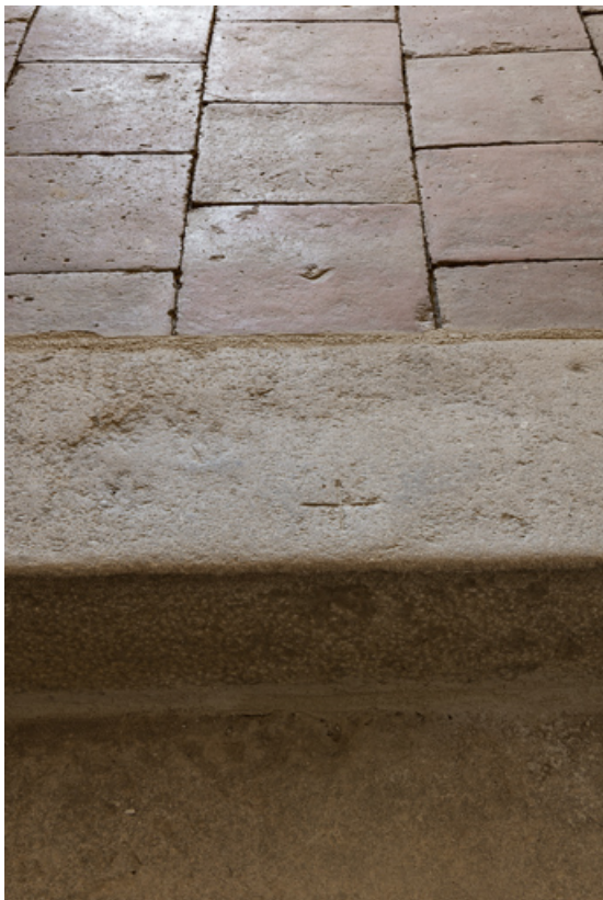
Détail de l'escalier : Marche et palier couvert de carreaux de carrelage en terre cuite 71, Ligny-en-Brionnais, lieudit : les Sertines
