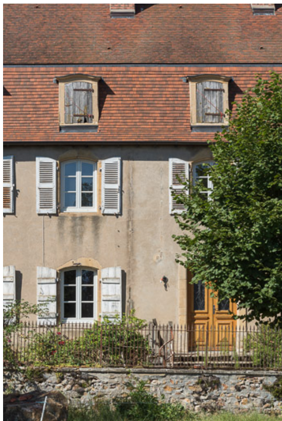
Détail de la façade antérieure de la demeure : baies en arc fragmentaire, orné d'une agrafe, et lucarnes 71, Ligny-en-Brionnais, lieudit : les Sertines
