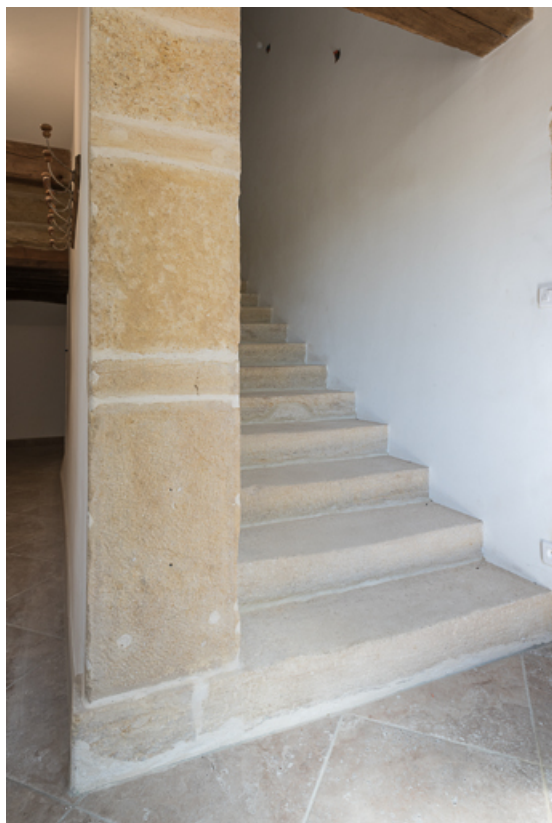
Vue de l'escalier rampe sur rampe de la demeure
