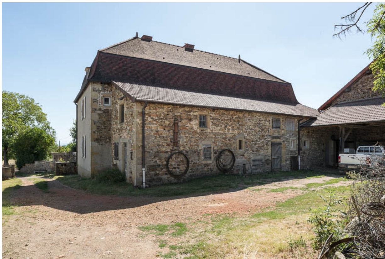
Vue de la façade postérieure de la demeure, avec son appentis
