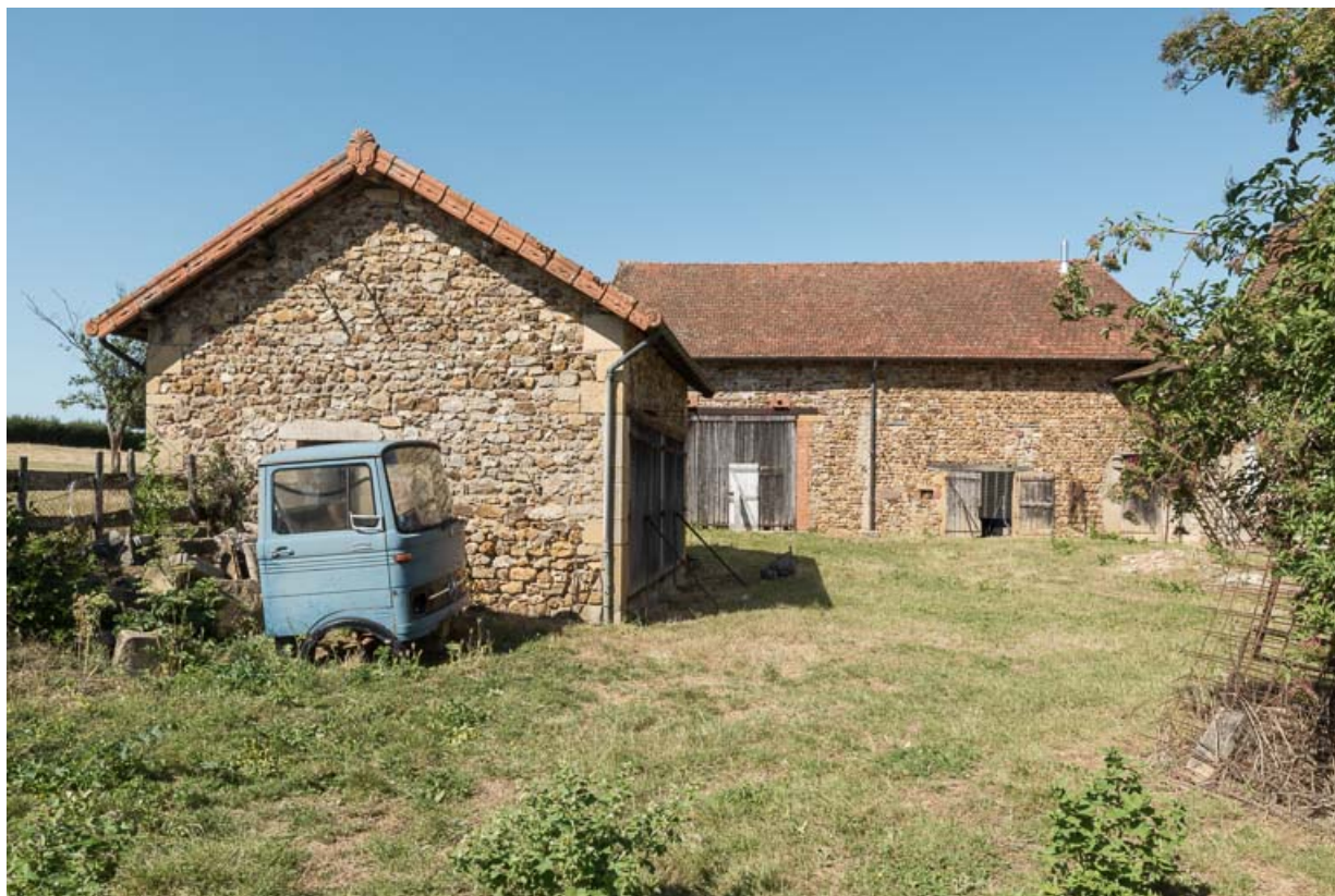
Vue des dépendances composées d'une petite remise, au premier plan, et d'une grange, à l'arrière.
