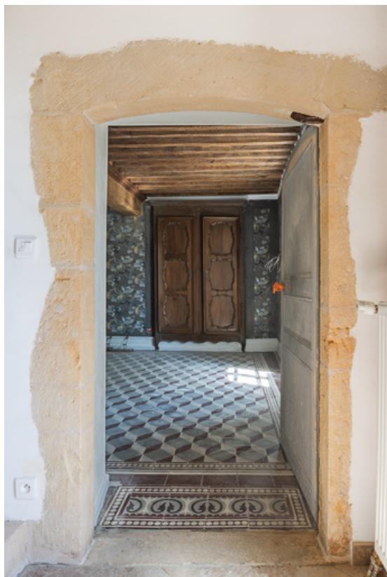
Porte en arc fragmentaire, donnant accès à un salon, à droite de l'escalier de la demeure 71, Ligny-en-Brionnais, lieudit : les Sertines
