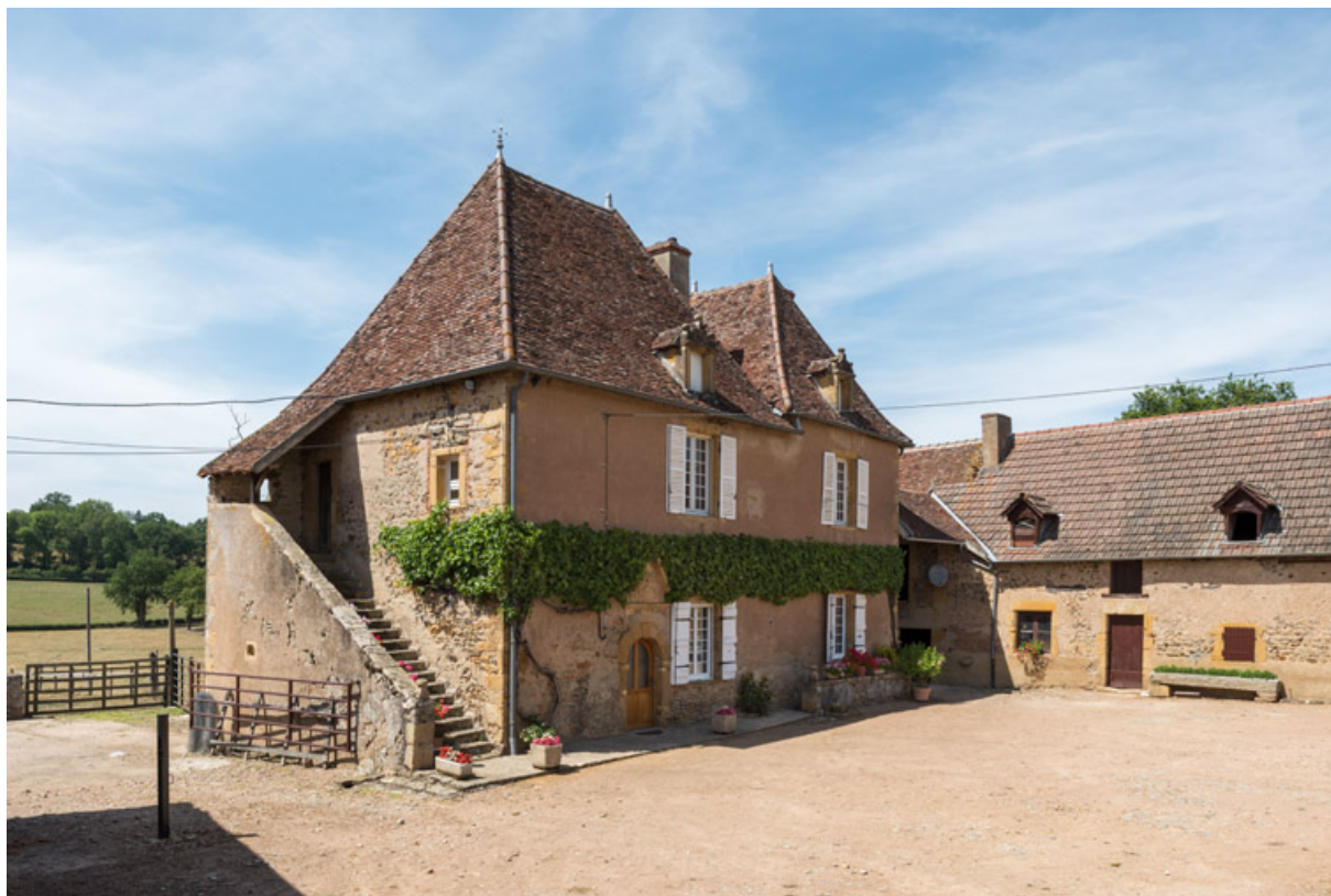
Vue de la demeure : façade antérieure et façade latérale avec l'escalier
