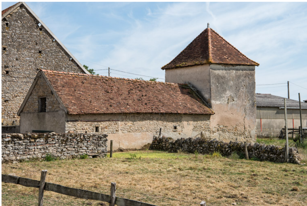
Façade postérieure du même bâtiment. En arrière-plan, un des murs-pignons de la grange.
