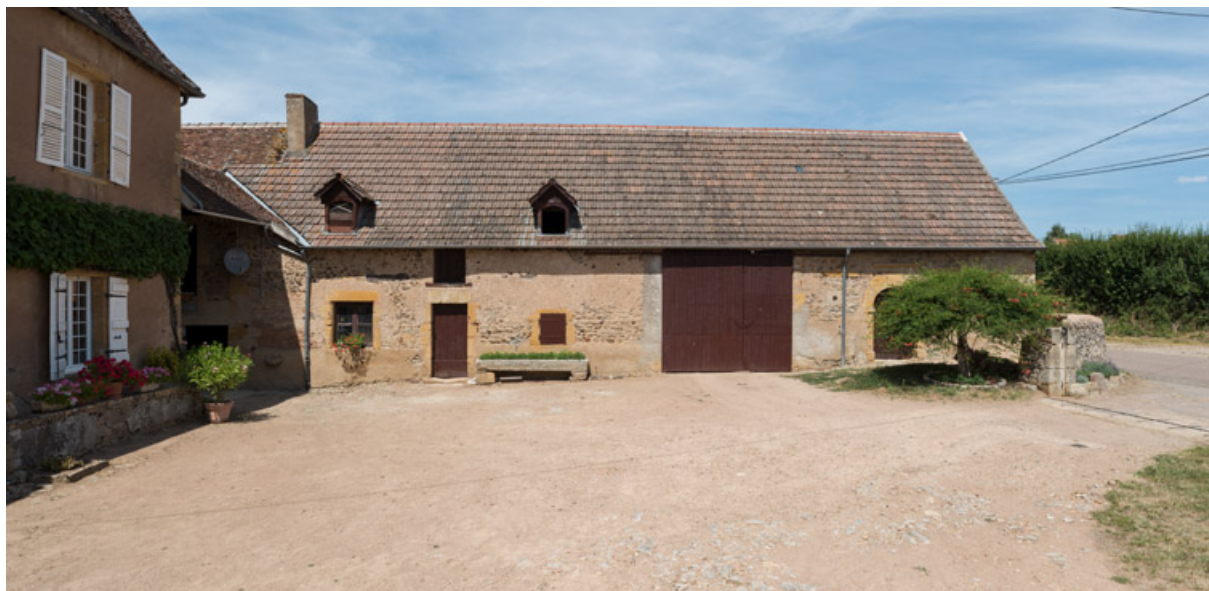
Aile de dépendance, fermant la cour au nord
