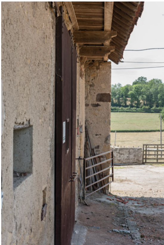
La façade de la grange est protégée par un débord de toit, soutenu par le dépassement des murs-pignons 71, Dyo, lieudit : Mans
