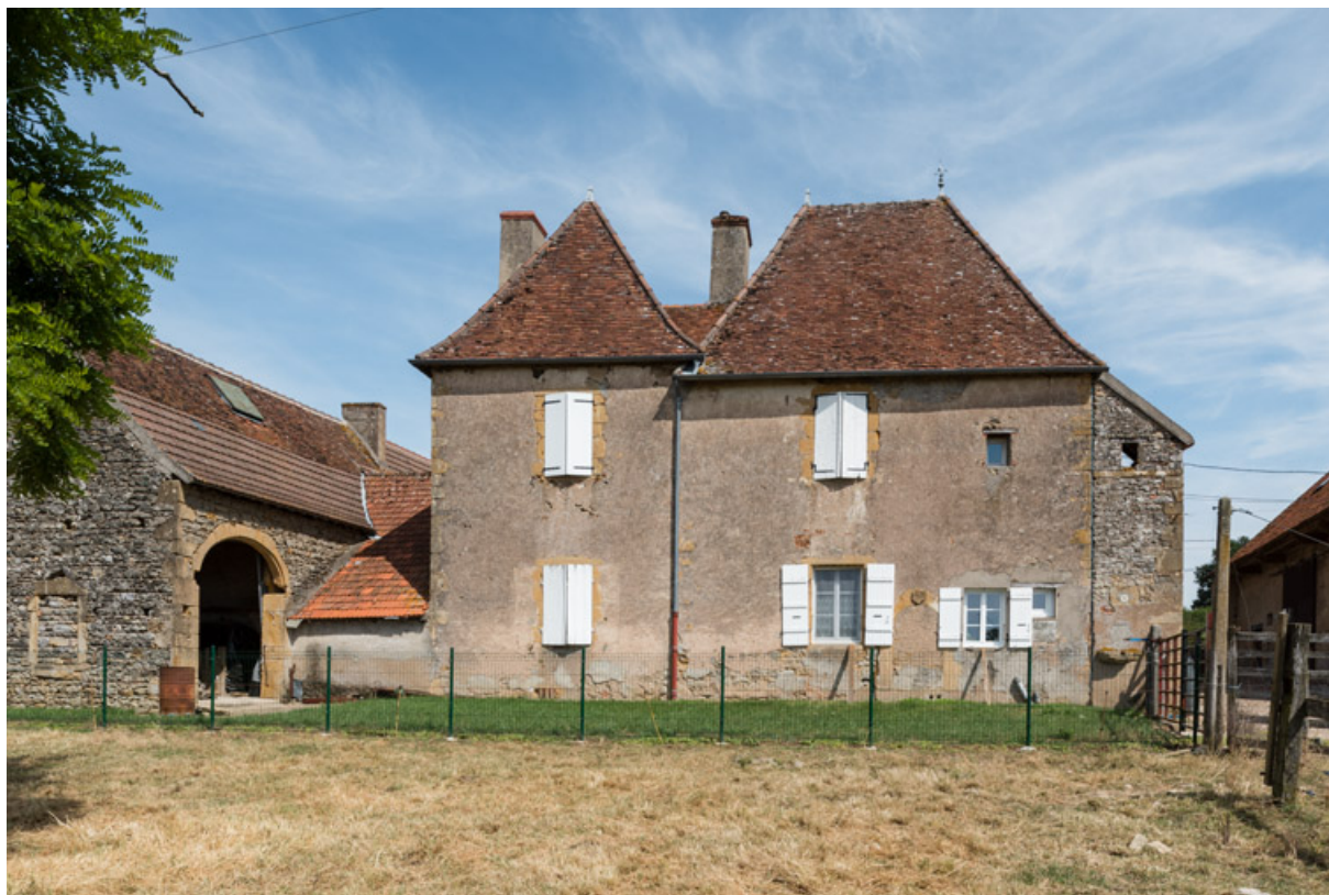
Façade postérieure de la maison
