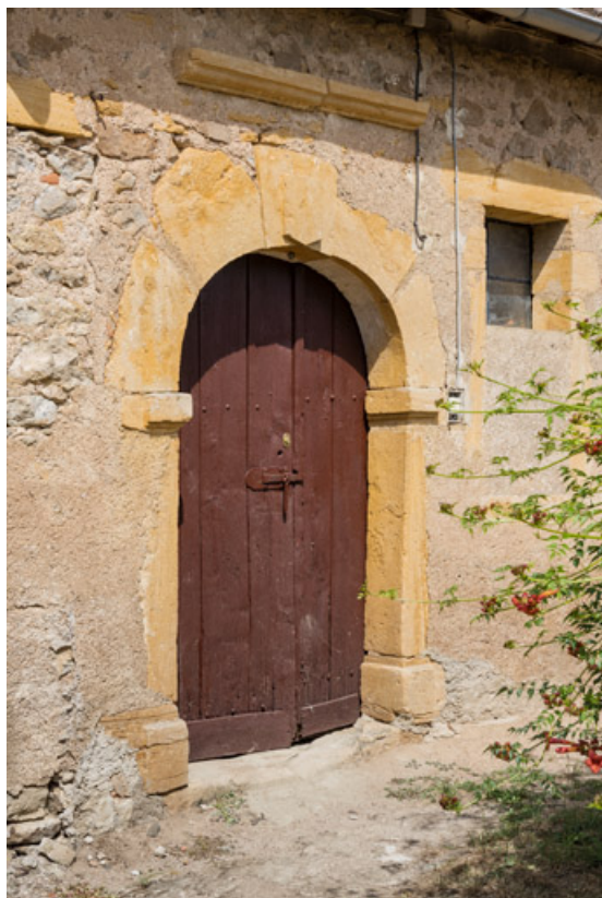
Porte de l'aile nord des dépendances, dont la clef est ornée d'une table d'attente 71, Dyo, lieudit : Mans
