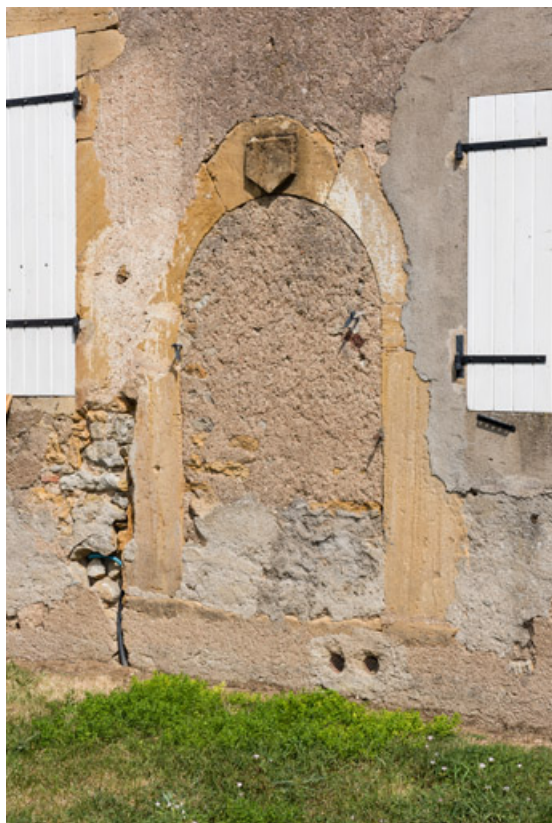
Porte bouchée sur la façade postérieure de la maison, dont la clef est ornée d'une table d'attente (blason nu) 71, Dyo, lieudit : Mans
