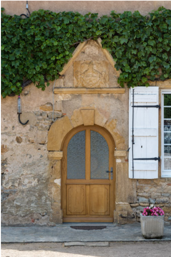
Porte d'entrée de la demeure avec son décor mouluré (impostes et agrafe), surmontée d'une table ornée d'un blason 71, Dyo, lieudit : Mans
