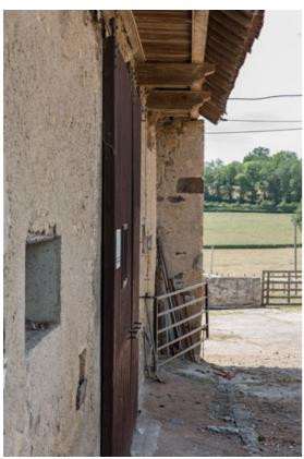
La façade de la grange est protégée par un débord de toit, soutenu par le dépassement des murs-pignons
