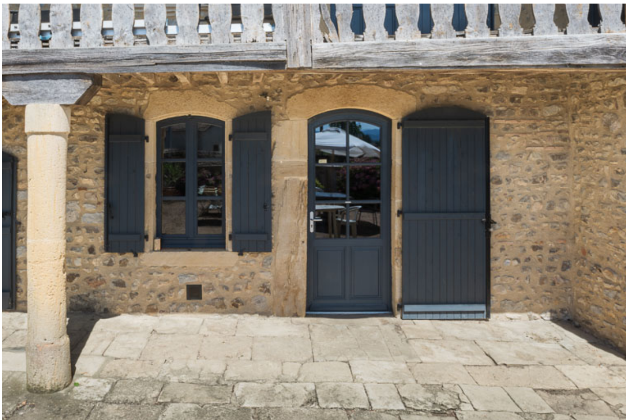
Détail du rez-de-chaussée de la façade antérieure de la maison : baies en arc segmentaire (milieu du XVIIIe siècle) 71, Vauban, lieudit : la Place
