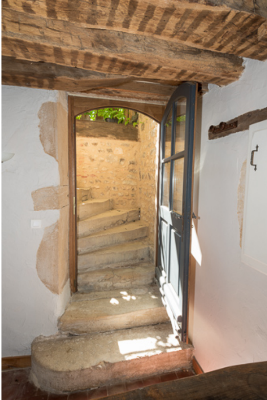
Escalier donnant accès à la galerie
