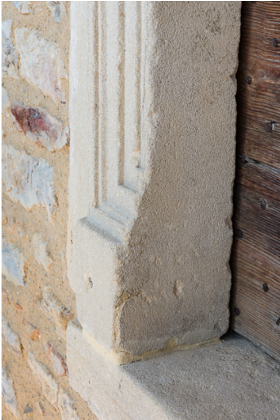
Détail d'une baie moulurée du XVIIe siècle, à l'étage de la maison 71, Vauban, lieudit : la Place
