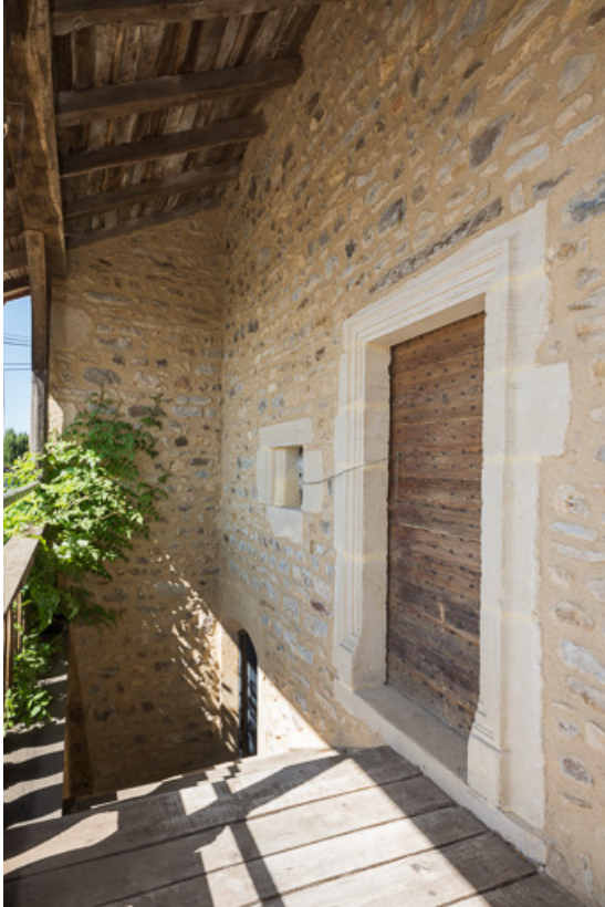
Vue de la galerie, protégée par un débord de toit soutenu par le dépassement des murs-pignons 71, Vauban, lieudit : la Place
