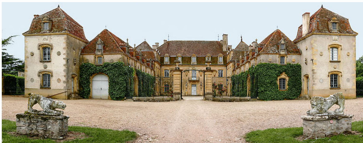
Vue du château et de la cour d'honneur au nord.
