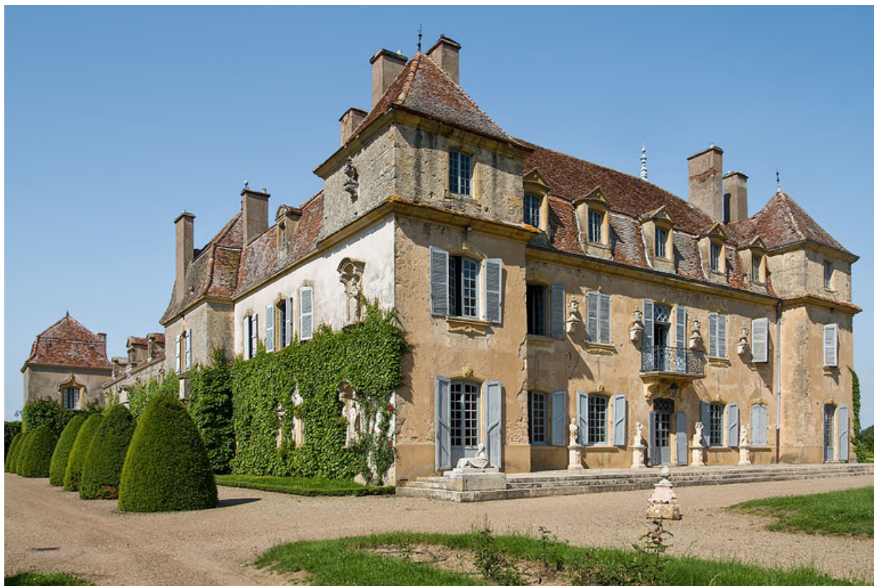
Vue des façades sud et ouest
