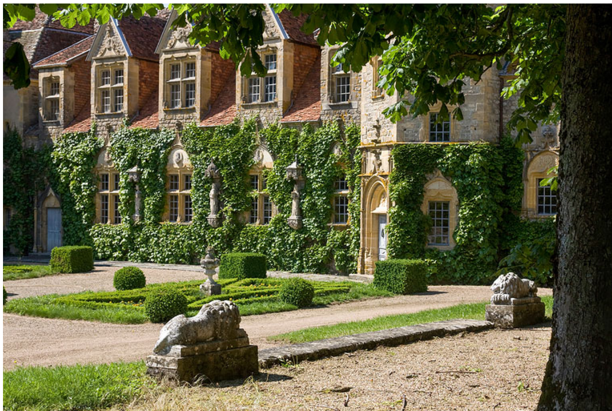
Vue de la façade sud de l'ail abritant la grande salle (ancienne grange), transformée au début du XXe siècle par l'ajout de lucarnes et d'une tour d'escalier hors-oeuvre provenant de l'ancien château de Moulin-l'Arconce (commune de Poisson).
