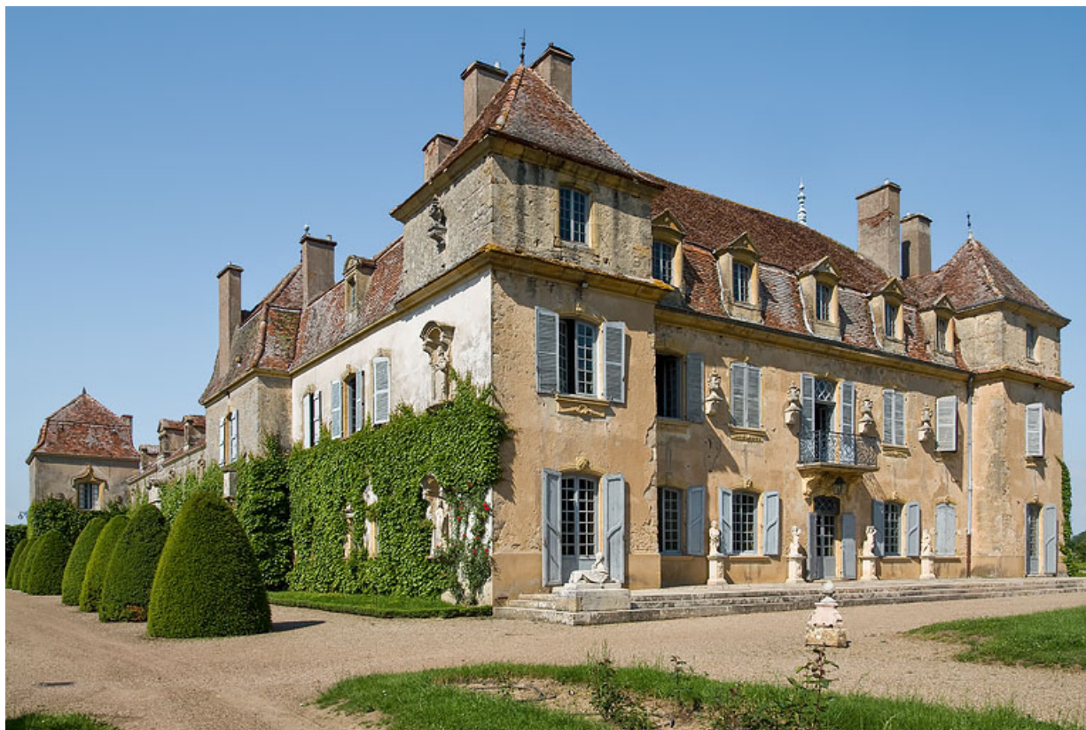
Vue des façades sud et ouest
