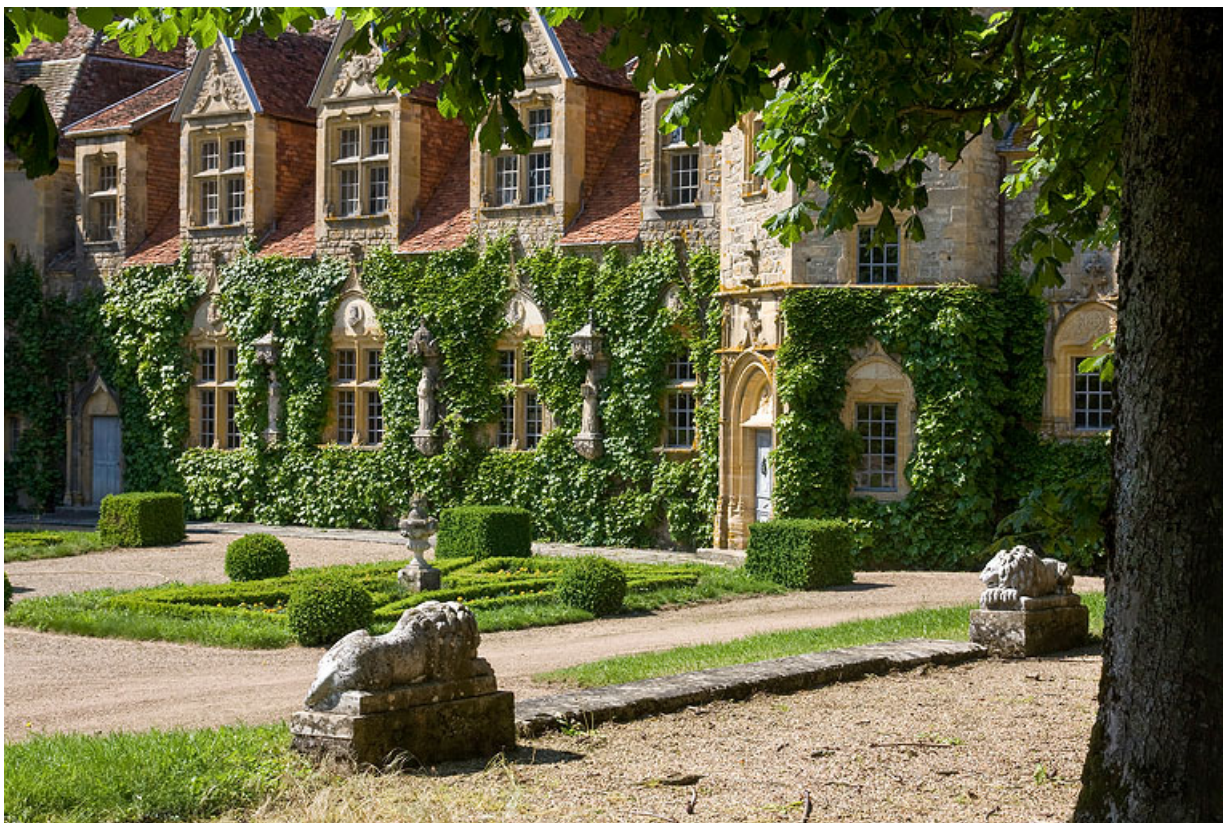
Vue de la façade sud de l'ail abritant la grande salle (ancienne grange), transformée au début du XXe siècle par l'ajout de lucarnes et d'une tour d'escalier hors-oeuvre provenant de l'ancien château de Moulin-l'Arconce (commune de Poisson).
