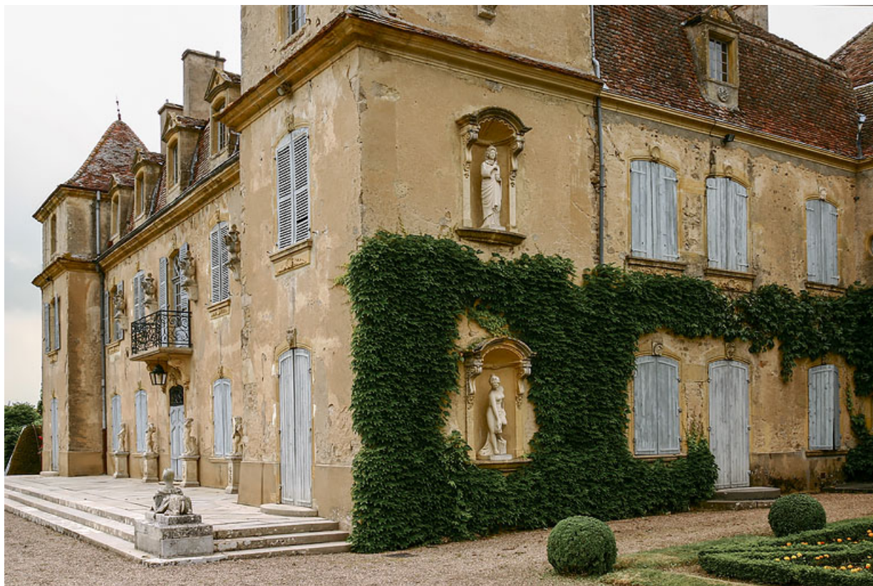
Vue des façades sud et est.
