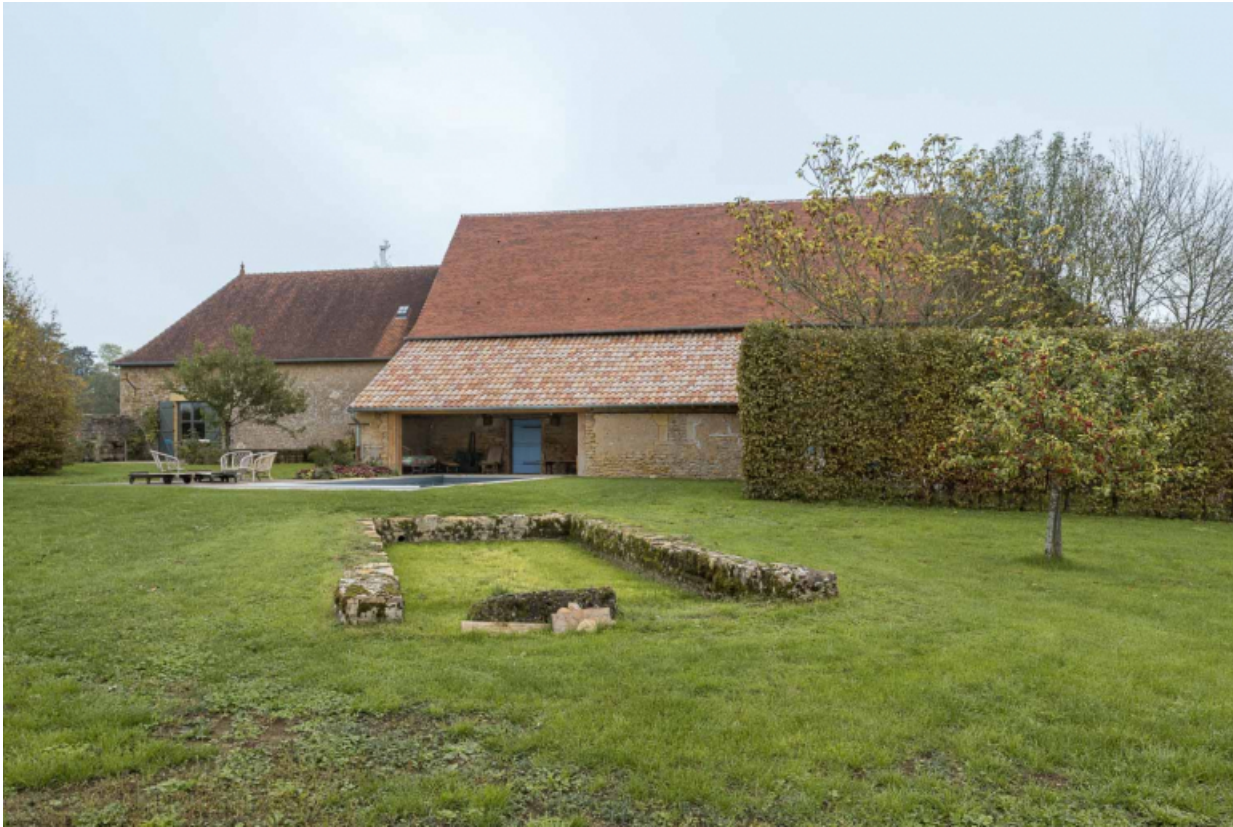
Vue de la façade postérieure des granges en 2019. Seul, l'appentis a été modifié et ouvert pour l'aménagement d'une piscine. 71, Saint-Julien-de-Civry, lieudit : En Vaux
