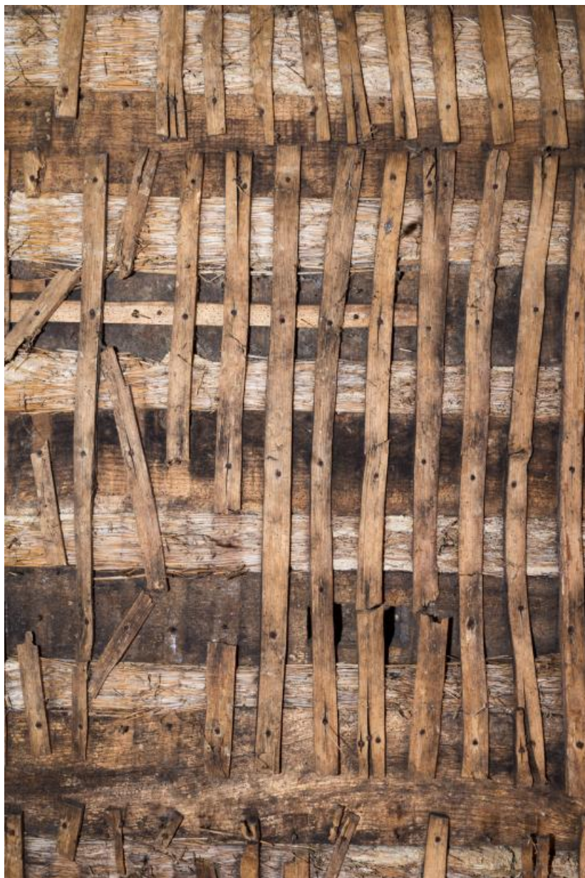
Détail d'un plancher dans la dépendance, constitué de pièces de bois (solives), de bottes de paille et couvert d'un lattis 71, Saint-Julien-de-Civry, lieudit : En Vaux
