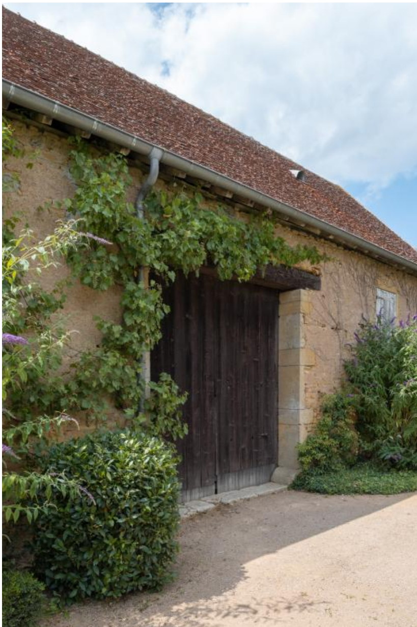
Porte d'une des remises de la dépendance construite en 1831.
