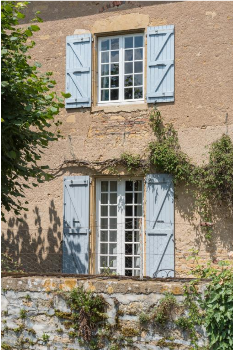
Détail de la façade antérieure de la maison : baie du rez-de-chaussée et de l'étage 71, Saint-Julien-de-Civry, lieudit : En Vaux
