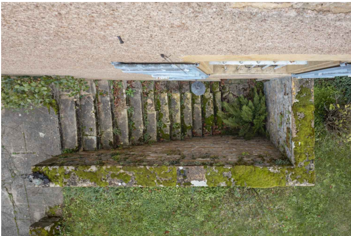
Vue en plongée sur la descente de la cave, sur la façade antérieure de la maison.
