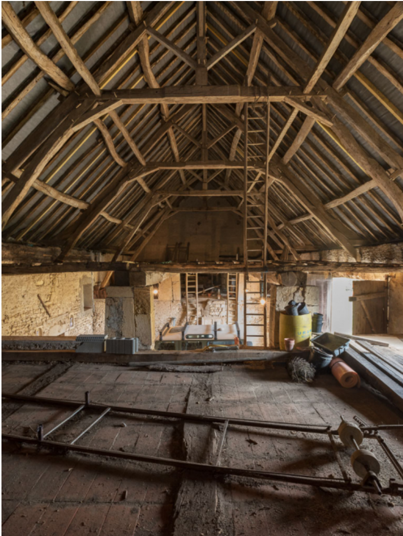
Charpente de la grange, construite en 1831.
