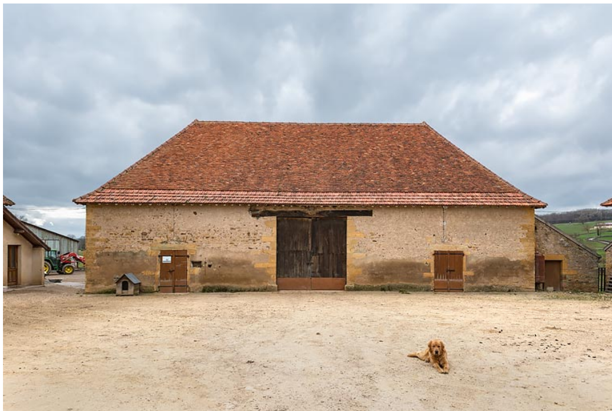
Grange, au fond de la cour, abritant une remise et deux étables doubles
