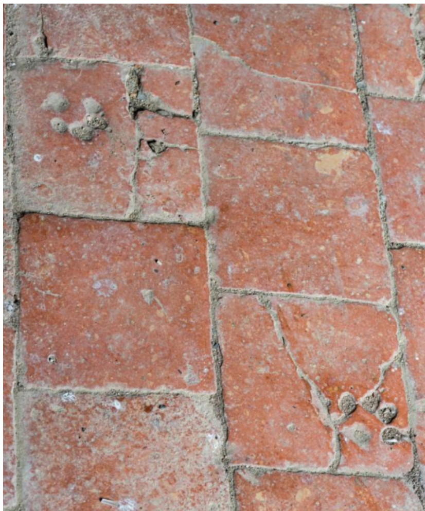
Sol de la cuisine en carreau de terre cuite
