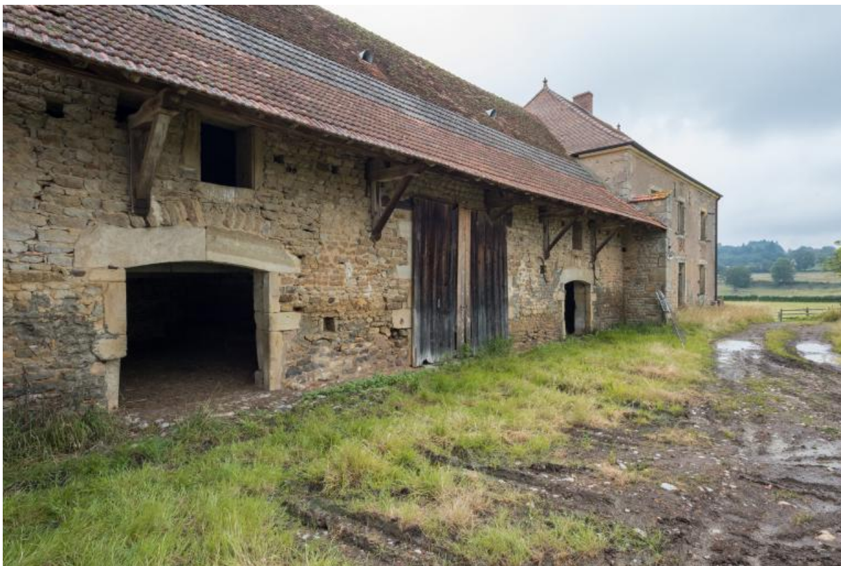
Vue de la grange avec son large débord de toit
