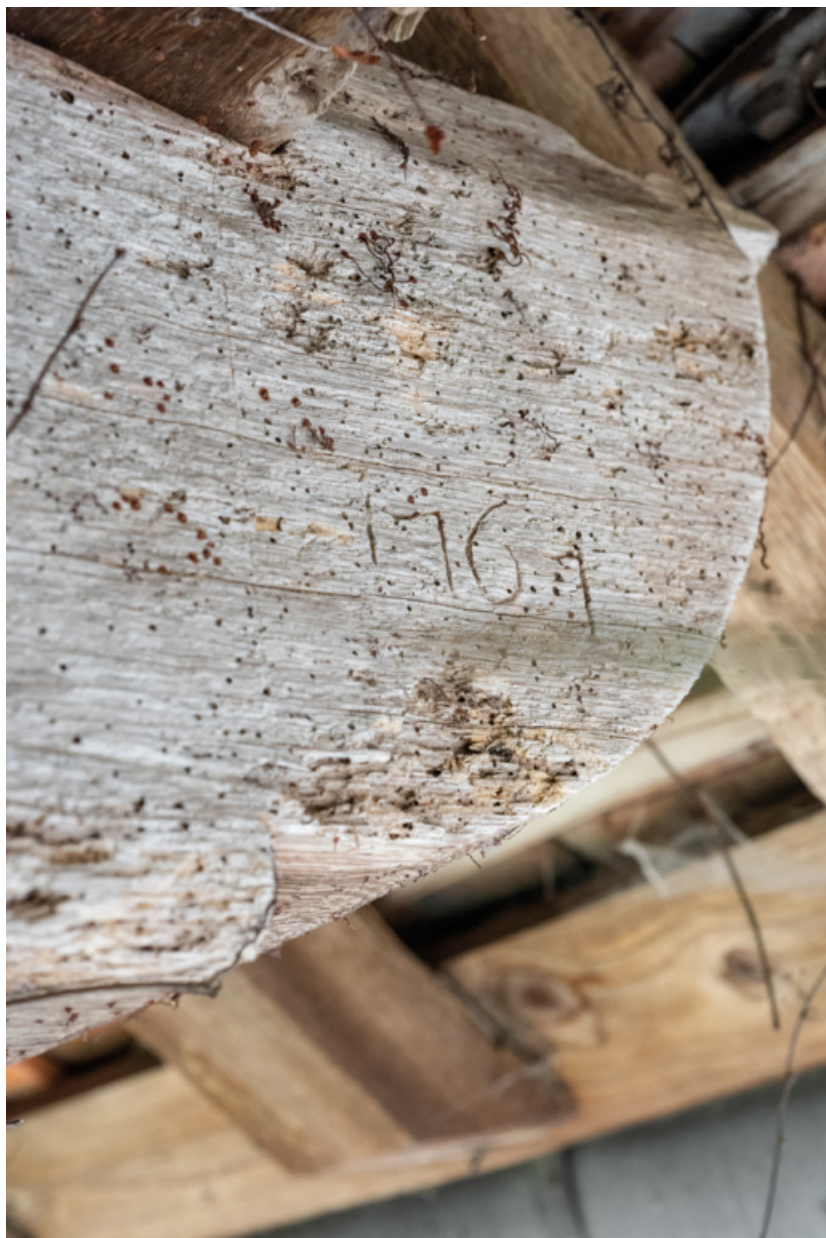
Bâtiment agricole nord. Date gravée sur un entrait de la charpente.
