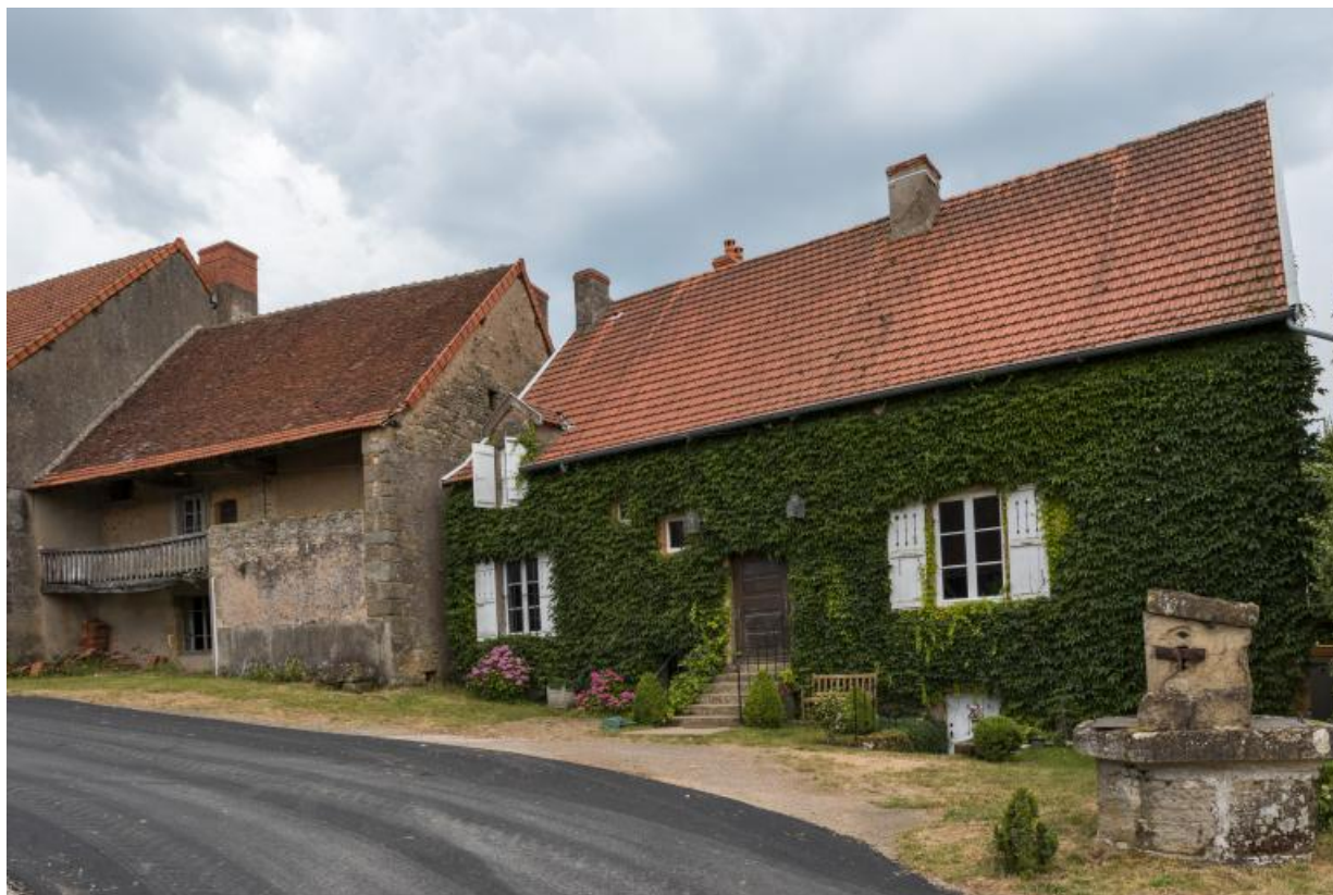
Façade antérieure de la maison, avec le puits au premier plan
