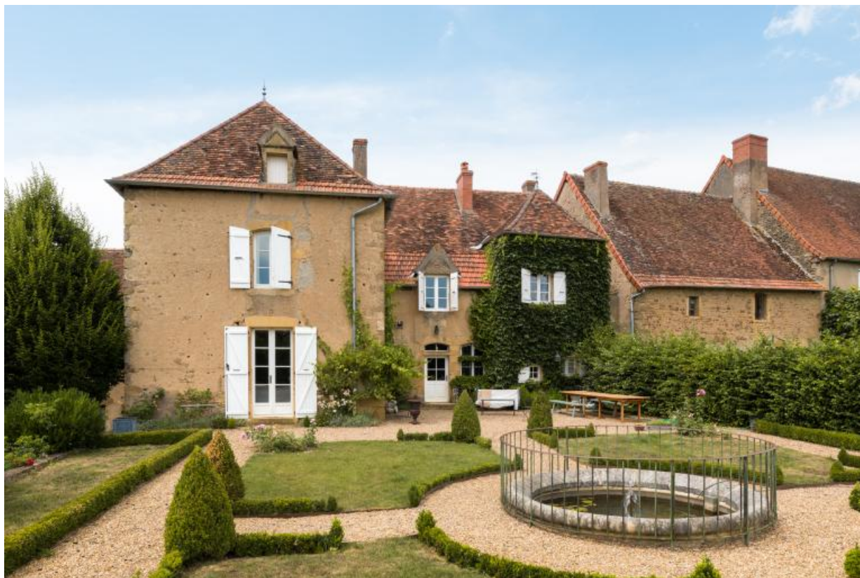
Façade postérieure de la maison
