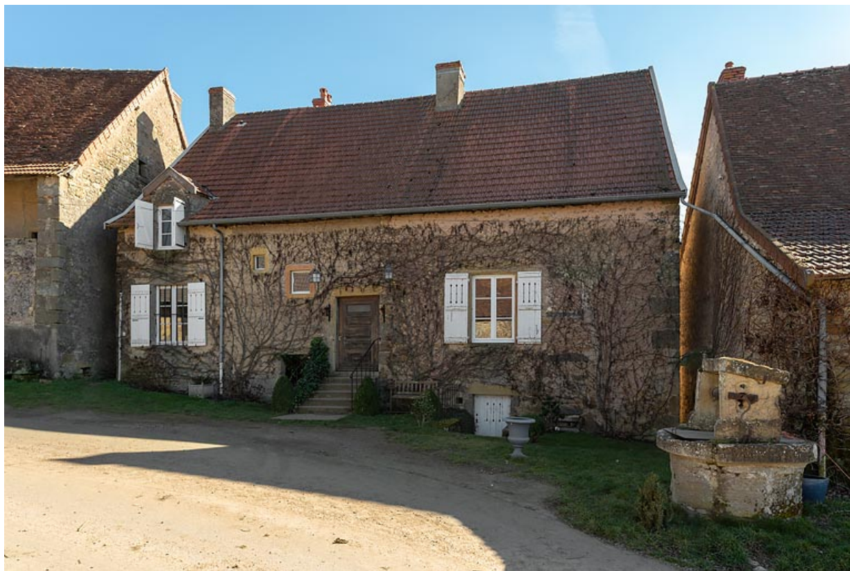
Façade antérieure de la maison. Les ruptures de l'enduit indique que le mur, en partie centrale, a été ajoutée postérieurement afin de fermer la cage d'escalier.
