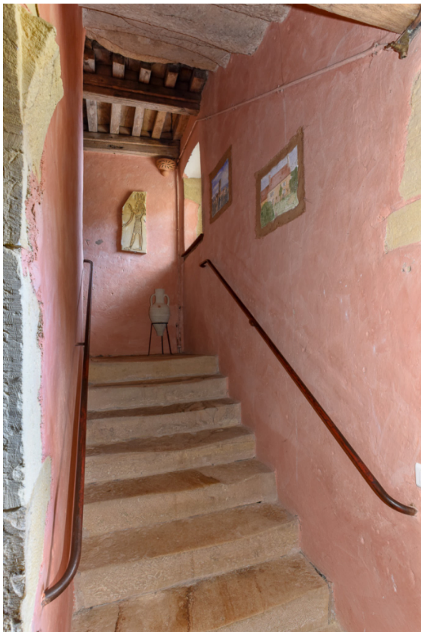
Première volée de l'escalier rampe sur rampe à l'intérieur de la demeure.
