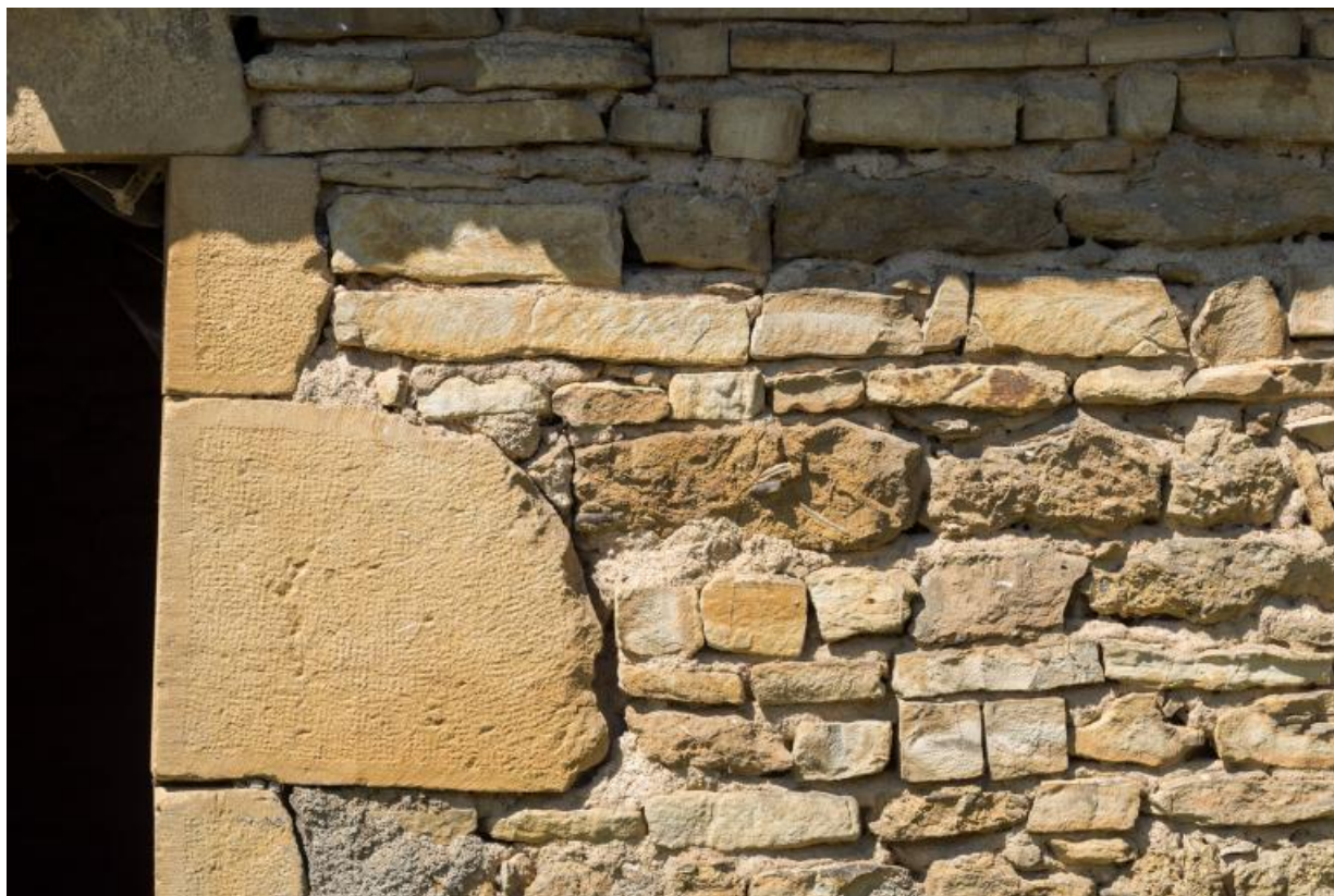
Détail de la maçonnerie de la grange
