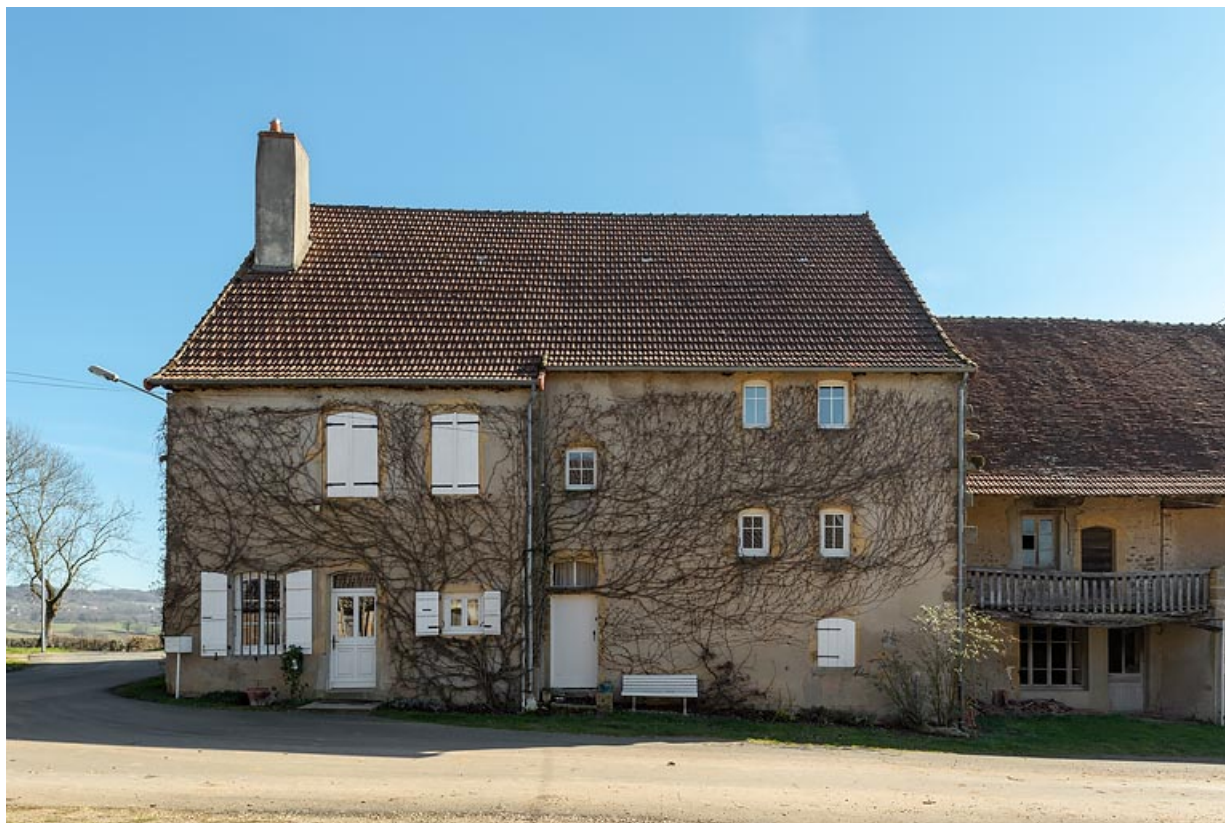
Façade antérieure de la maison.
