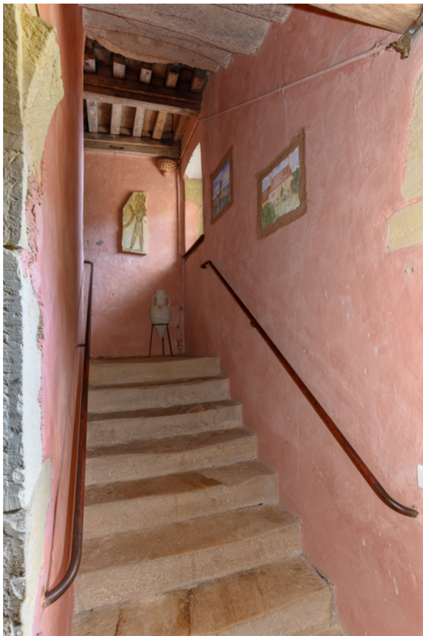
Première volée de l'escalier rampe sur rampe à l'intérieur de la demeure.
