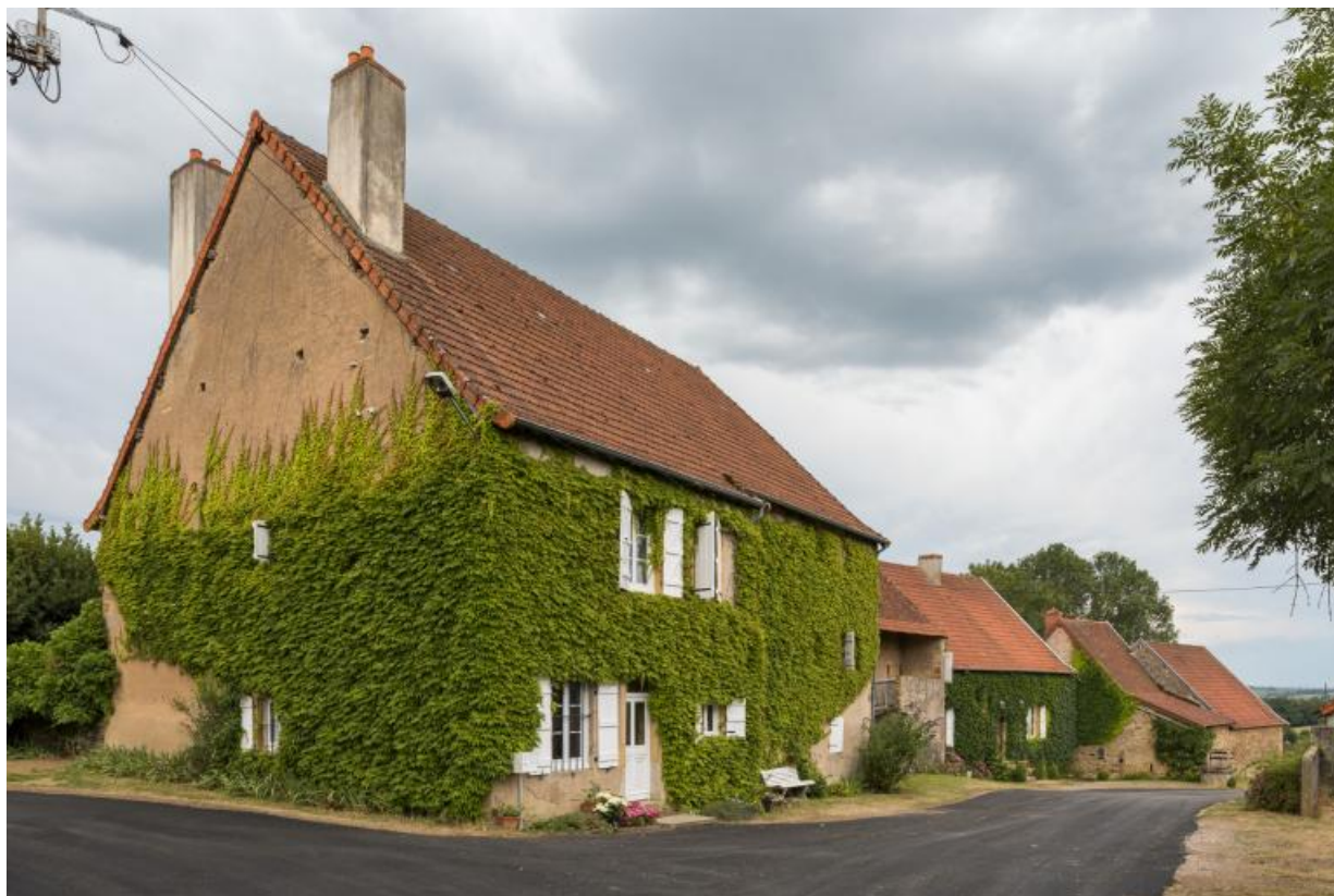
Vue de la maison d'Antoine Despierres (angle nord-est)
