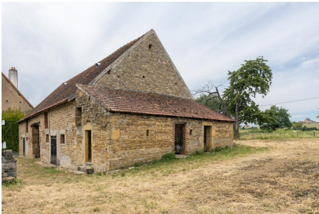
Vue du mur-pignon est de la grange, contre lequel a été bâti au XIXe siècle un appentis abritant les soues à cochons 71, Prizy, lieudit : les Bouffiers
