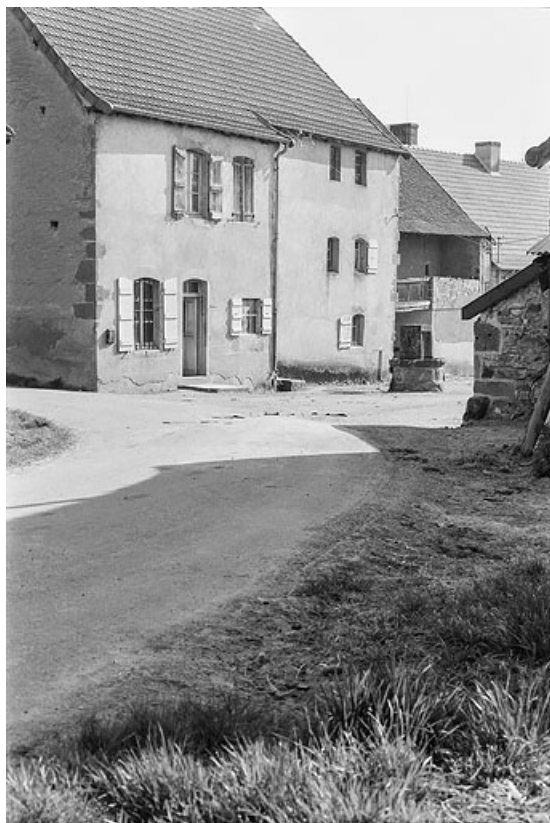
Vue de la maison, vers 1970. Le puits, devant la demeure, a depuis été détruit. 71, Prizy, lieudit : les Bouffiers
