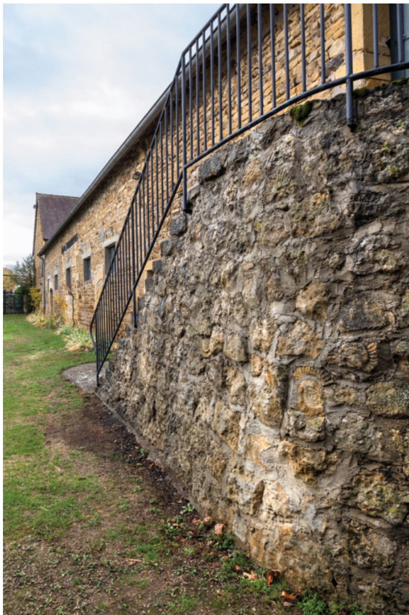
Vue de la grange et de l'escalier, à l'extrémité nord du bâtiment, dont la maçonnerie présente des fossiles 71, Poisson, lieudit : Martigny
