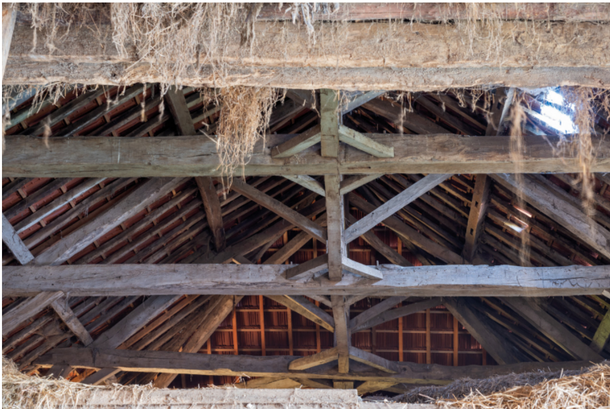
Vue de la charpente et du fenil de la grange
