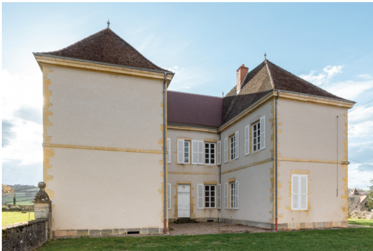
Façade nord-est du château
