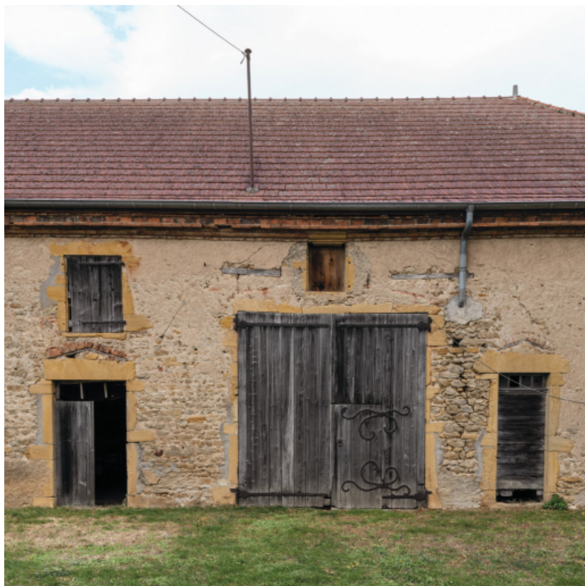
Détail de la façade sud-ouest de la grange, du côté du château 71, Oyé, lieudit : La Croix
