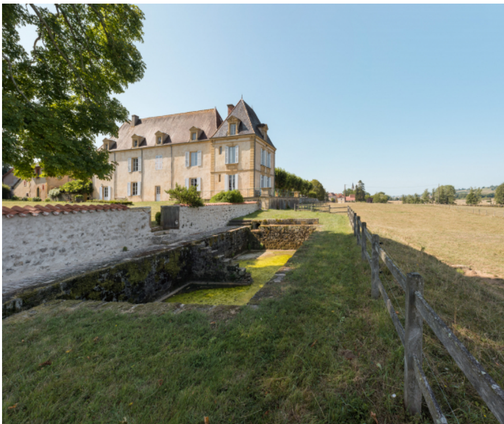
Vue de trois-quart de la façade postérieure du chateau, et des bassins d'irrigation des prés sous-jacents. 71, Saint-Didier-en-Brionnais, lieudit : La Grande Terre
