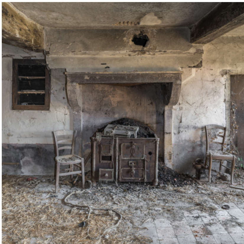
Vue de face de la cheminée. Pièce unique du rez-de-chaussée.
