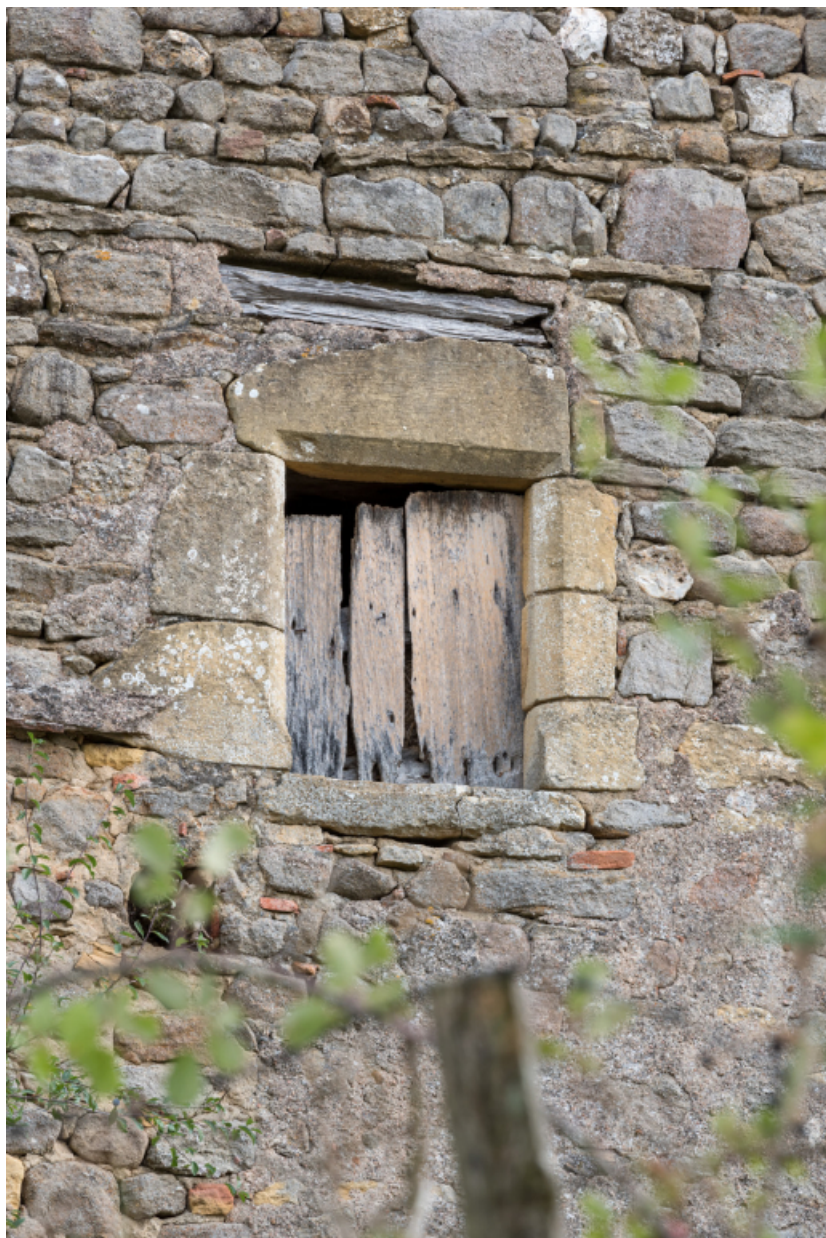
Vue rapprochée de la baie ouverte dans le pignon ouest.
