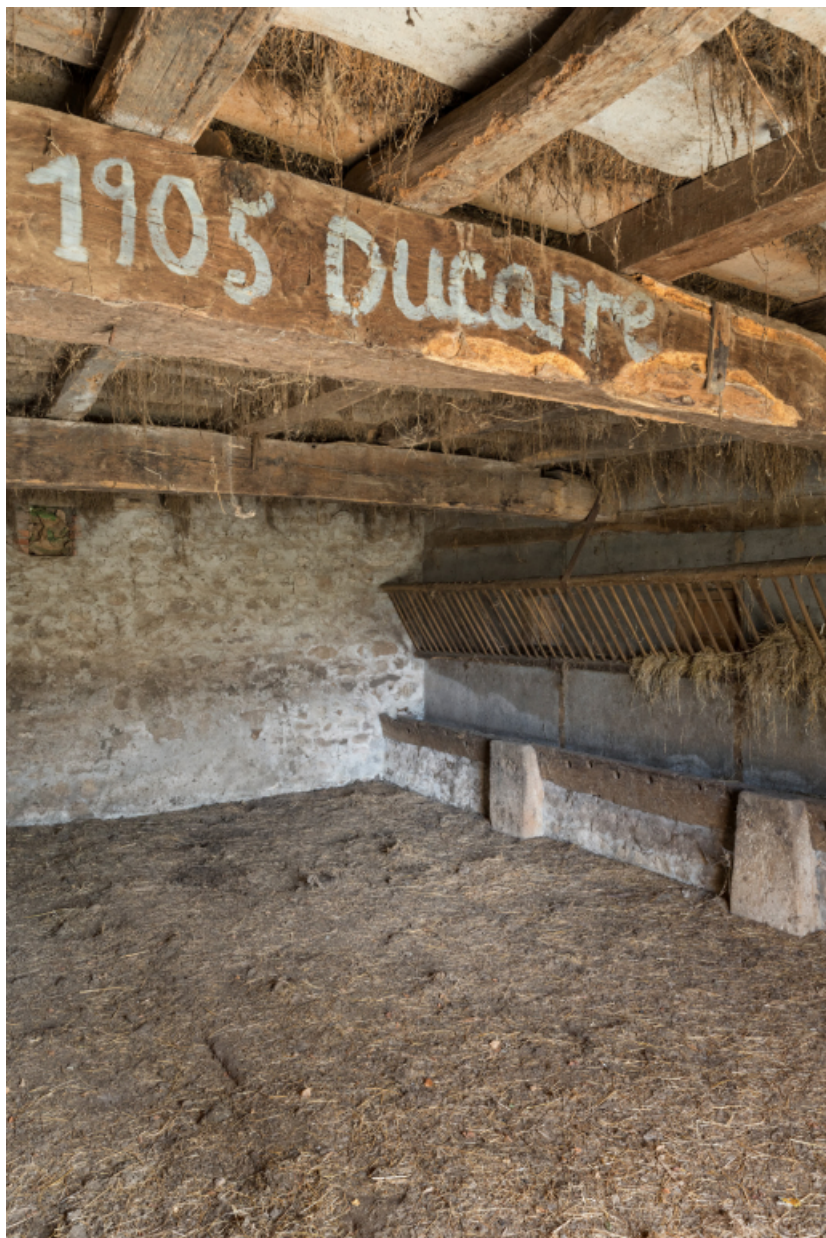
Vue intérieure de l'étable à vache. inscription et date sur la charpente.
