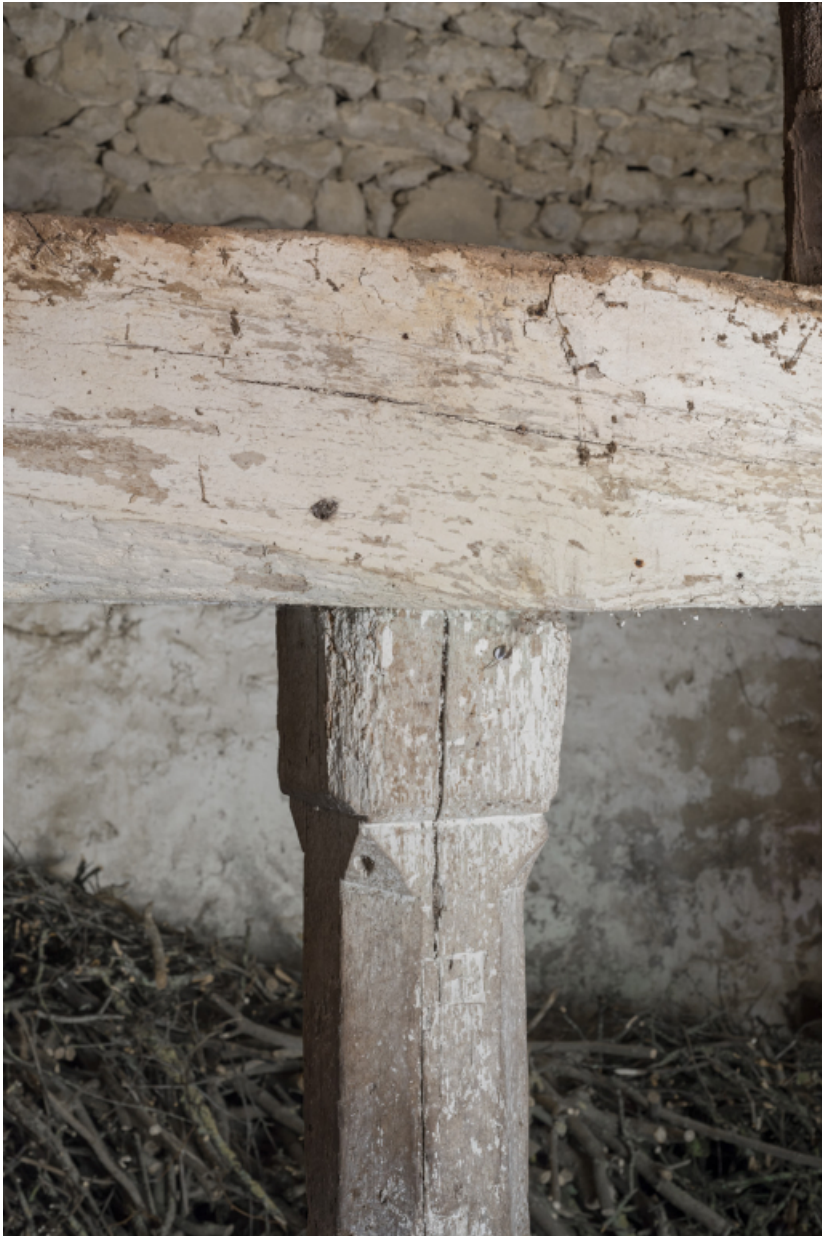
Vue rapprochée d'un assemblage poutre-poteau.
