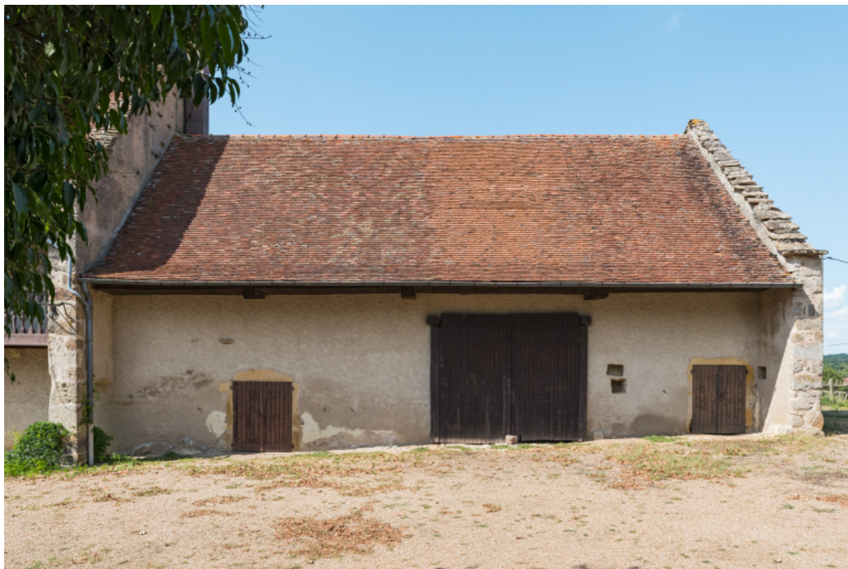
Vue de face de la façade antérieure de la partie agricole : grange et étables.
