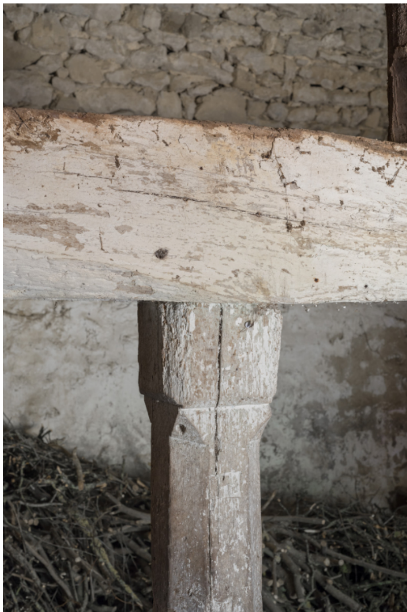
Vue rapprochée d'un assemblage poutre-poteau.
