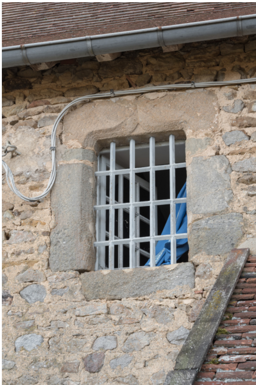
Détail de la baie est à l'étage de la façade postérieure.
