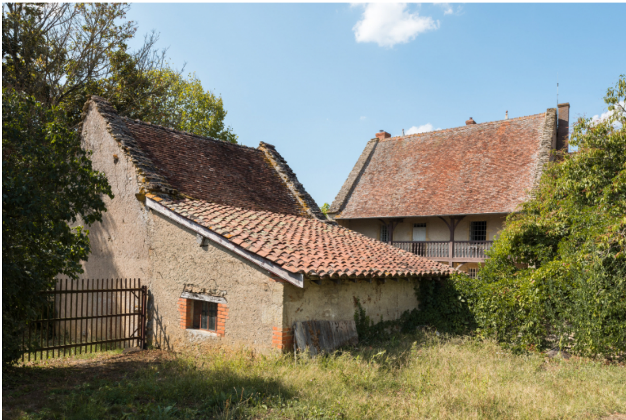
Vue de trois-quart sud-est de la dépendance agricole.
