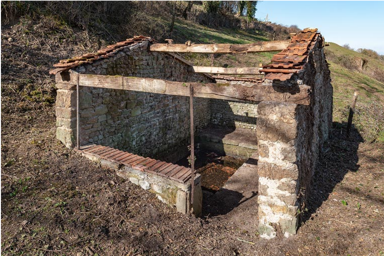
Lavoir du hameau (en cours de restauration)
