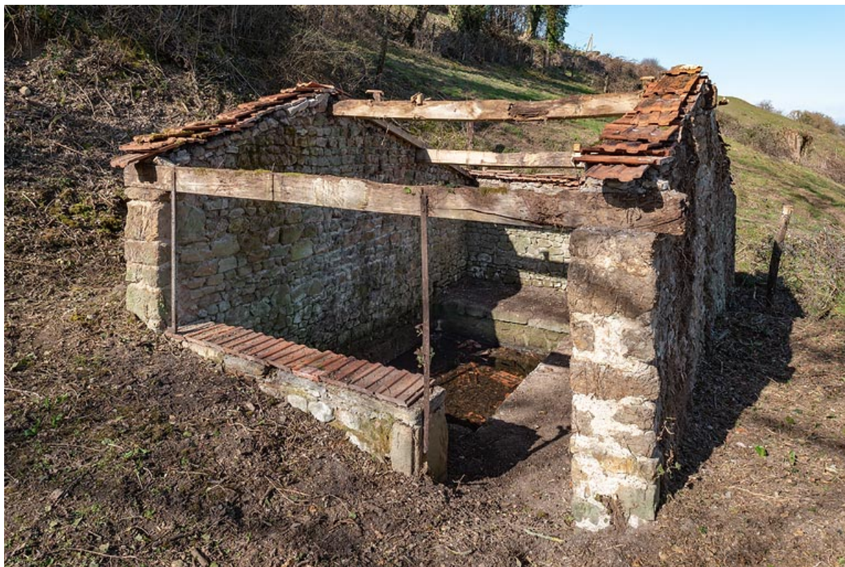
Lavoir du hameau (en cours de restauration)
