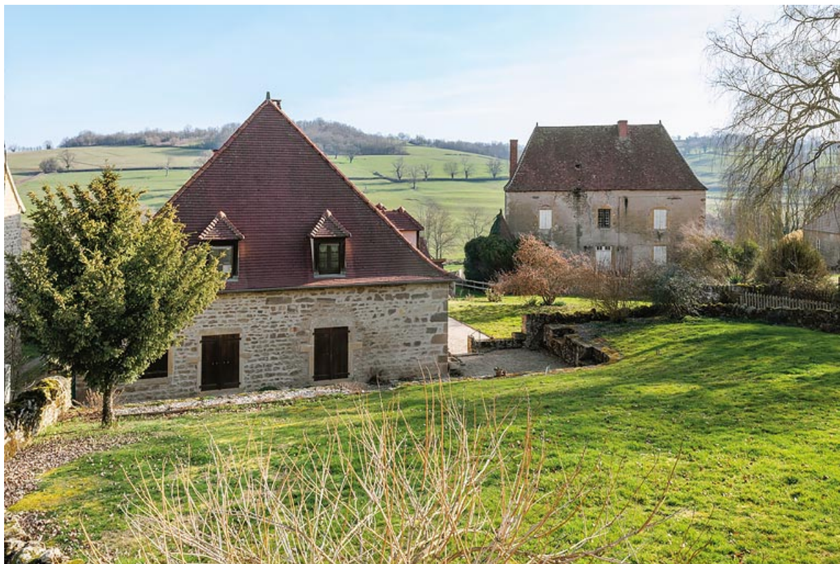
Vue de l'ancienne ferme d'embouche de la famille Mommessin. Au premier plan, l'ancienne grange. Au second plan, la maison construite en 1782.
