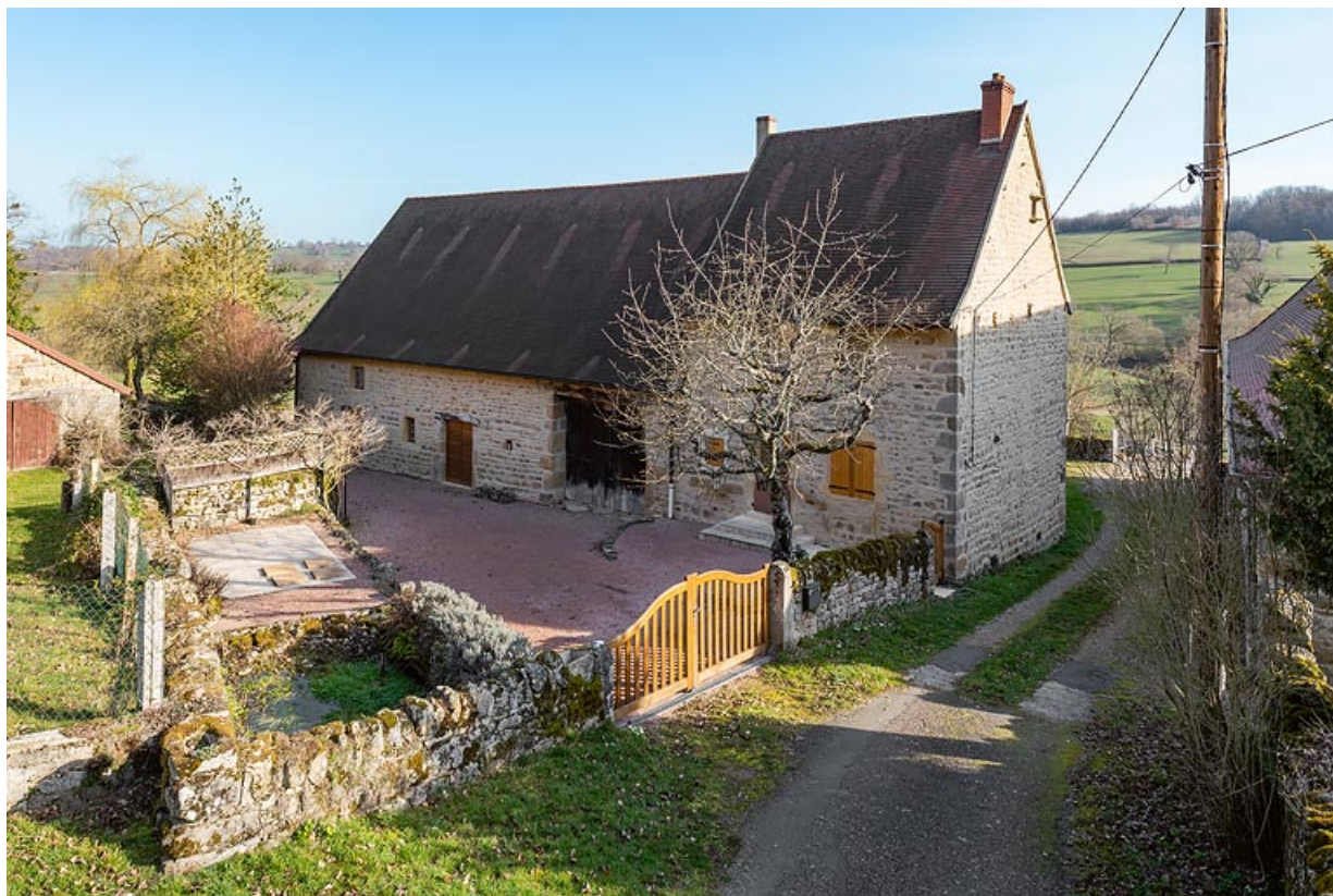
Ferme de cultivateur (Claude Barreau en 1825), composé d'une habitation, d'une grange (abritant une remise et une étable), prolongé par un second logement à l'extrémité du bâtiment (sans doute pour un employé).
