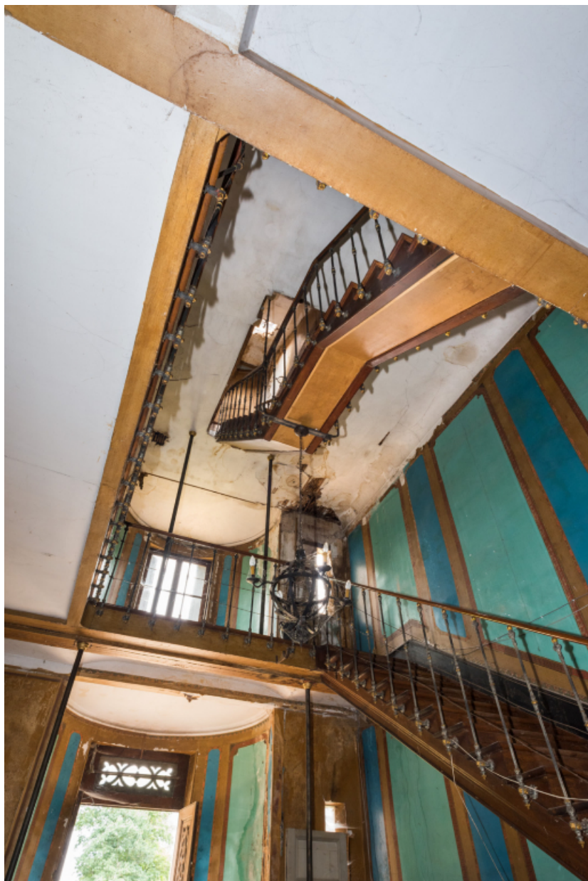
Escalier d'accès à la tourelle (extension nord fin 19e siècle).
