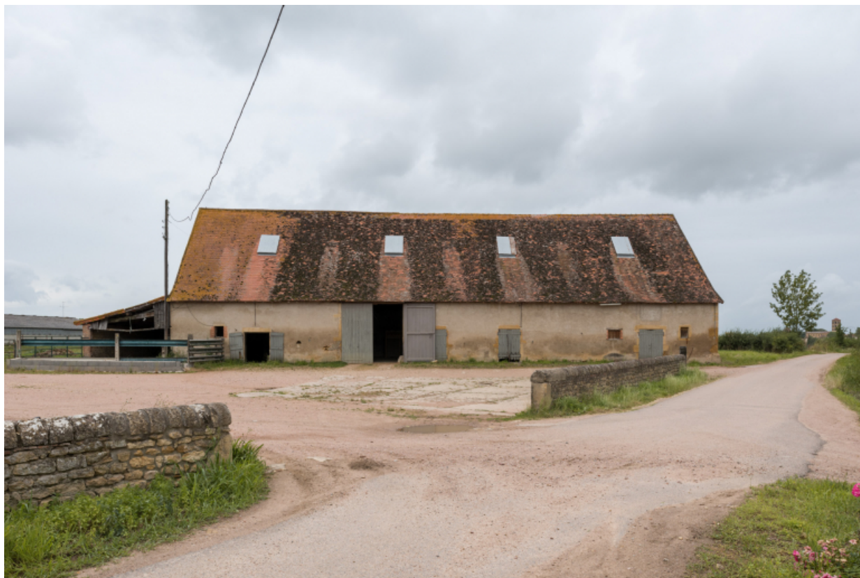
Façade antérieure du bâtiment agricole.
