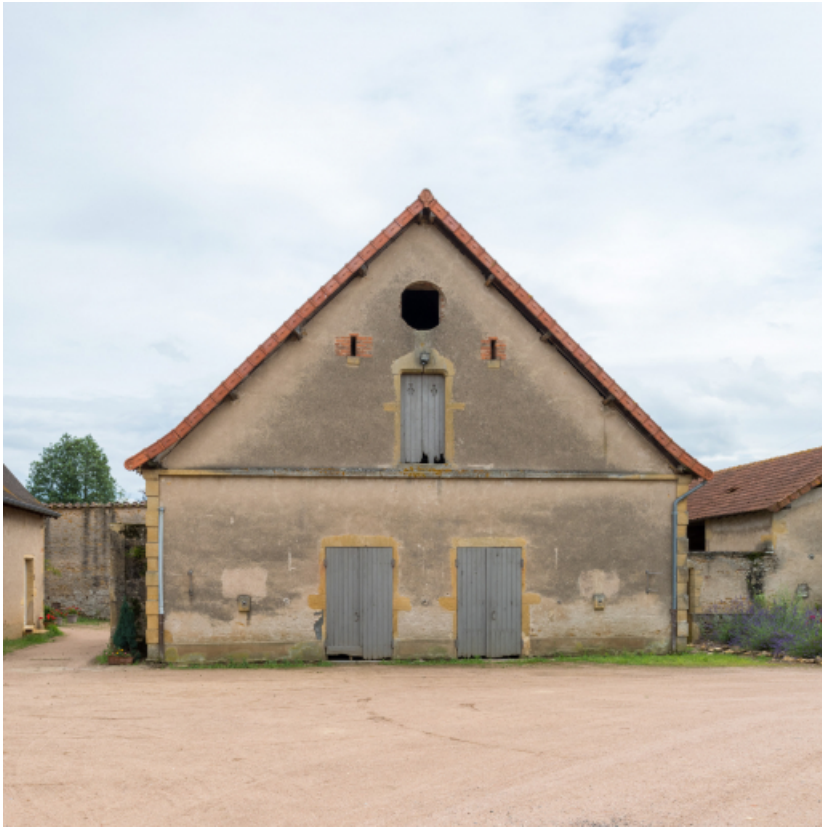
Pignon d'une dépendance agricole.
