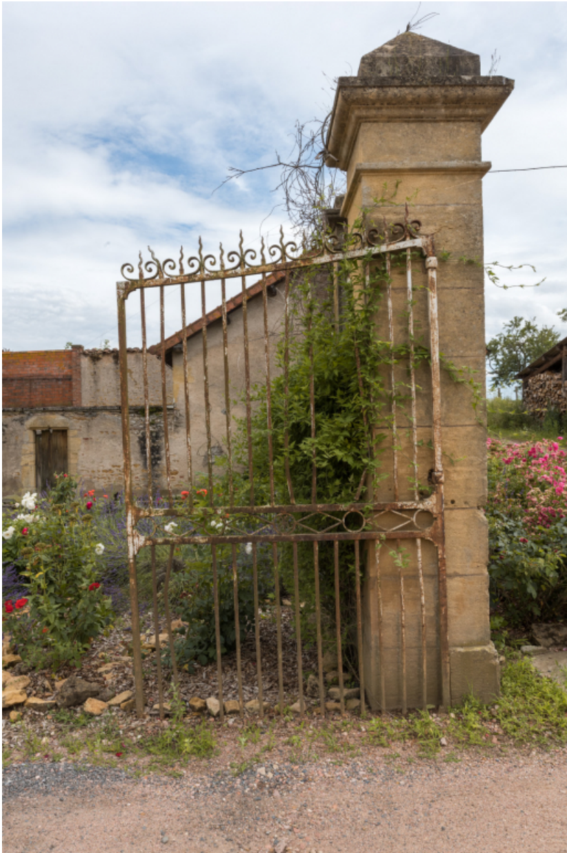
Détail du portail d'entrée de la demeure.
