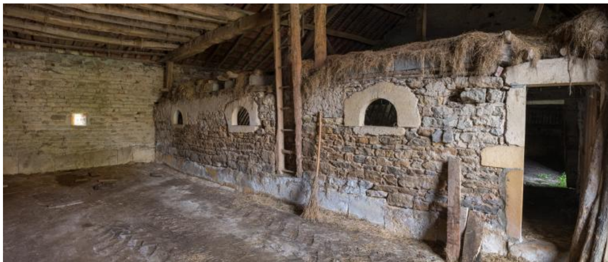
Vue intérieure de la grange (remise, mur de séparation avec l'étable, percé de feurons, et fenil)
