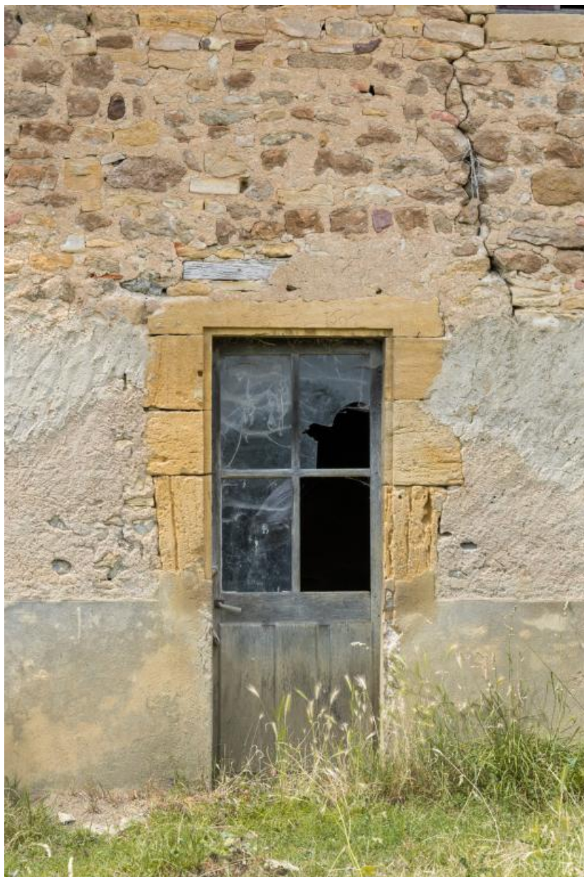
Porte (ancienne fenêtre) sur la façade postérieure de la maison, portant la date de 1691 71, Prizy, lieudit : les Bouffiers
