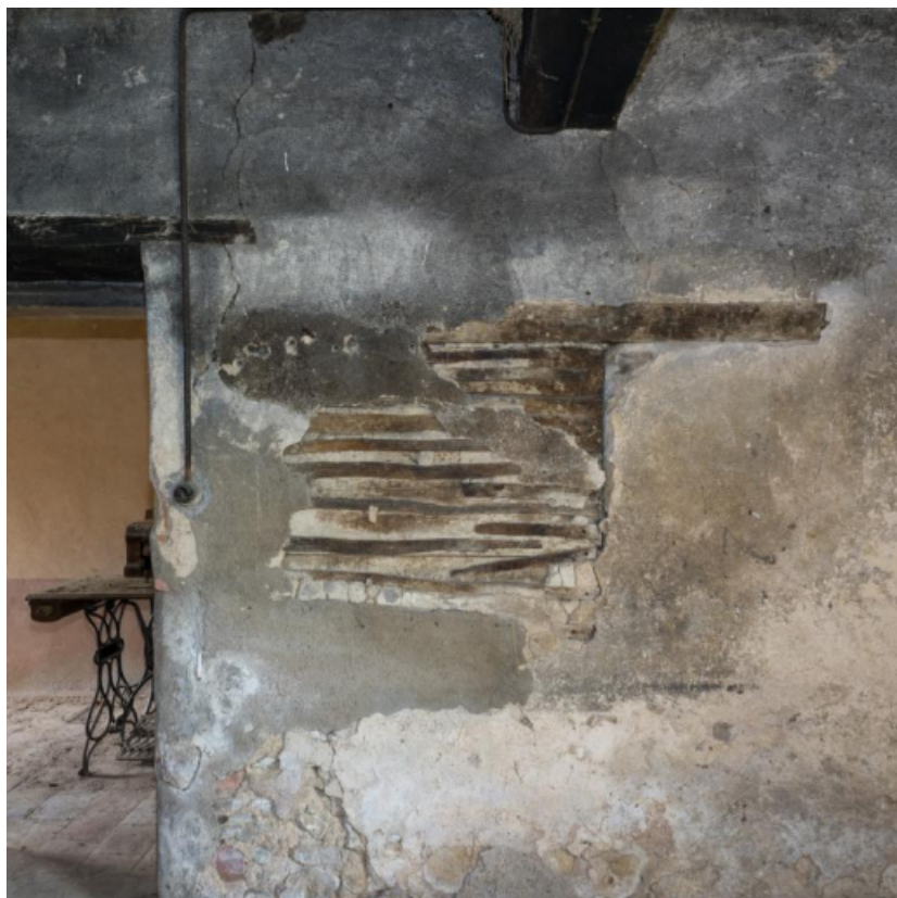
Détail de la cloison de la cuisine (ancienne chambre) de la maison Mommessin 71, Prizy, lieudit : les Bouffiers
