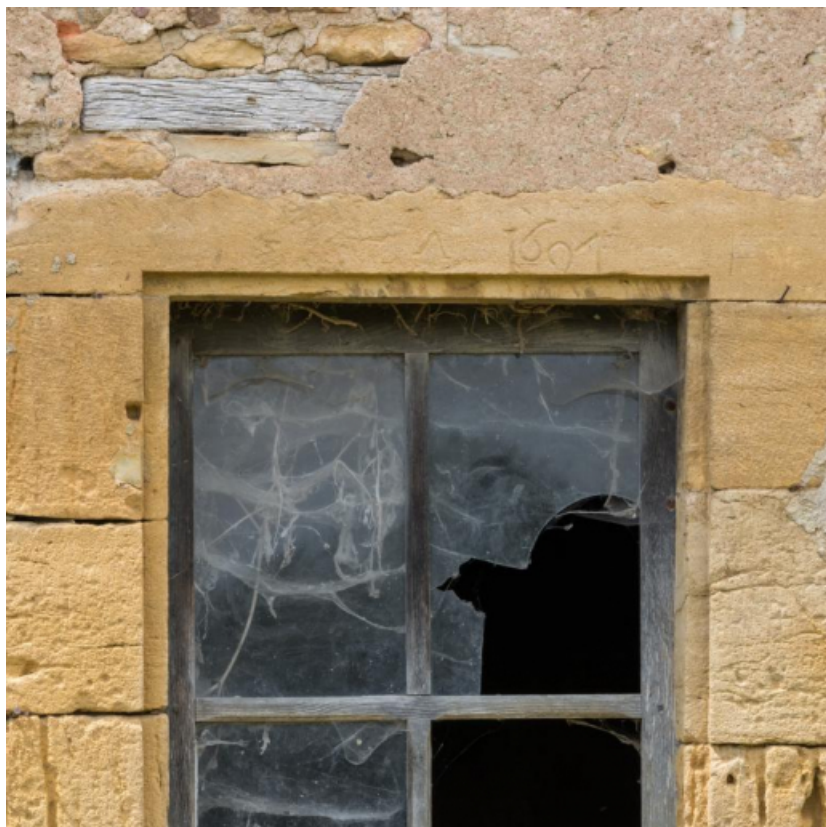
Détail de la date sur le linteau de la porte (façade postérieure de la maison Mommessin) 71, Prizy, lieudit : les Bouffiers
