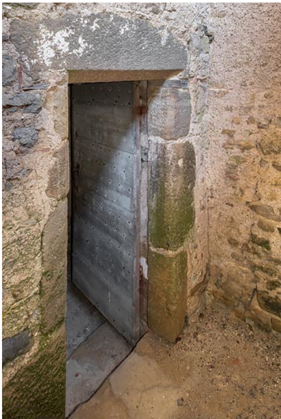
Porte chanfreinée donnant accès à la galerie et qui était vraisemblablement la porte d'entrée d'origine de la maison. 71, Prizy, lieudit : les Bouffiers
