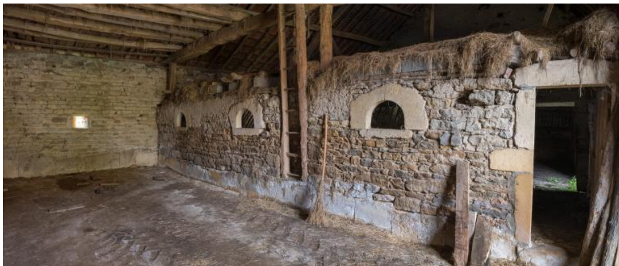
Vue intérieure de la grange (remise, mur de séparation avec l'étable, percé de feurons, et fenil) 71, Prizy, lieudit : les Bouffiers
