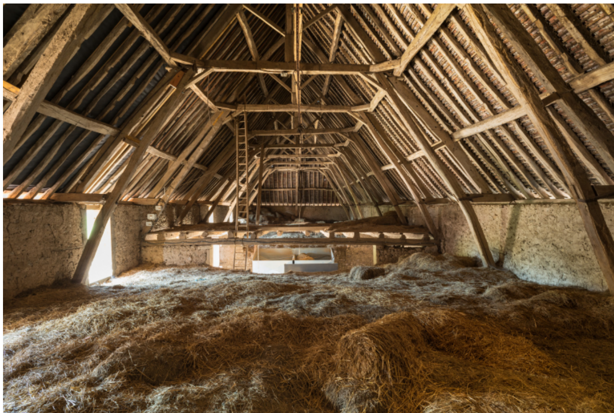
Charpente du bâtiment agricole. Vue depuis le fenil (cadrage horizontal).
