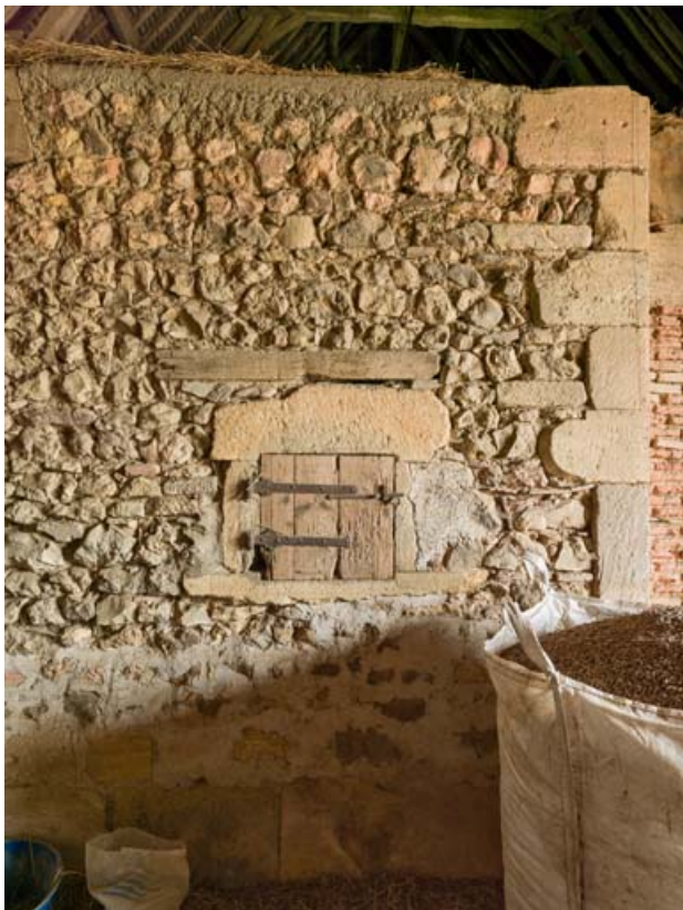
Ouverture (dite feuron) dans le mur de séparation entre l'étable et la remise.
