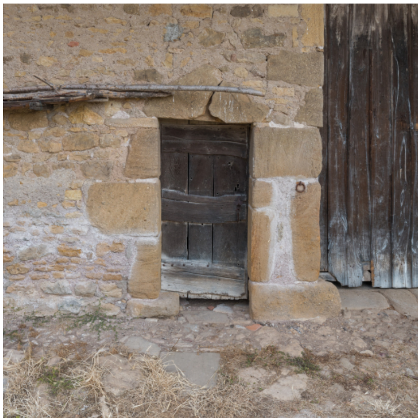
Façade antérieure du bâtiment agricole. Porte piétonne.
