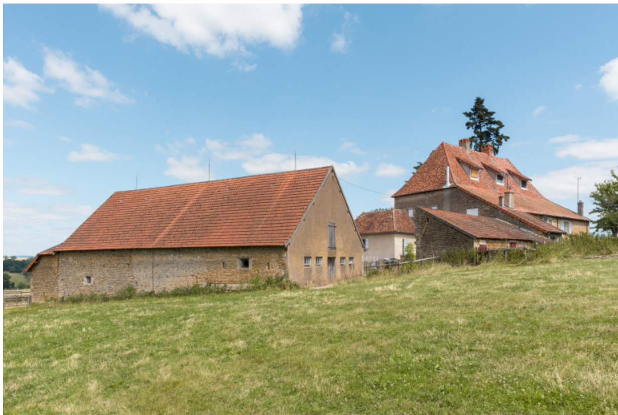
Vue d'ensemble depuis l'ouest.
