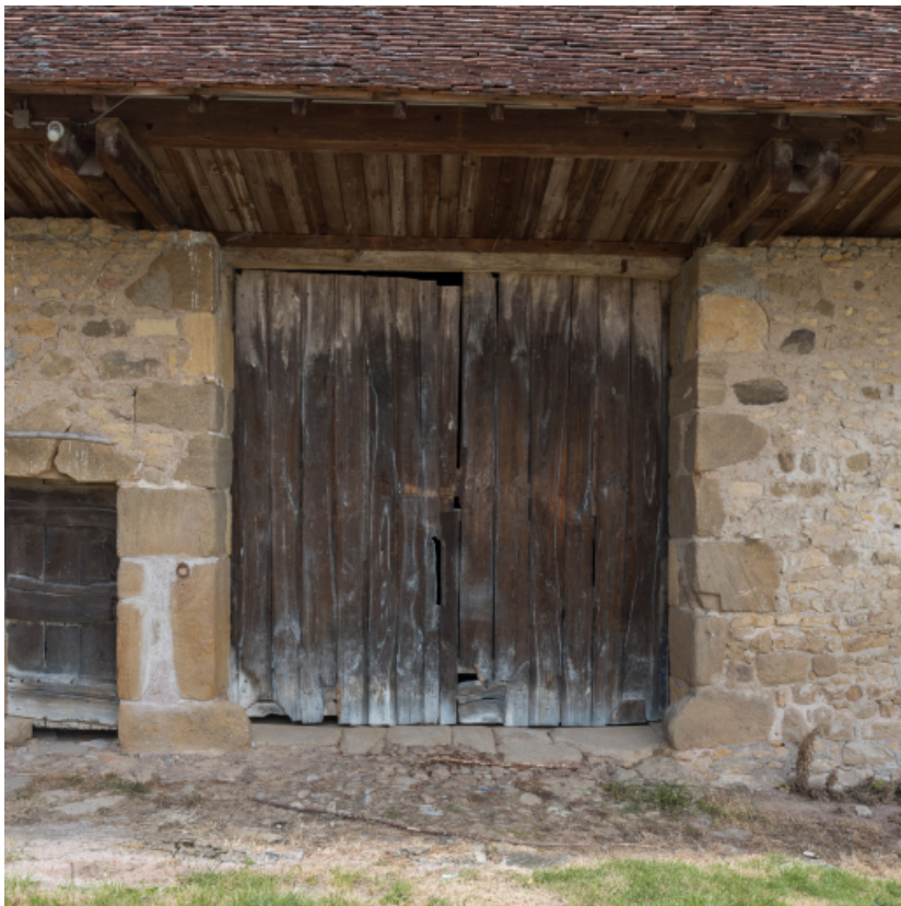
Façade antérieure du bâtiment agricole. Porte de la remise.
