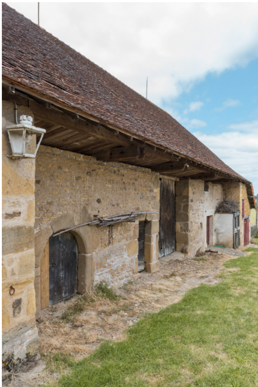
Vue de trois quarts gauche du bâtiment agricole.
