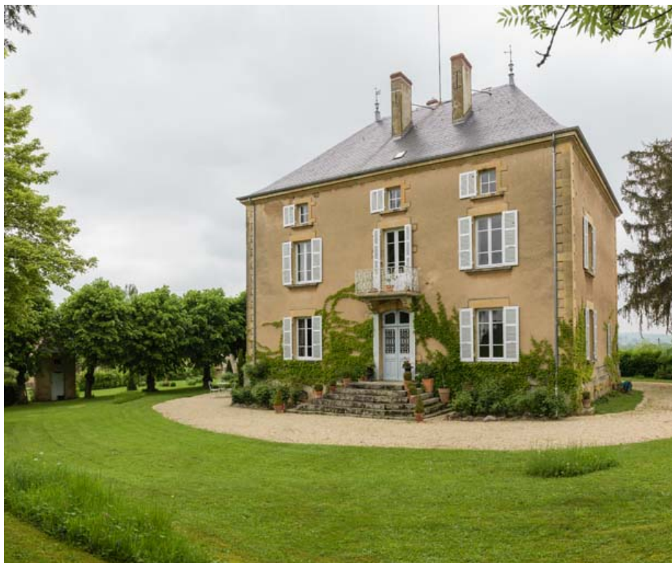
Façade postérieure, vue de trois quarts droite.
