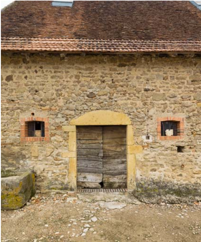
Etable. Détail de la travée ouest.
