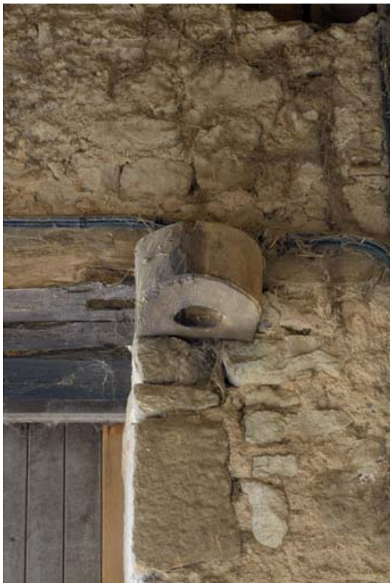
Pierre percée qui recevait l'axe de la porte de l'étable.
