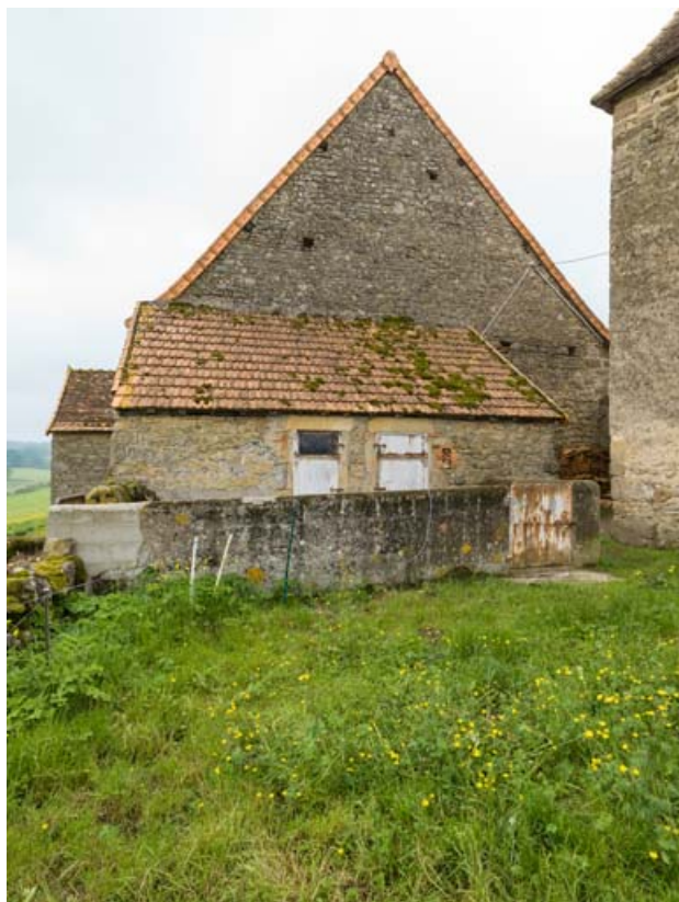
La soue adossée au pignon de l'étable.
