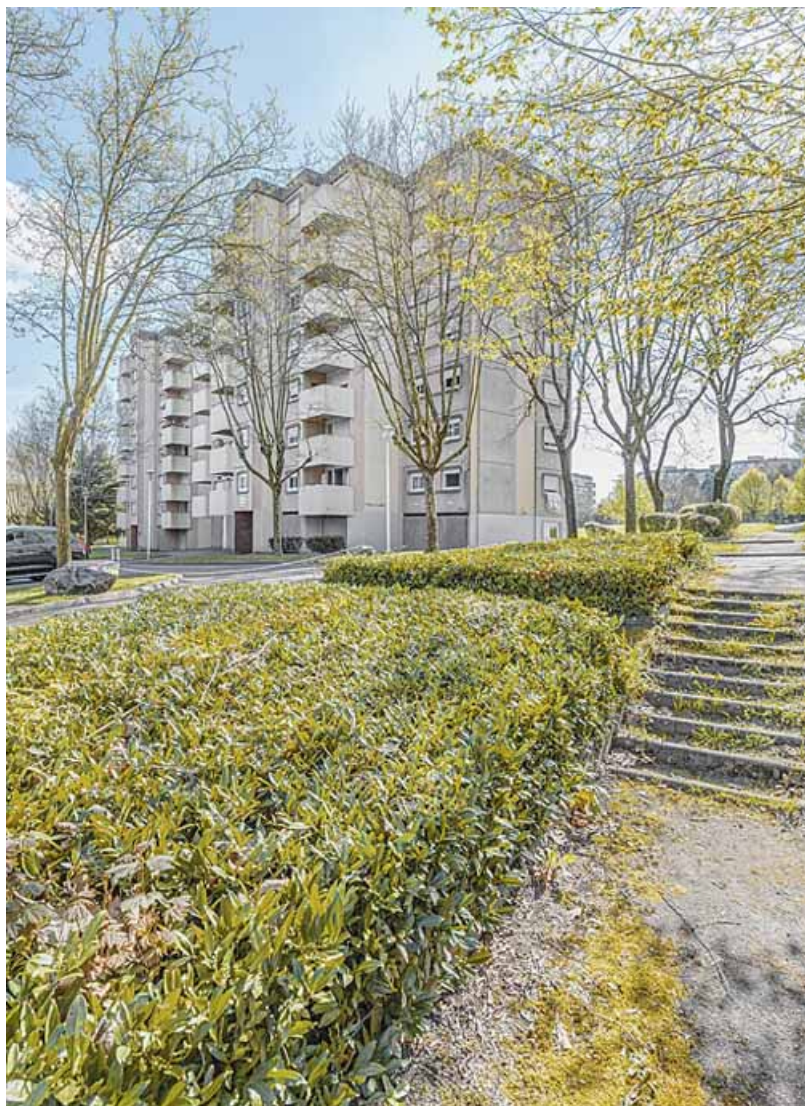
Immeuble modèle régional Redan de la cité Harfleur : façade antérieure et pignon. 71, Le Creusot avenue de Montvaltin
