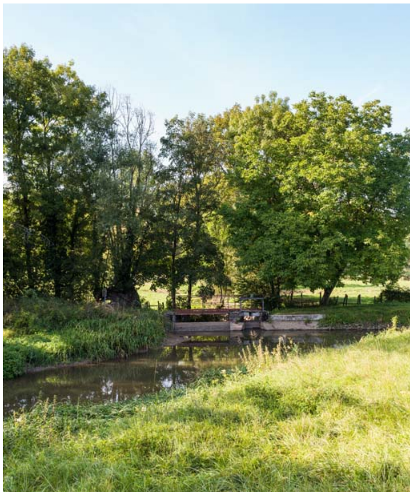
Vue du barrage sur la Dheune, rive gauche.
