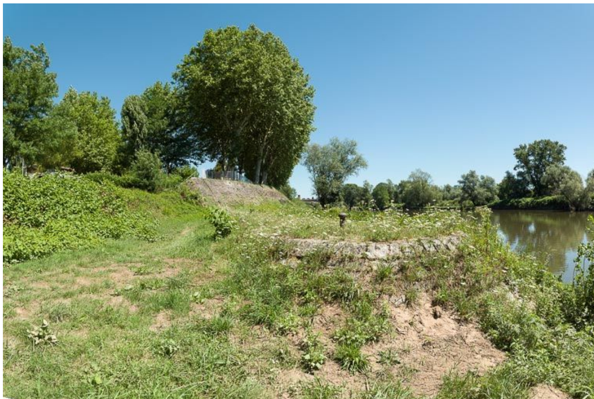
L'ancien bajoyer et la Loire.
