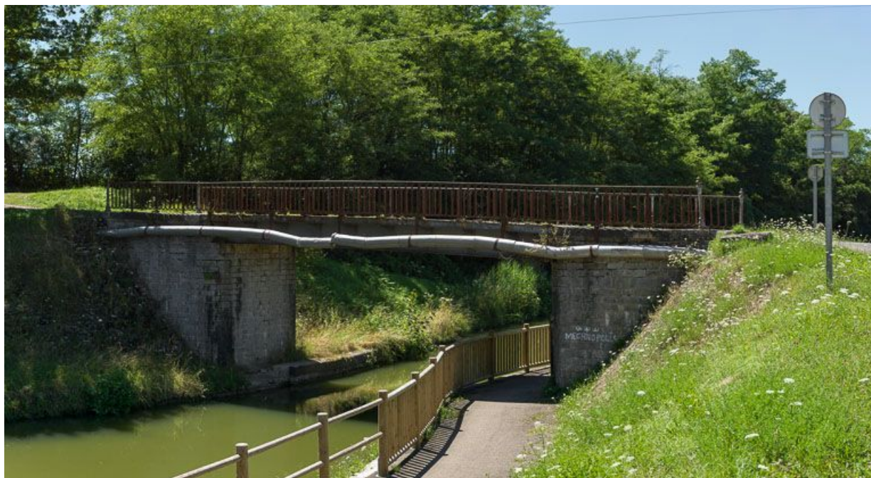
Le pont vu d'amont.
