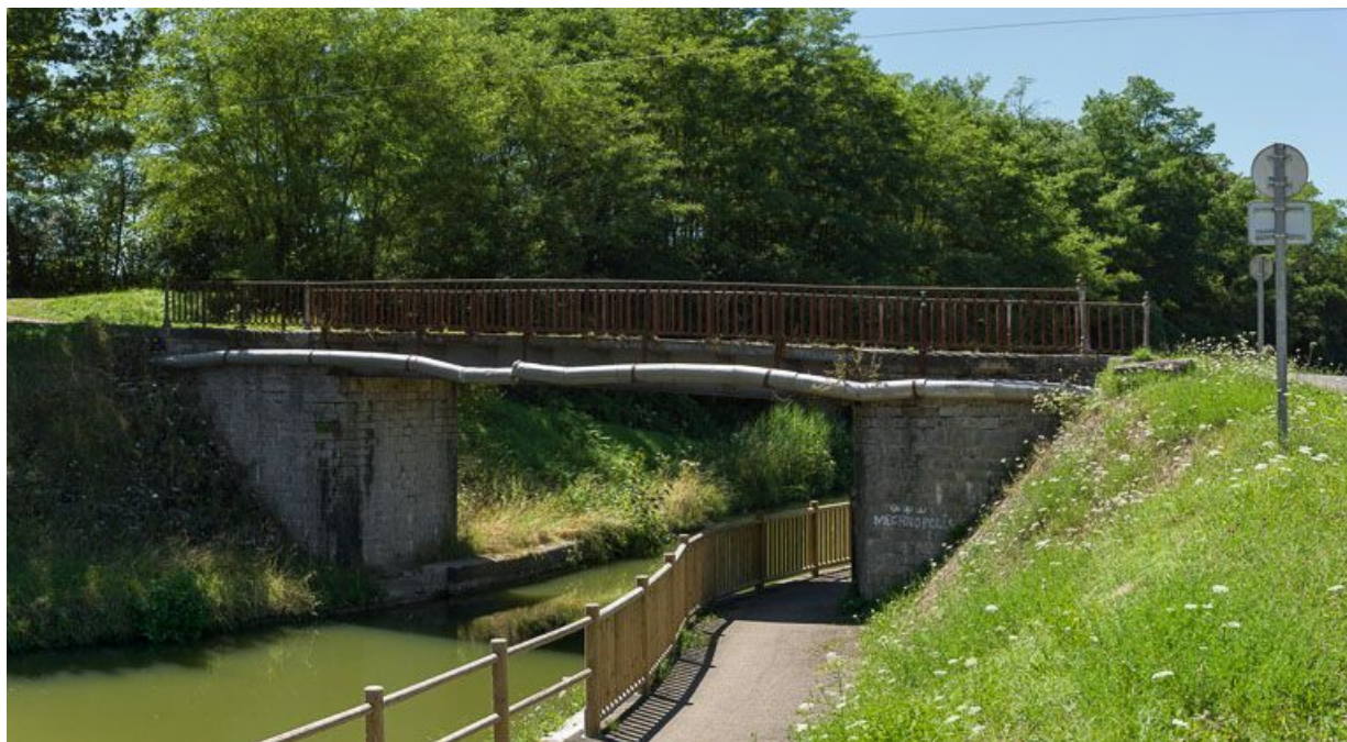
Le pont vu d'amont.
