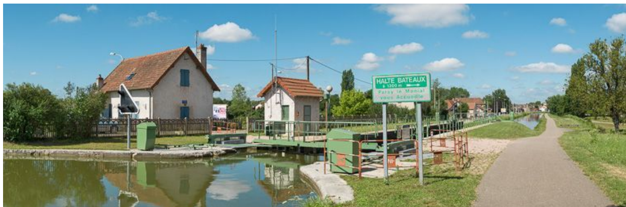
Vue d'ensemble, d'amont. La ville de Paray-le-Monial en arrière-plan.
