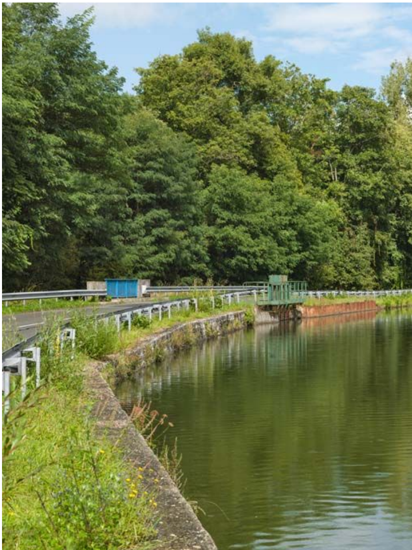
Vue de l'aqueduc et du déversoir à trois vannes. 71, Gévelard, lieudit : bief 15 du versant Loire-Océan
