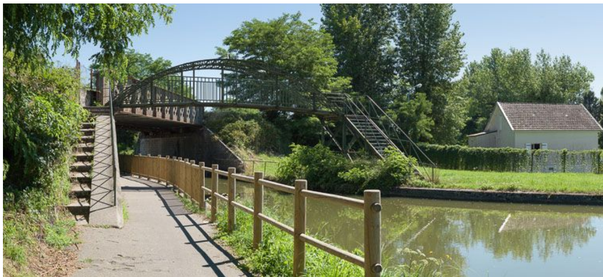
Le pont ferroviaire et la passerelle, vus d'aval.
