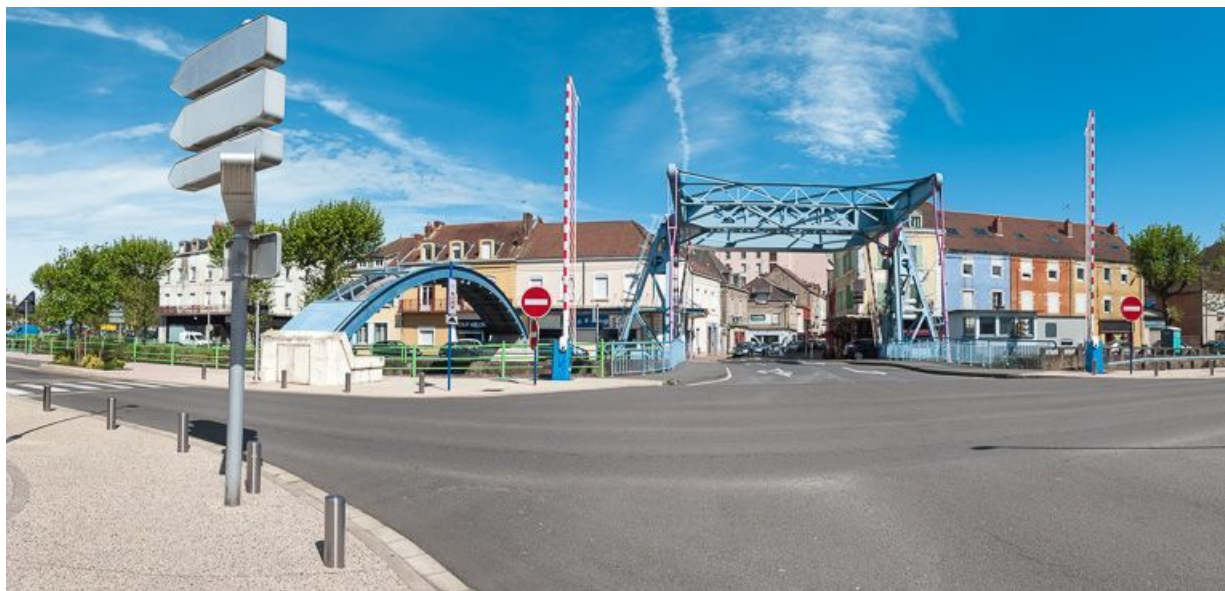
Vue d'ensemble du pont.
