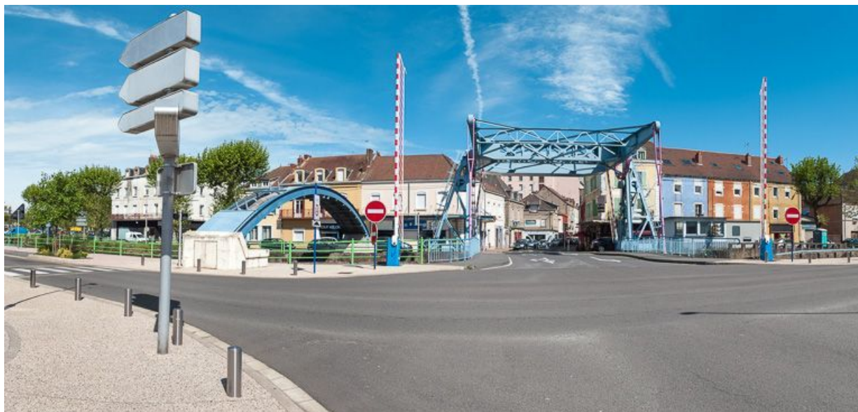
Vue d'ensemble du pont.
