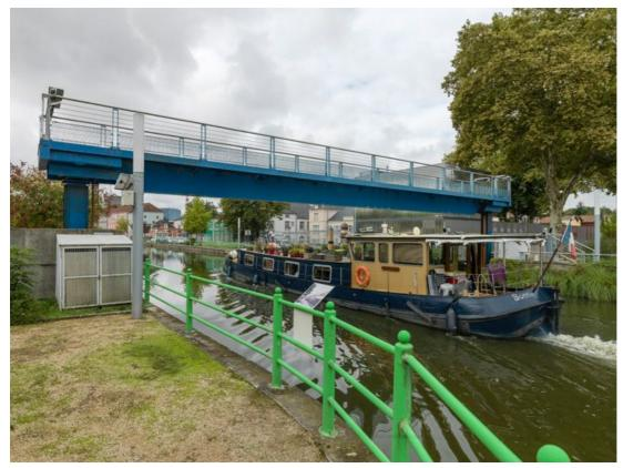
Passerelle remontée pour permettre le passage d'un bateau. 71, Montceau-les-Mines, lieudit : bief 10 du versant Loire-Océan
