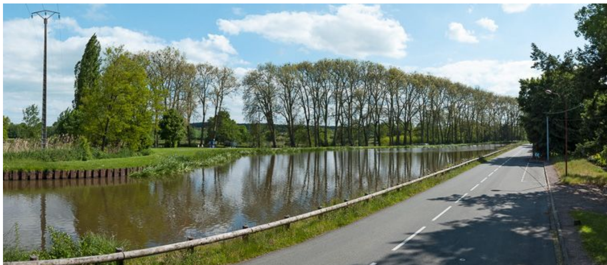
Vue d'ensemble d'amont avec allée de platanes.
