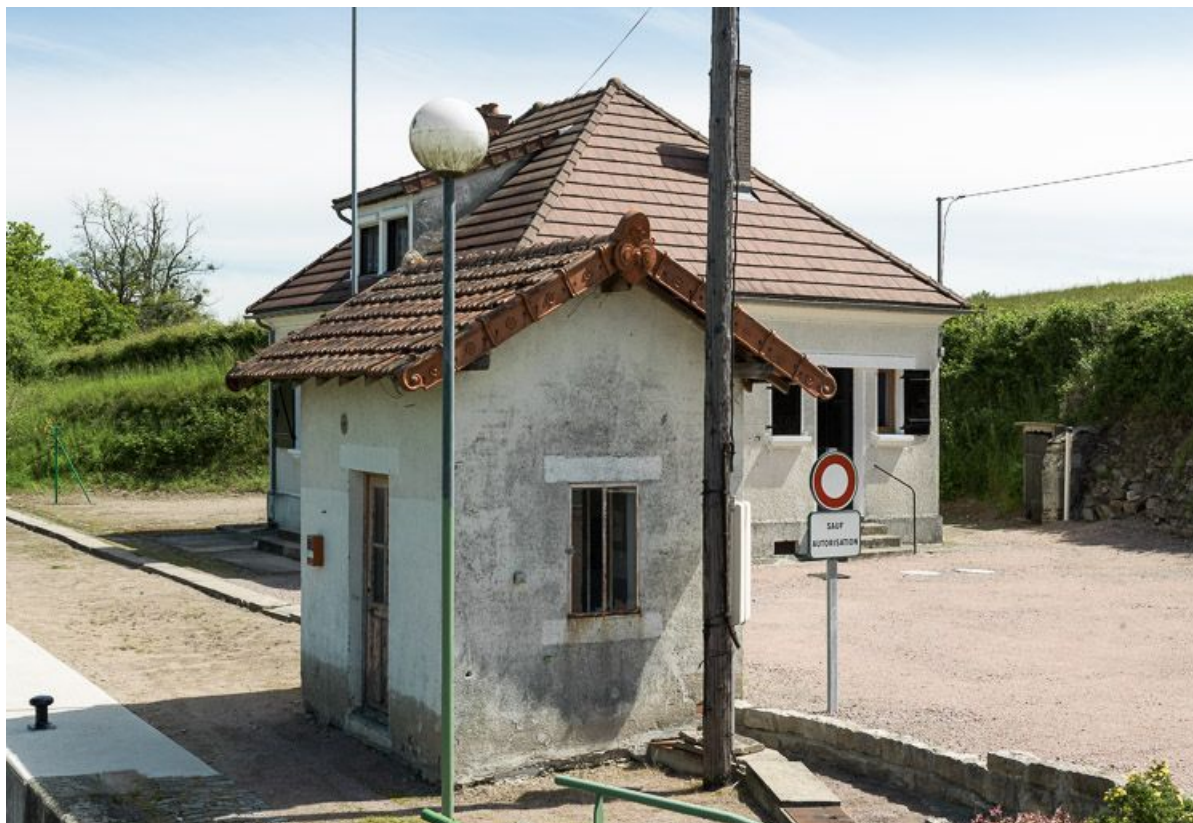
Vue du poste de commande et de la maison éclusière.
