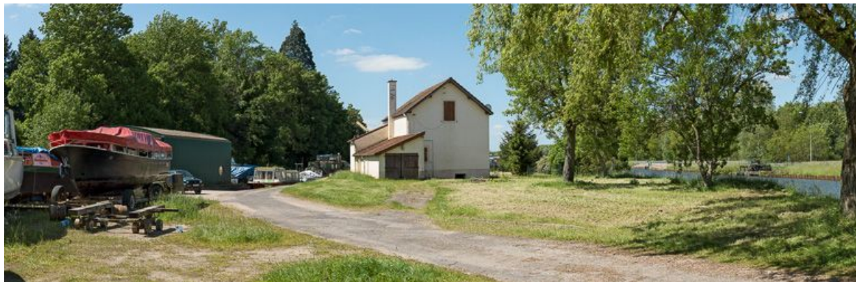
Vue de la façade postérieure de la maison.
