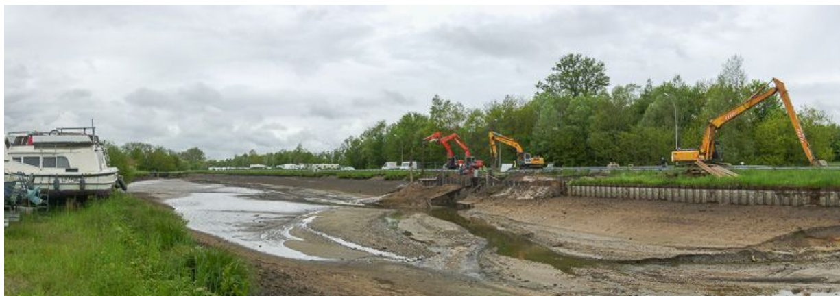
Bief vide au niveau de la halte fluviale de Bois-Bretoux, pendant les travaux de réfection de la chaussée.
