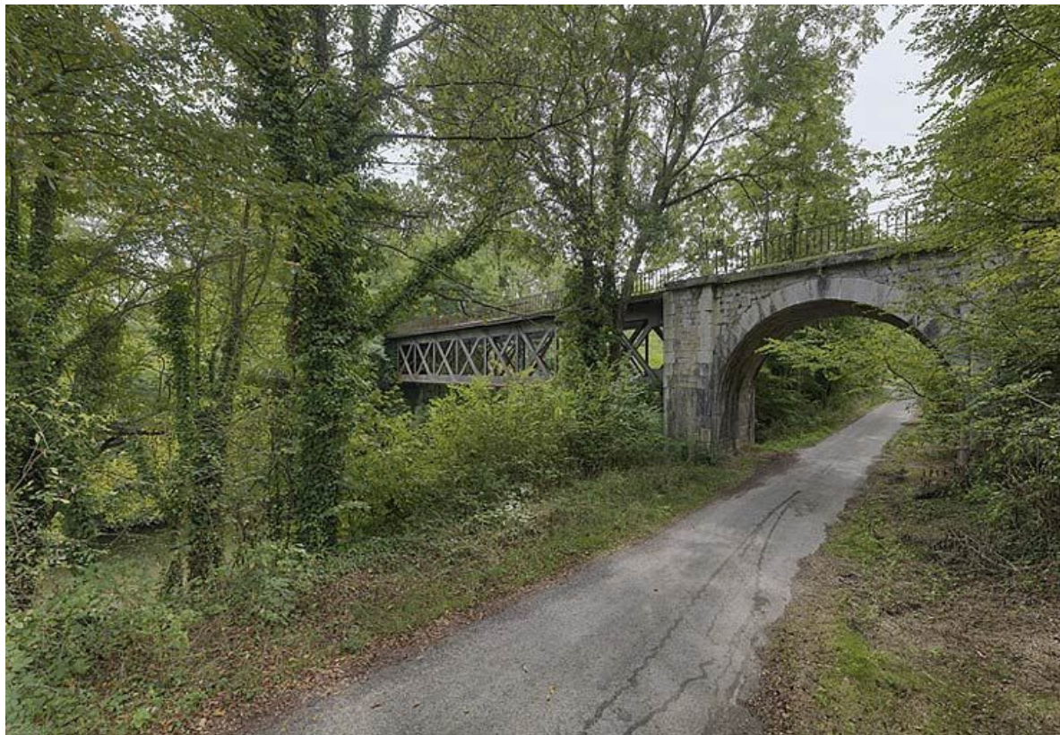
Le pont ferroviaire, avec une partie en maçonnerie enjambant le chemin de halage et une partie en métal enjambant le canal.
