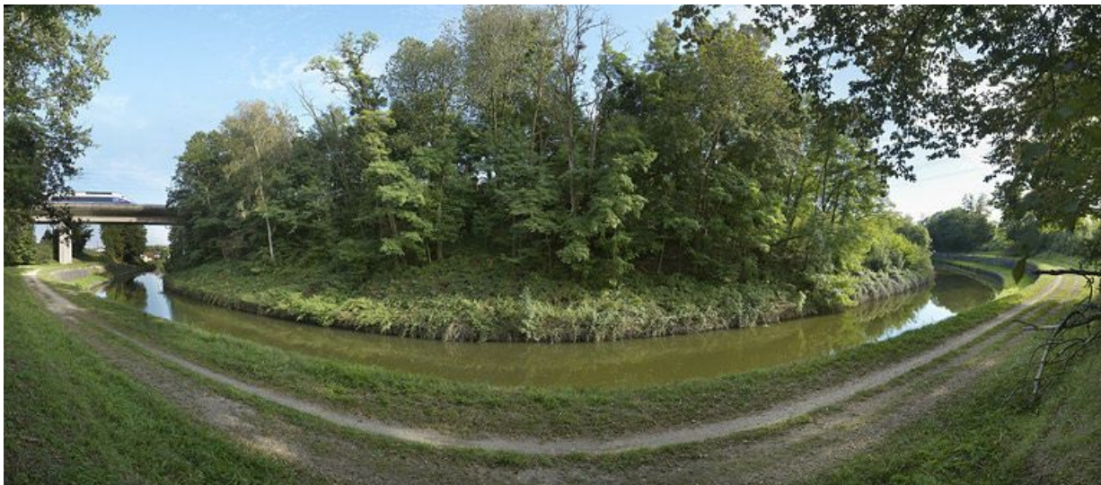
Vue d'ensemble de la tranchée, avec le pont du TGV. A l'arrière-plan le pont du site d'écluse.
